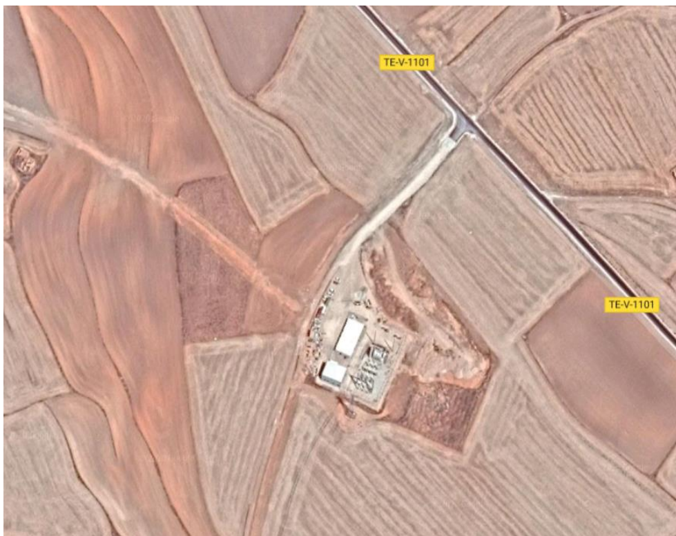
Figura 2: Subestación eléctrica sobre foto aérea
