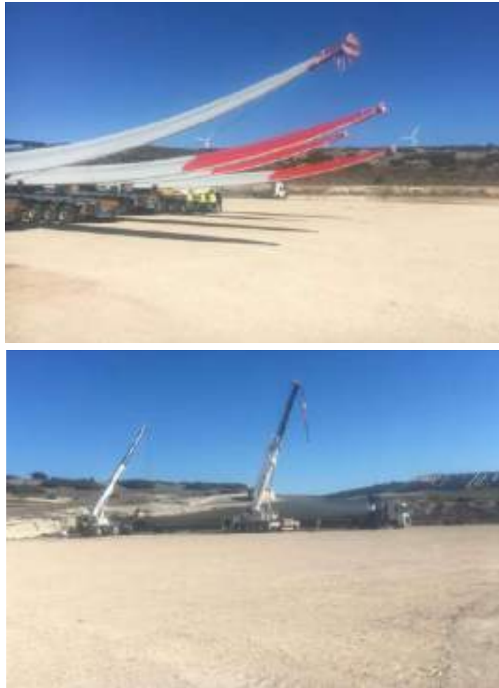
Imagen 3. Zona de acopio con palas de aerogeneradores. UTM: 673.229X 4.575.381Y
