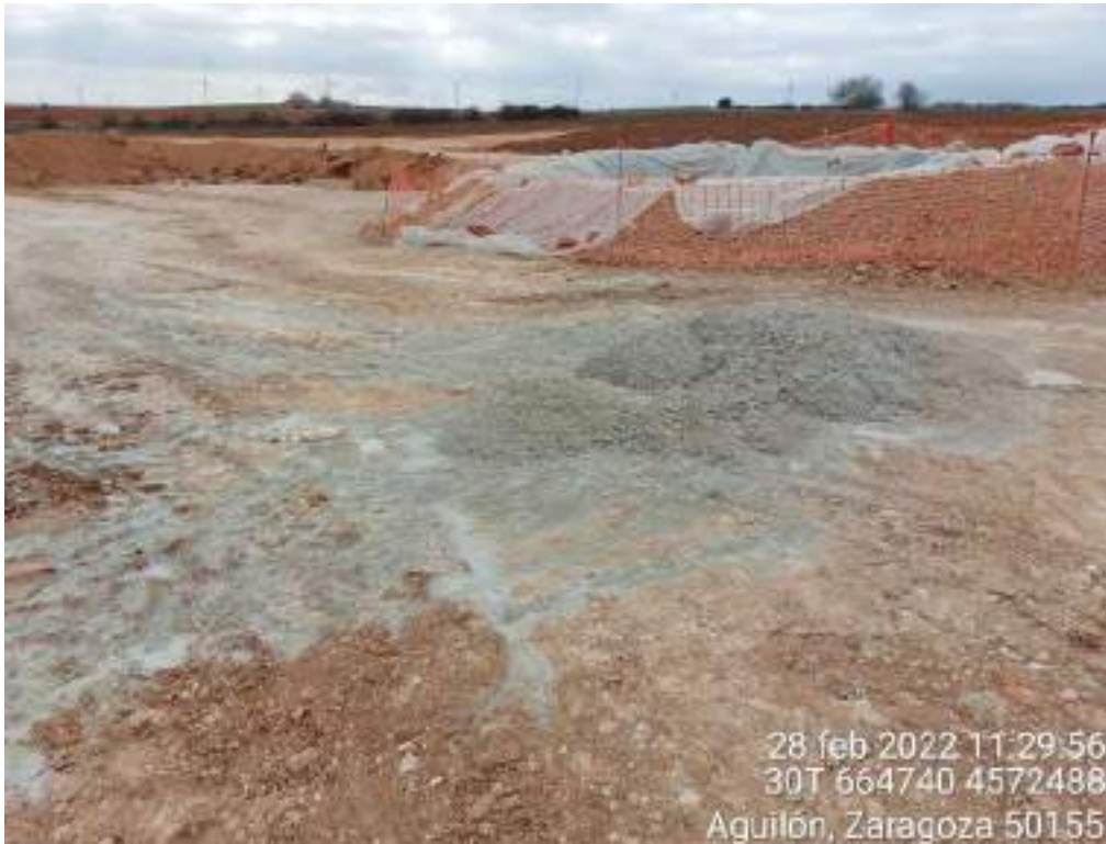
Imagen 1. No conformidad grave. Utilización de zonas de lavado junto con generación de residuo de hormigón pese a su prohibición.
