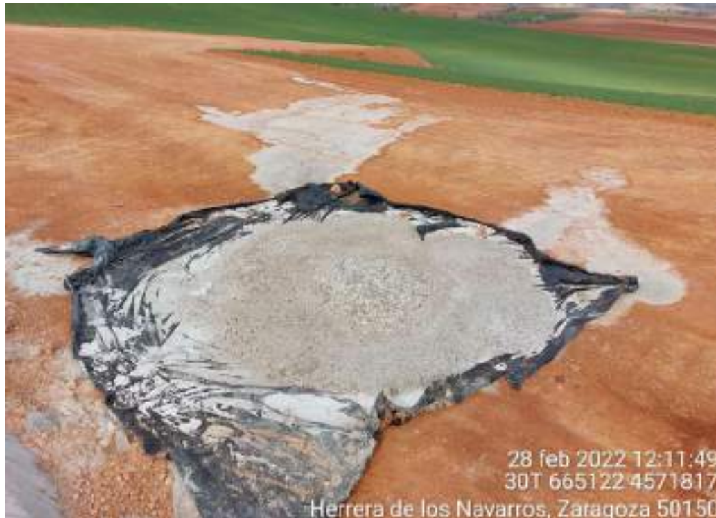
Imagen 4. Residuo de hormigón en SBII-05
