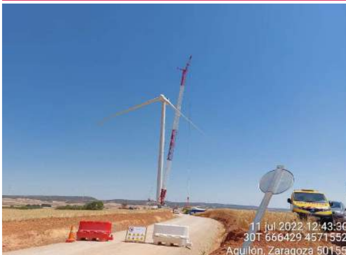
Imagen 1. Montaje del aerogenerador SBII-10.
