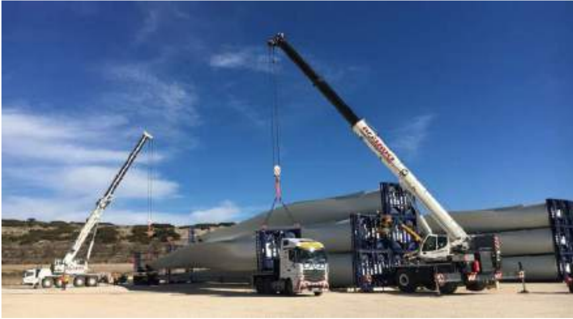
Imagen 5. Zona de acopio de material
