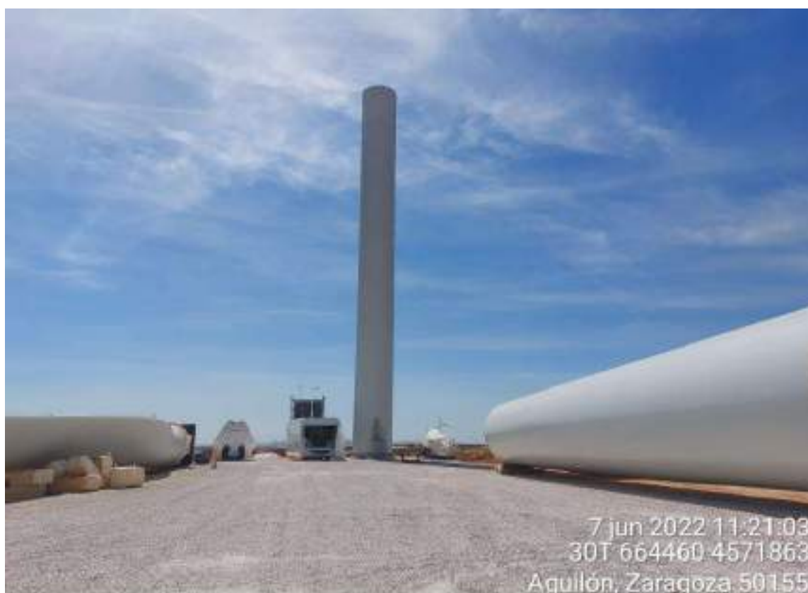
Imagen 1. Montaje del aerogenerador
