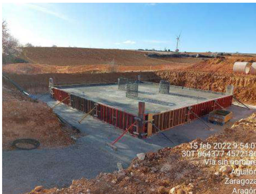
Imagen 4. Hormigonado de la torre de medición
