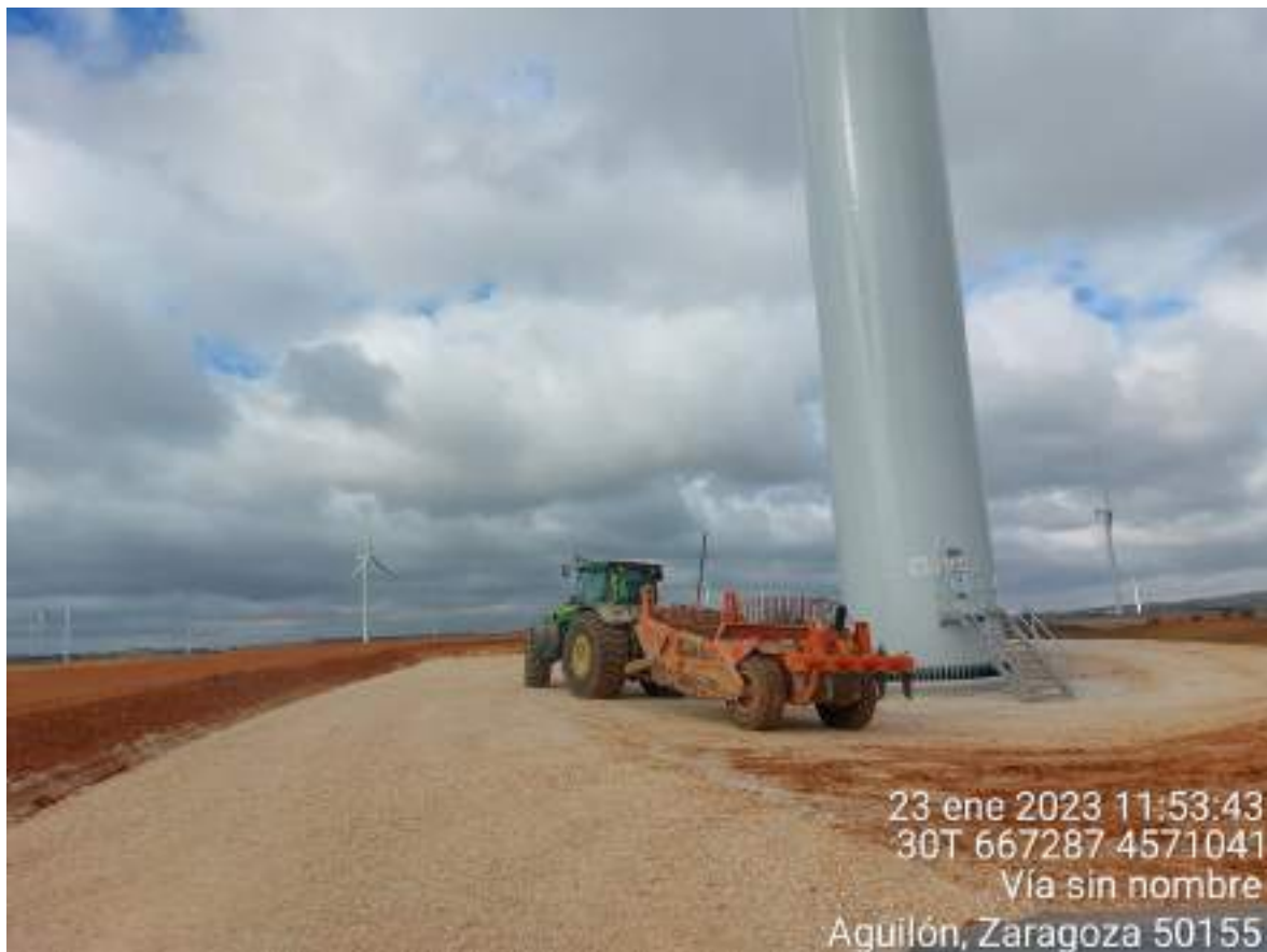
Imagen 2. Maquinaria realizando trabajos de restauración en PLX-02
