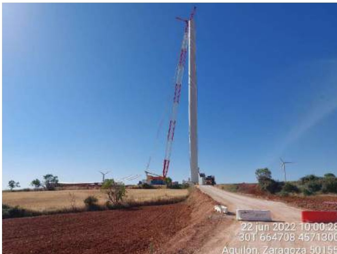
Imagen 1. Montaje de un aerogenerador
