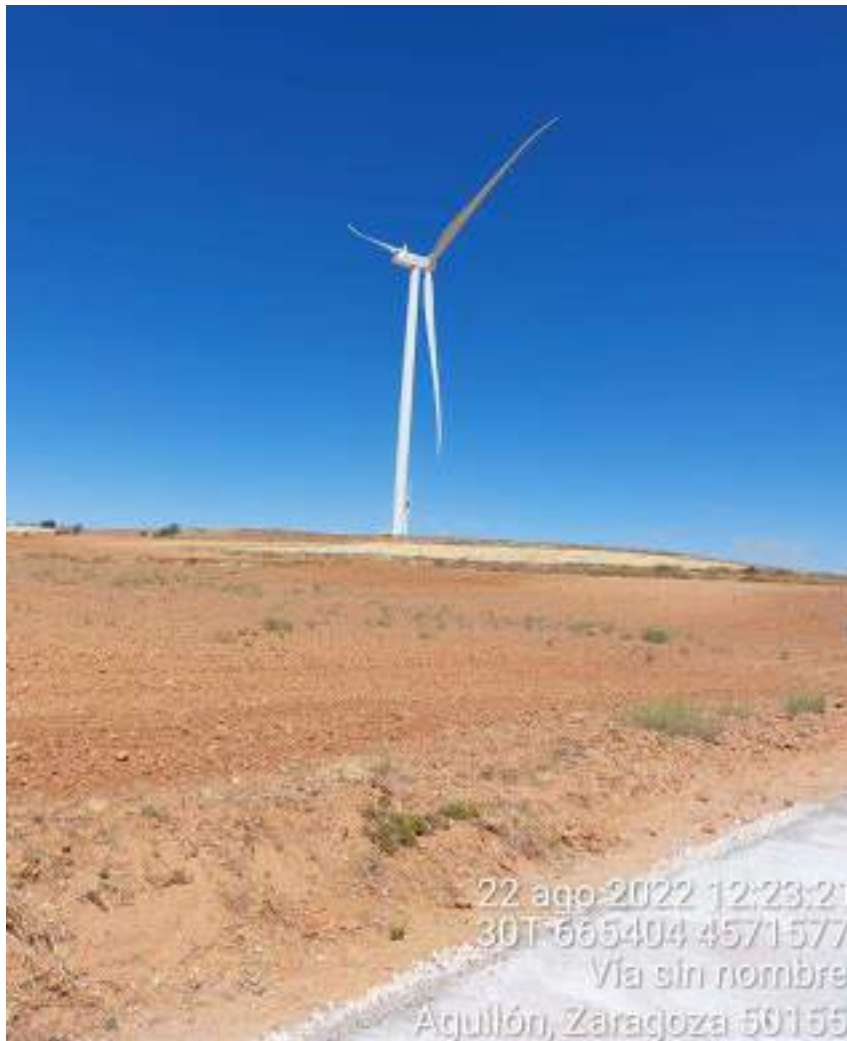
Imagen 1. Vista del aerogenerador SBII-02.
