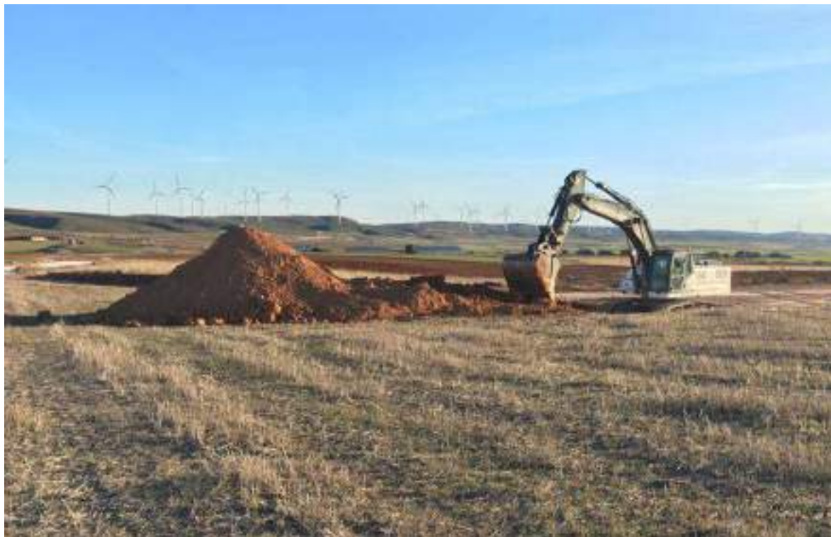
Imagen 1. Retroexcavadora trabajando en SBII-02
