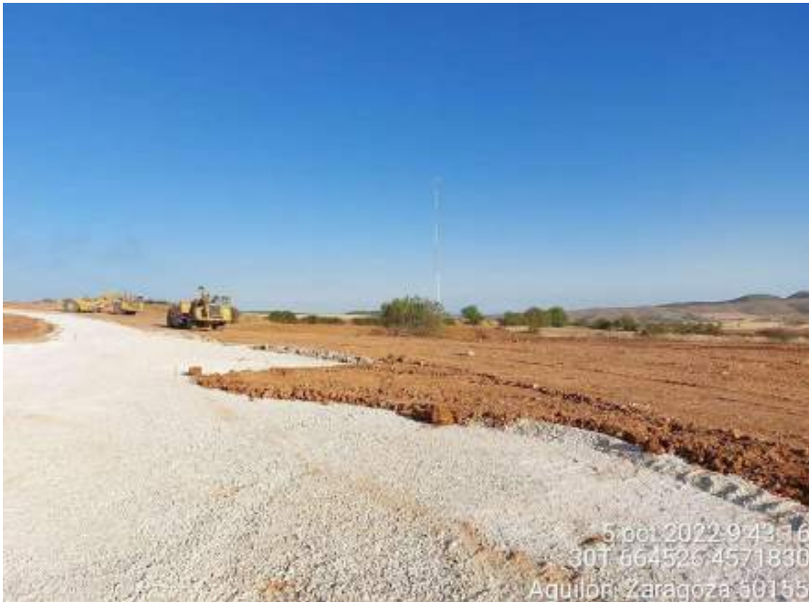
Imagen 3. Maquinaria realizando la restauración ambiental de SBII-03.
