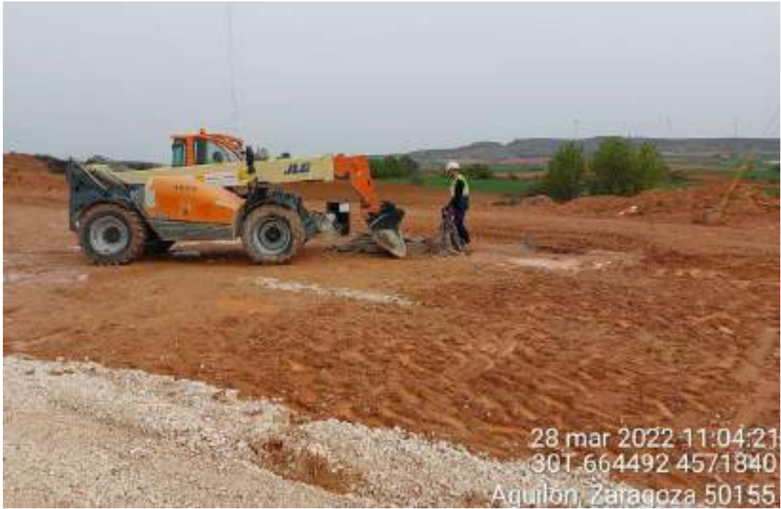
Imagen 4. Máquina recogiendo plástico con restos de residuos de hormigón.
