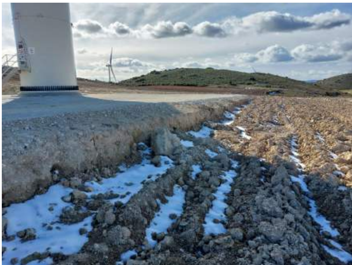
Imagen 3. Posición SBI-04 tras finalizar la restauración. Se debe reducir el salto que hay entre plataforma y campo de cultivo creando una pendiente gradual.
