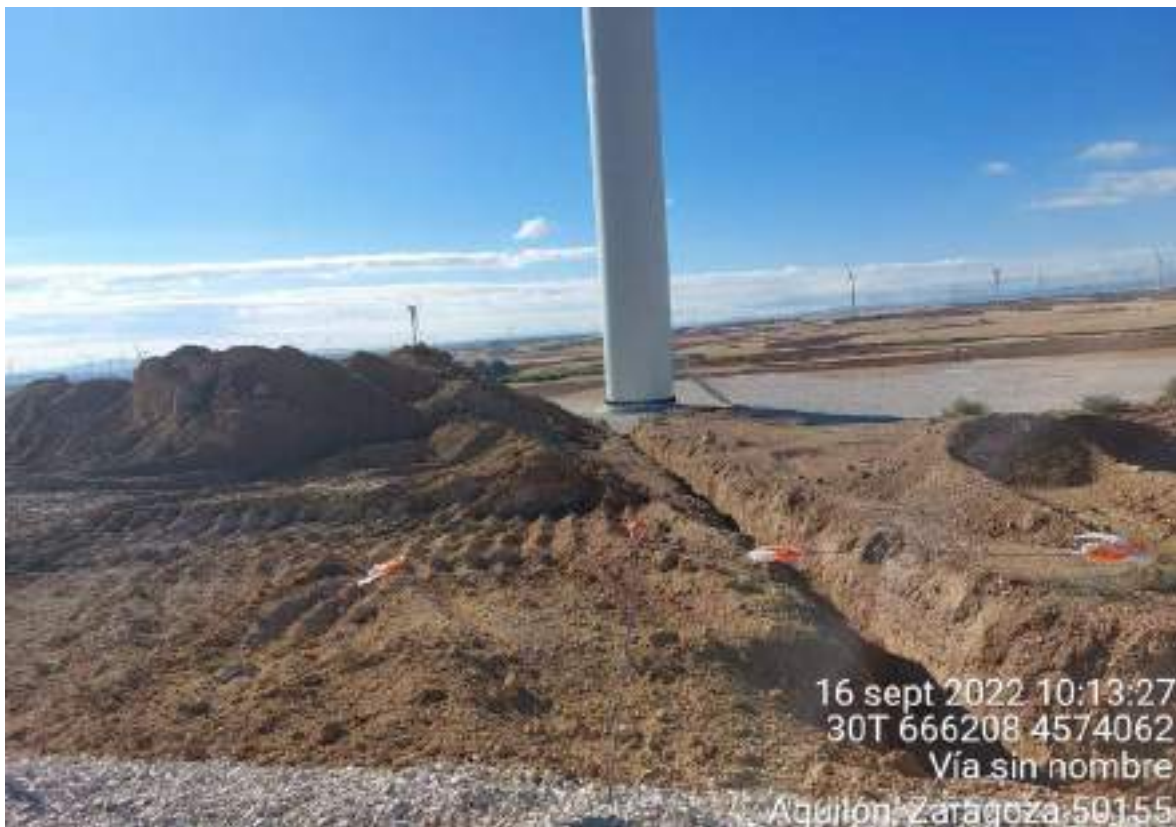
Imagen 2. Movimiento de tierras en excavado de zanja en SB1-03.
