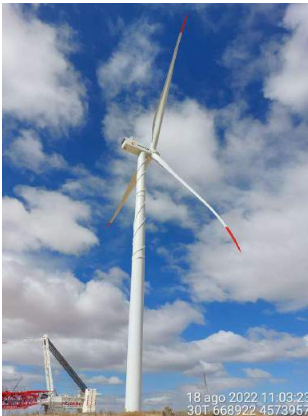
Imagen 2. Aerogenerador en fase de montaje.
