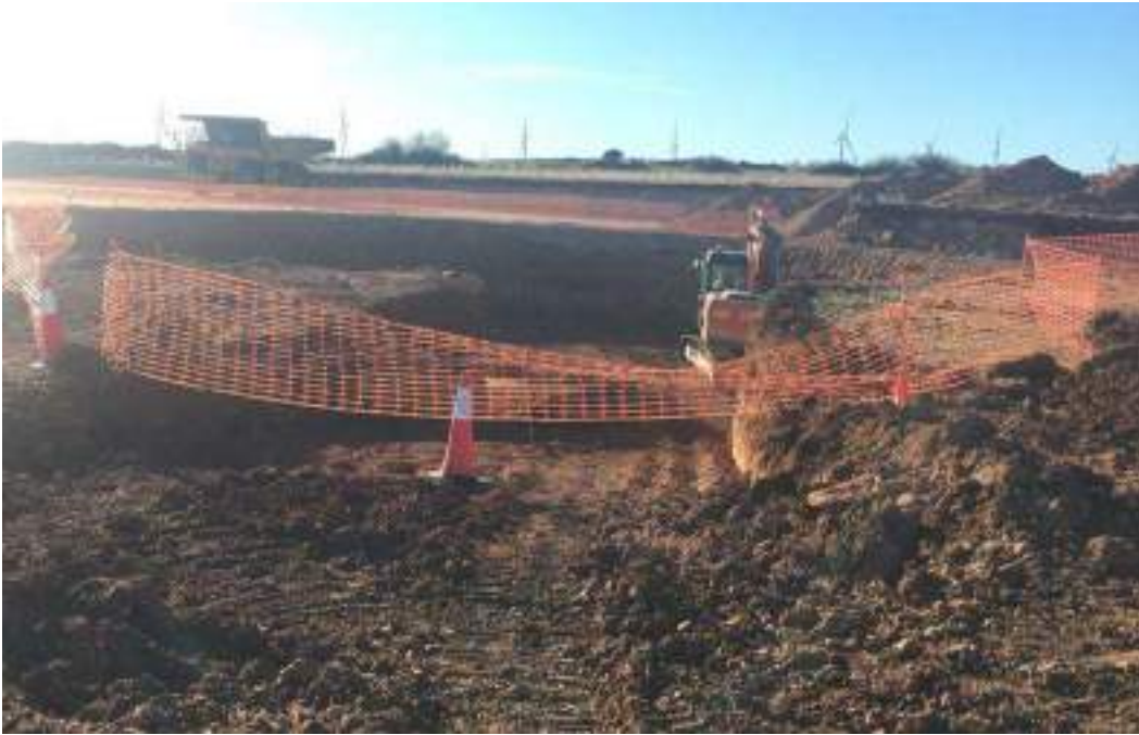
Imagen 2. Excavación zapata SBII-02
