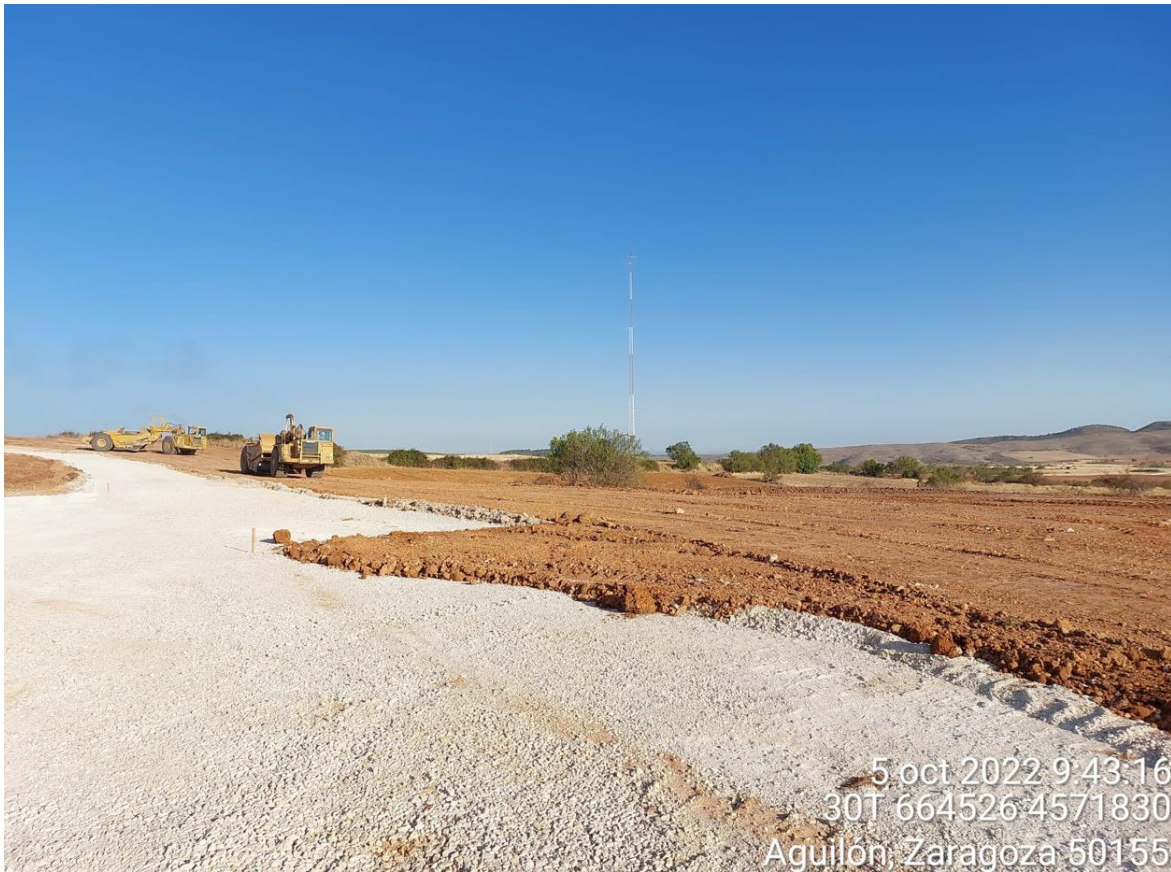
Imagen 3. Maquinaria realizando la restauración ambiental de SBII-03.
