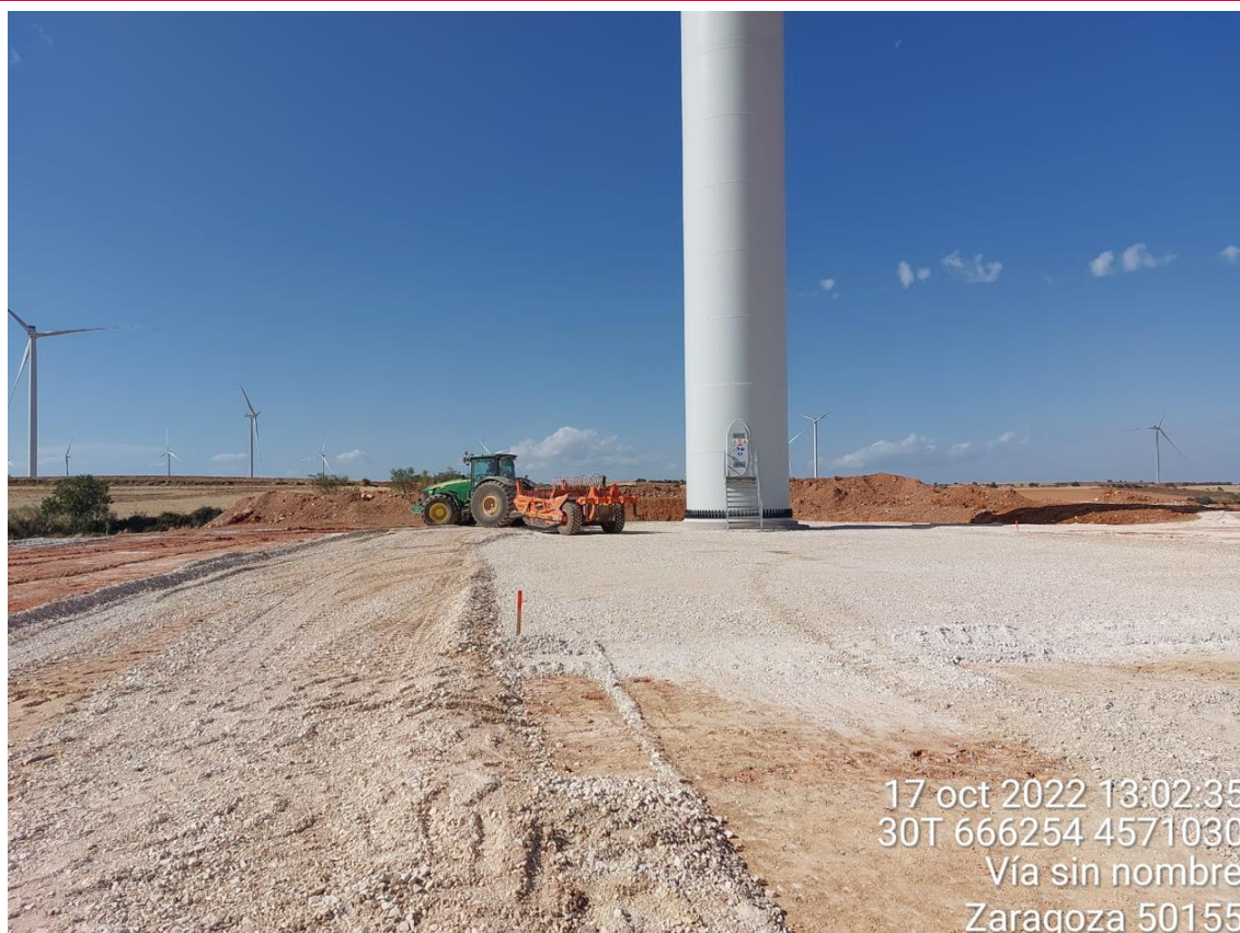
Imagen 3. Maquinaria trabajando en la restauración ambiental de la posición SBII-06.
