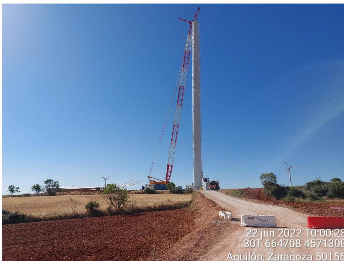
Imagen 1. Montaje de un aerogenerador
