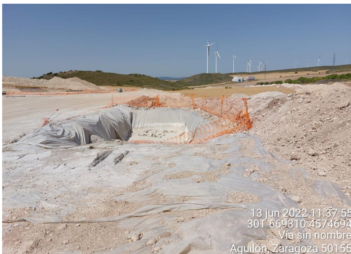
Imagen 1. Pozo de lavado utilizado en hormigonado.
