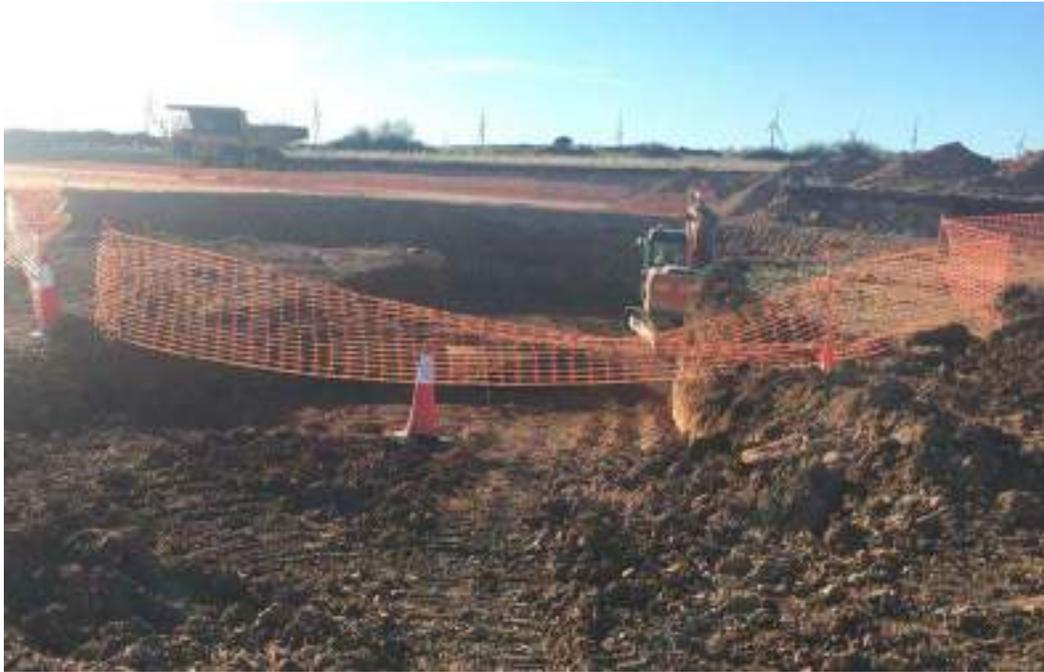
Imagen 2. Excavación zapata SBII-02
