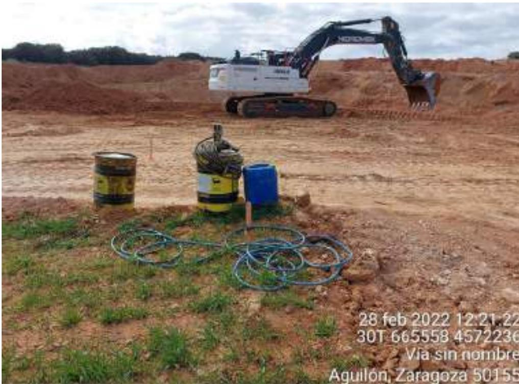
Imagen 2. No conformidad grave. Abandono de bidones sin protección del suelo.
