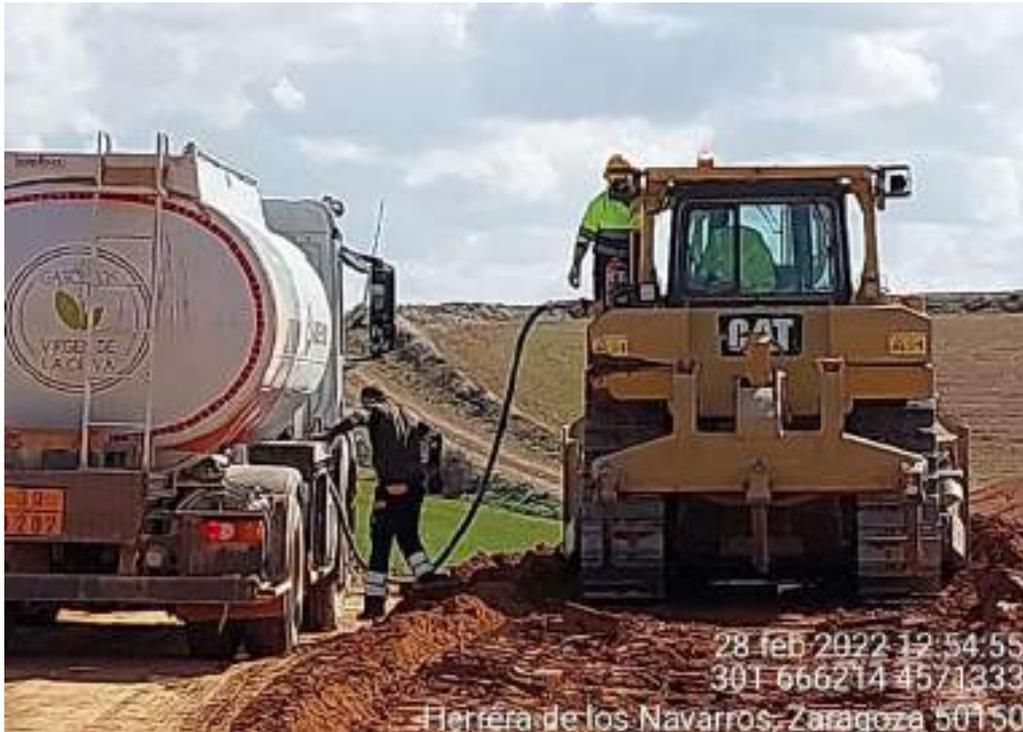
Imagen 3. No conformidad leve. Llenado de depósito de maquinaria sin protección del suelo.
