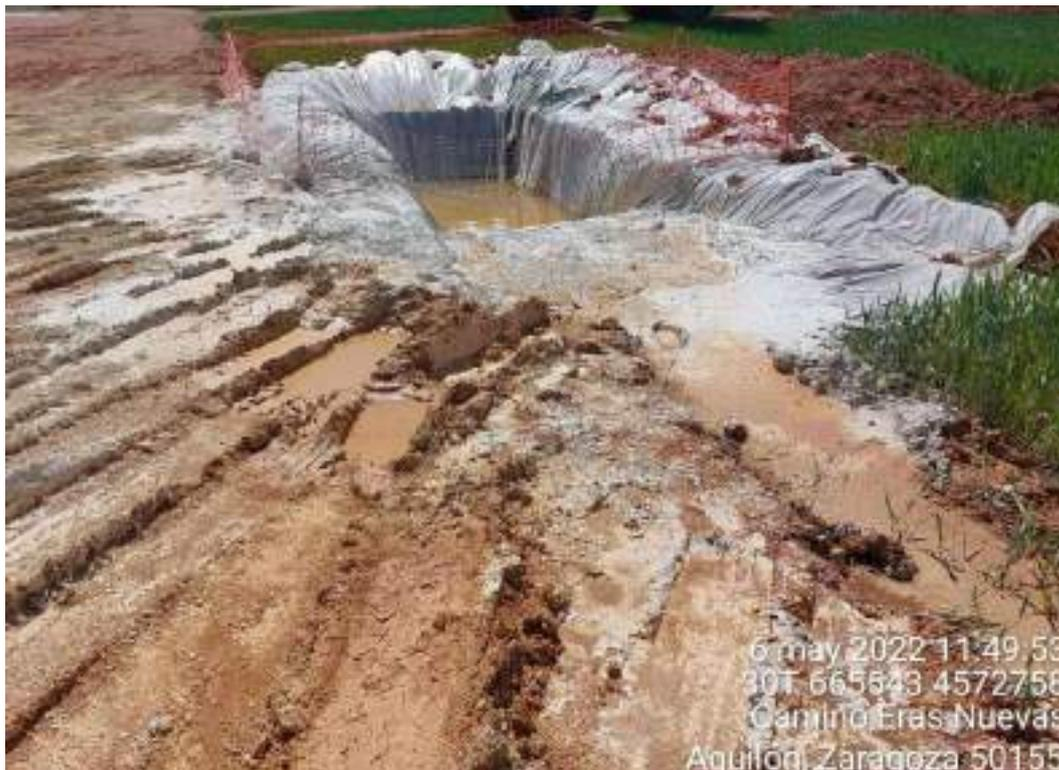
Ilustración 2. Pozo de lavado de SBI-7. Se consigue impermeabilizar el suelo del pozo, pero se contamina el suelo de la zona inmediata al pozo así como del cultivo. Se debe corregir y evitar situaciones así.
