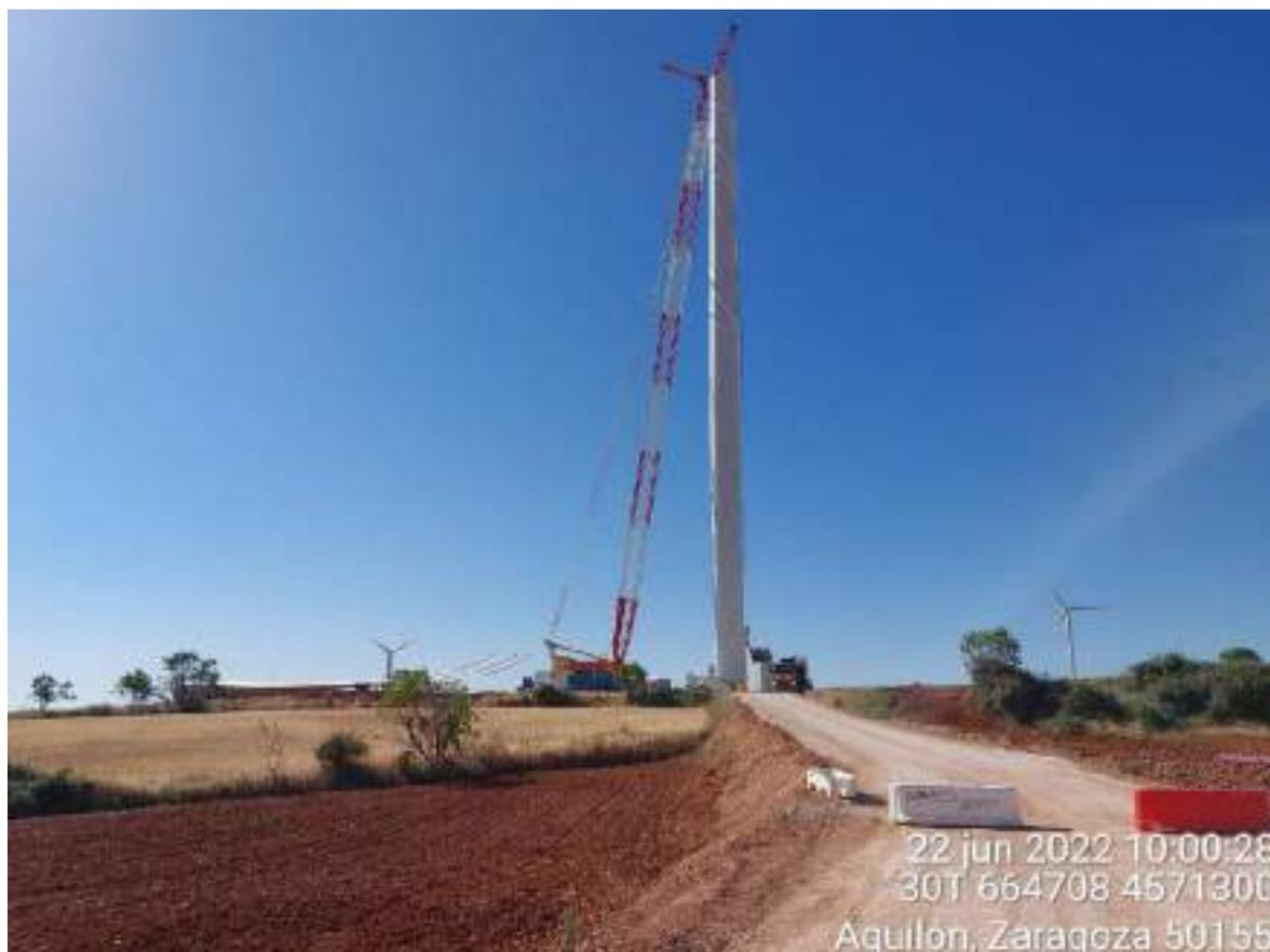
Imagen 1. Montaje de un aerogenerador
