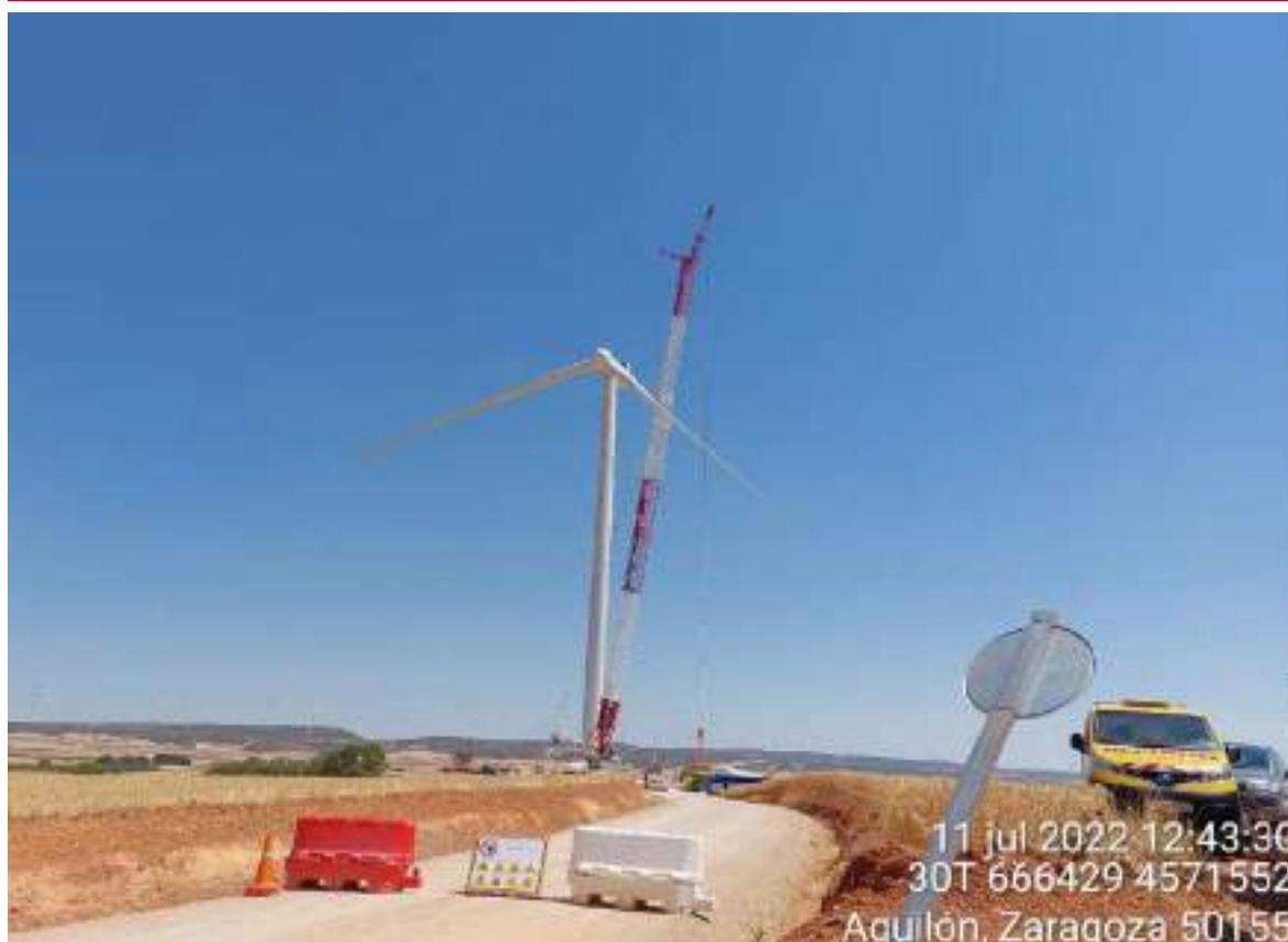
Imagen 1. Montaje del aerogenerador SBII-10.
