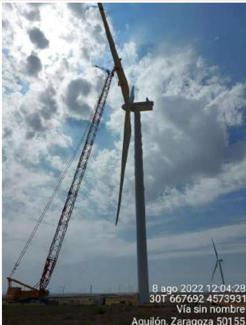
Imagen 3. Montaje aerogenerador.
