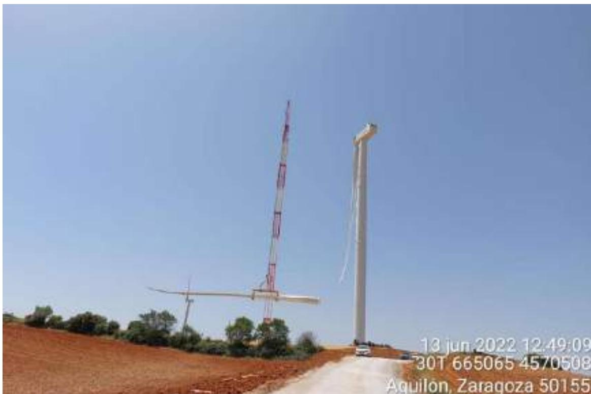
Imagen 3. Montaje del aerogenerador SB2-07.
