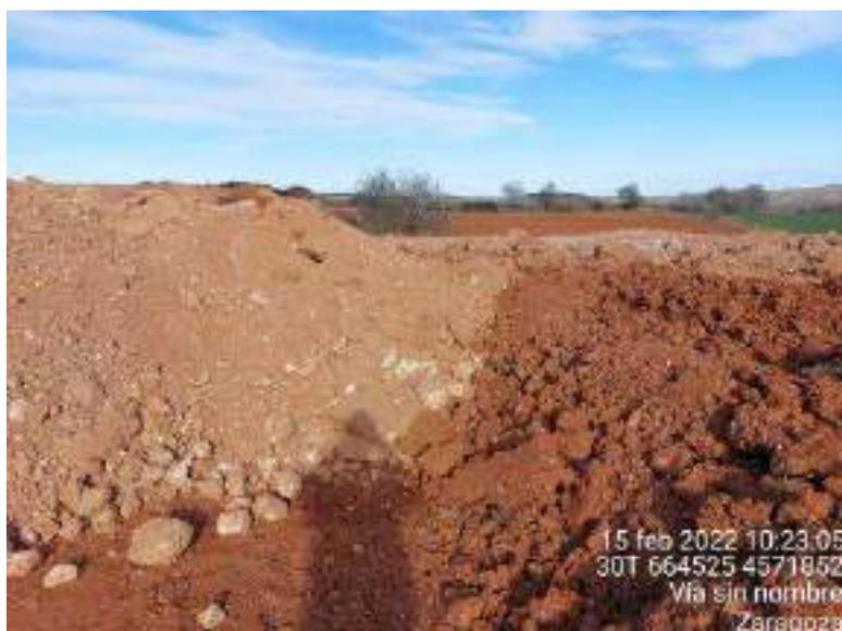
Imagen 2. Posible contaminación de la tierra vegetal. Recomiendo de nuevo balizar los cordones de tierra vegetal para lograr una separación segura y eficiente.
