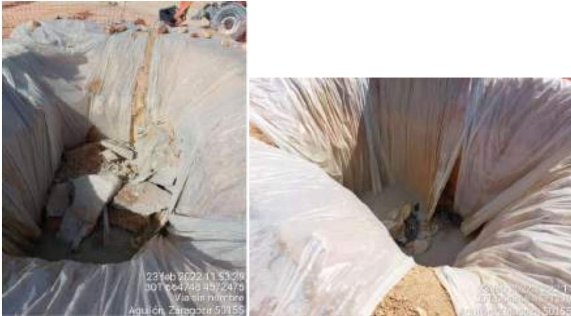
Imagen 1. No conformidad leve. Zonas de lavado con el suelo desprotegido en SBII-02 y SBII-04 con signos de utilización
