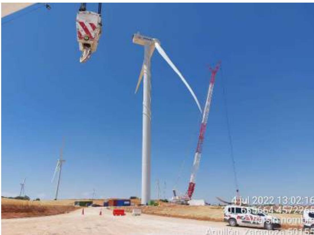
Ilustración 2. Montaje del aerogenerador SBII-06.
