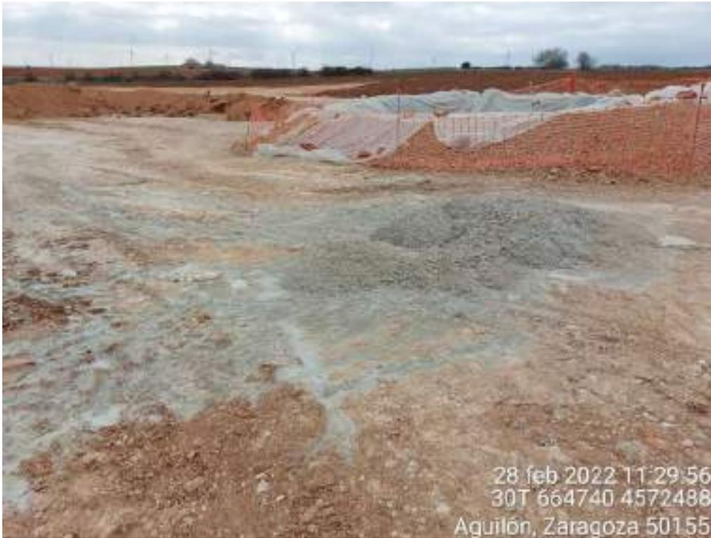
Imagen 1. No conformidad grave. Utilización de zonas de lavado junto con generación de residuo de hormigón pese a su prohibición.
