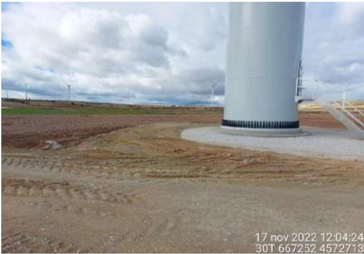
Imagen 3. Plataforma SBI-9 como ejemplo de que falta nivelar y eliminar las roderas existentes en la mayoría de las posiciones.
