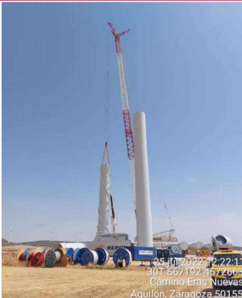
Imagen 2. Montaje del aerogenerador SB1-09
