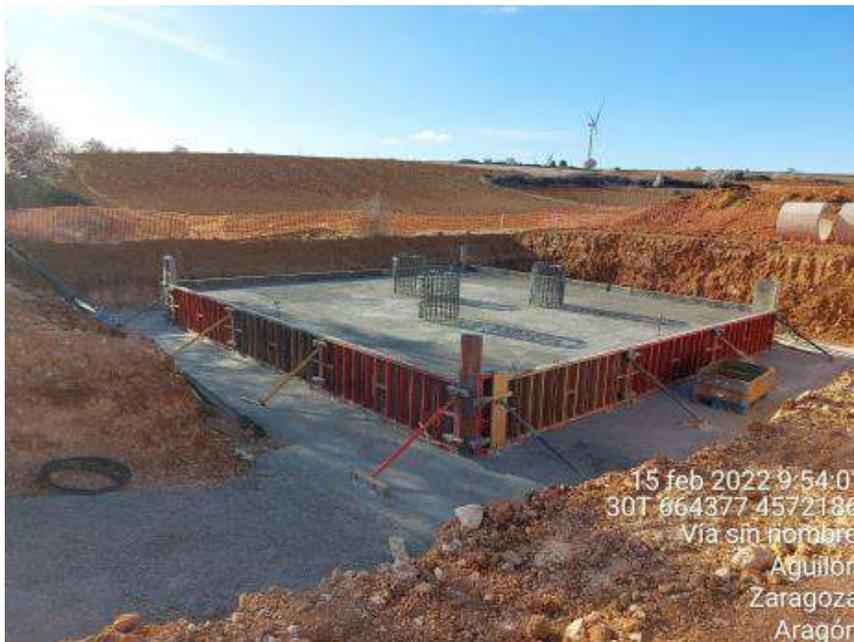
Imagen 4. Hormigonado de la torre de medición
