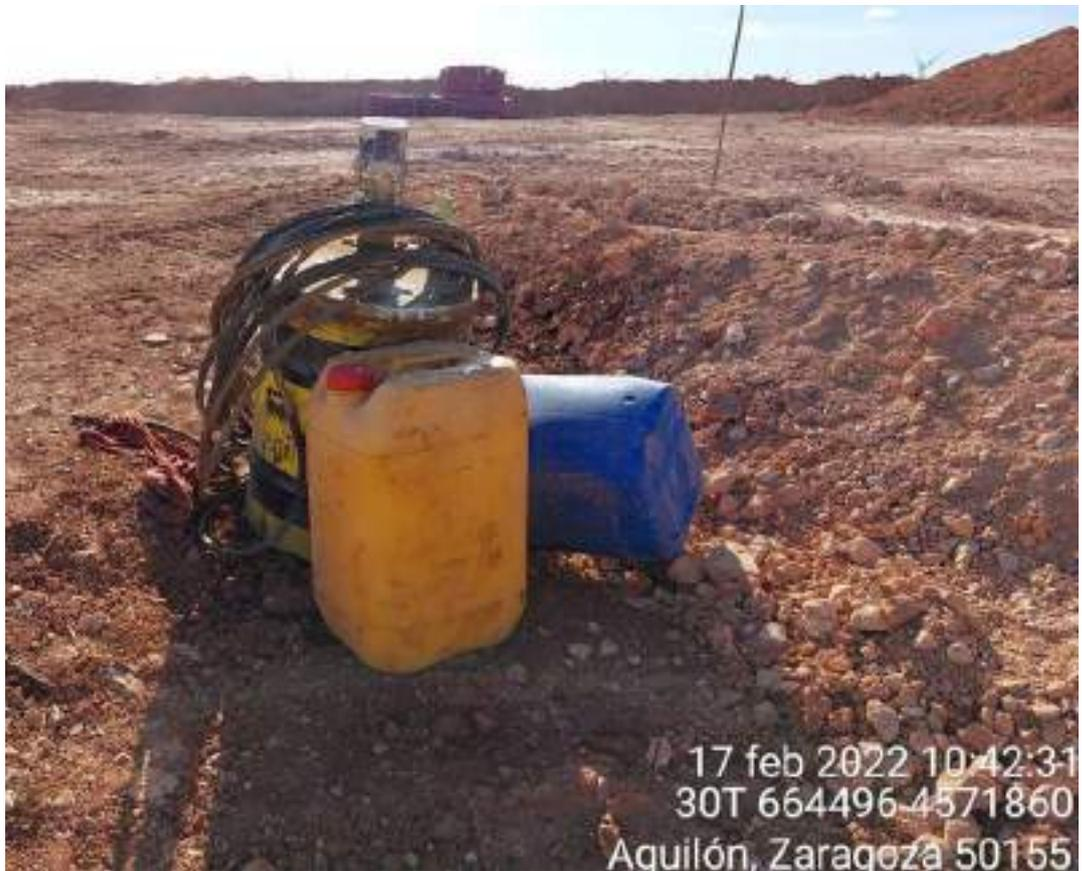
Imagen 3. Bidones de hidráulico y manguera sin protección al suelo en SBII-03
