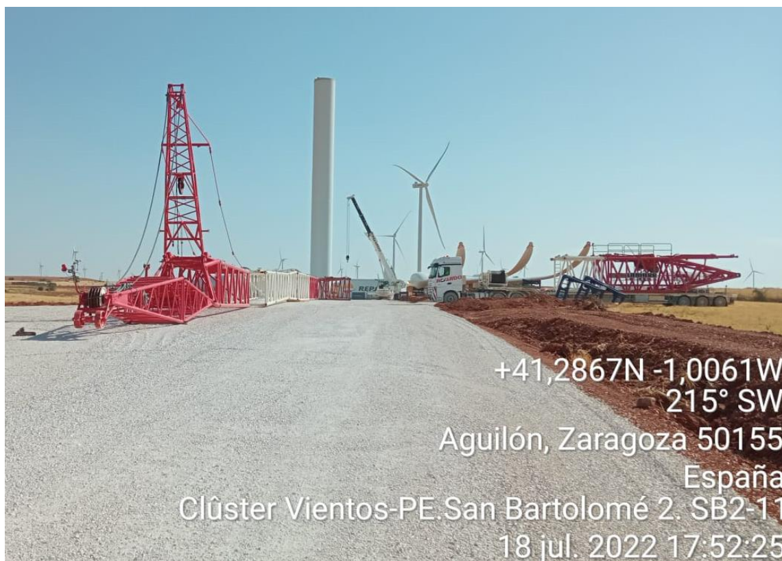
Imagen 2. Trabajos en plataforma de SB2-11
