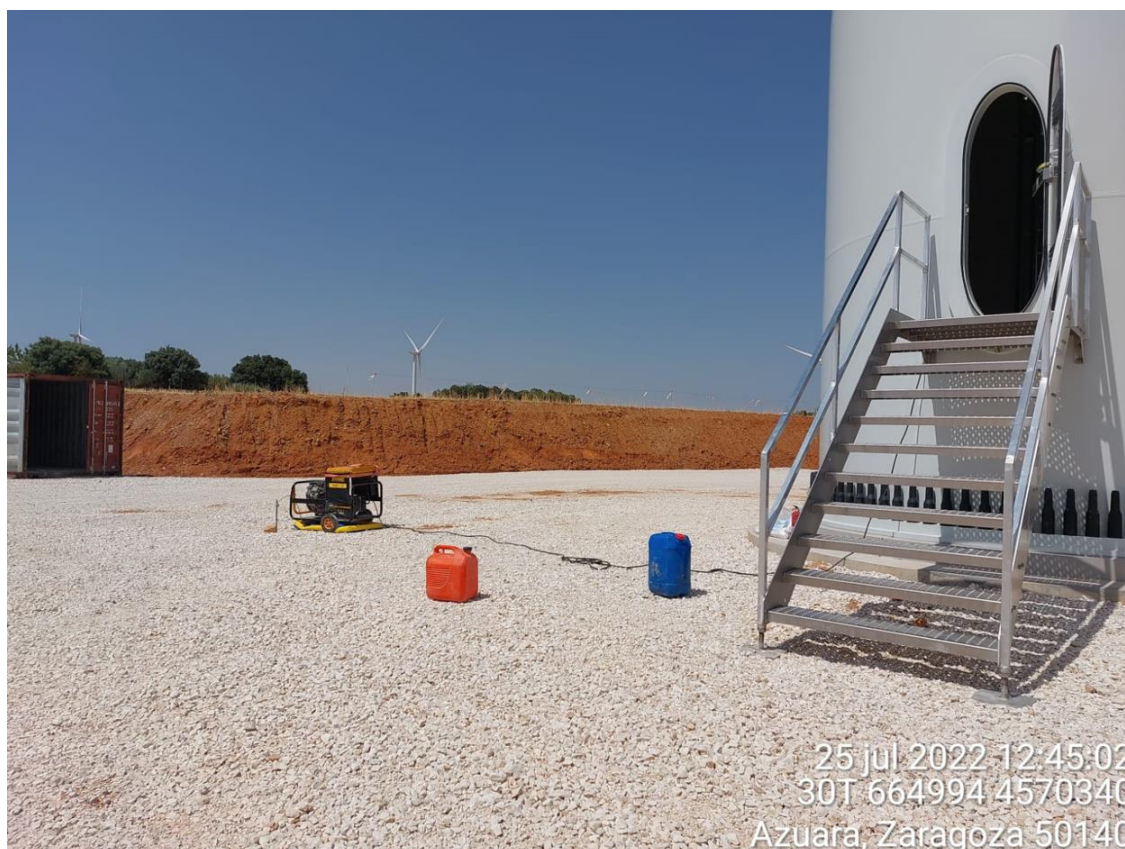
Imagen 1. Bidones sobre el suelo sin cubeto de contención.
