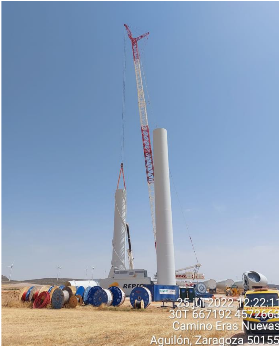
Imagen 2. Montaje del aerogenerador SB1-09
