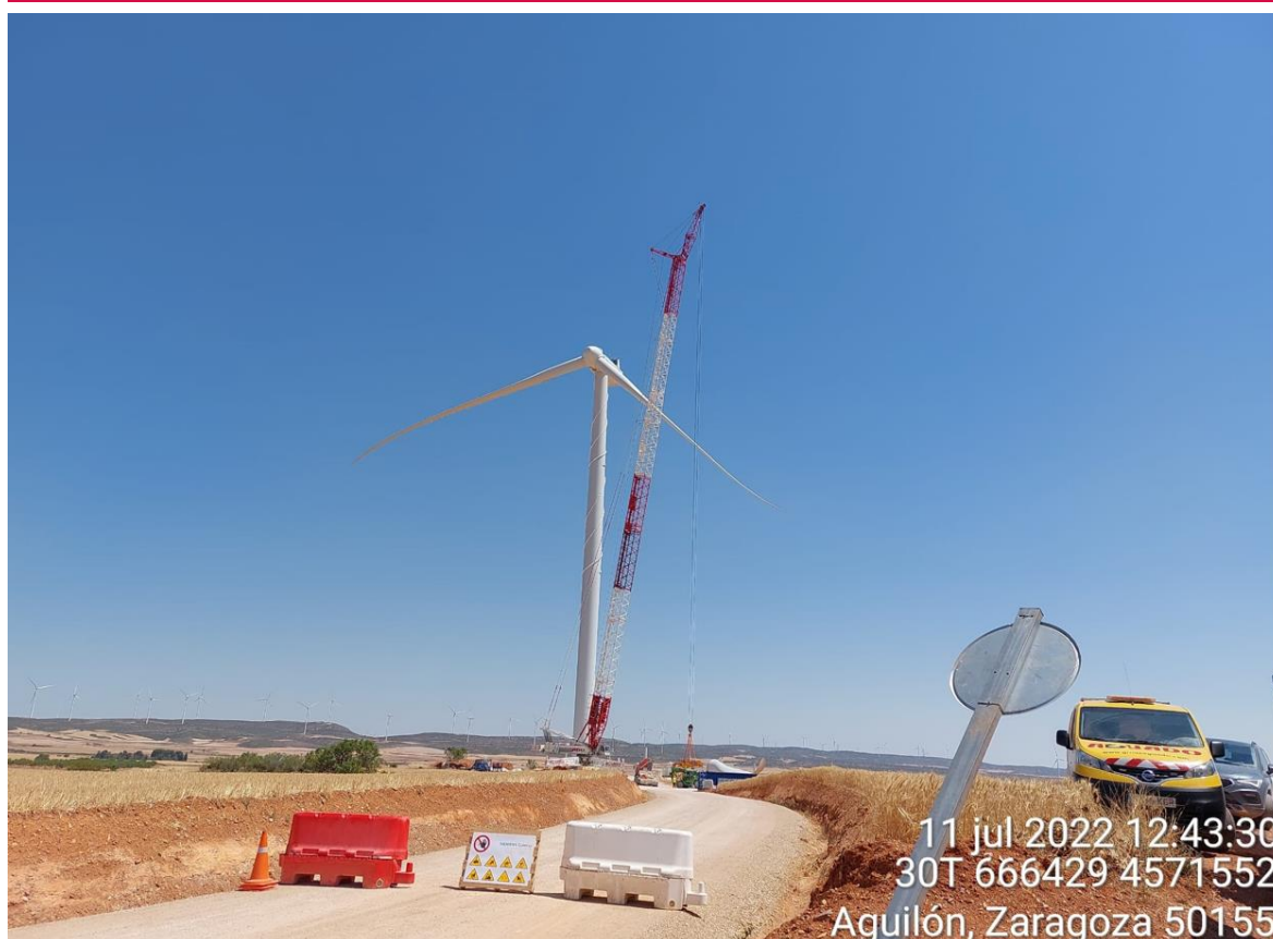
Imagen 1. Montaje del aerogenerador SBII-10.
