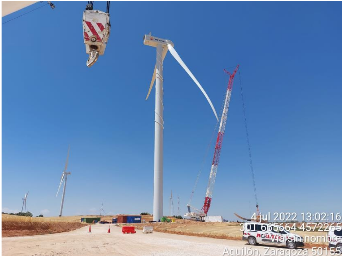
Ilustración 2. Montaje del aerogenerador SBII-06.
