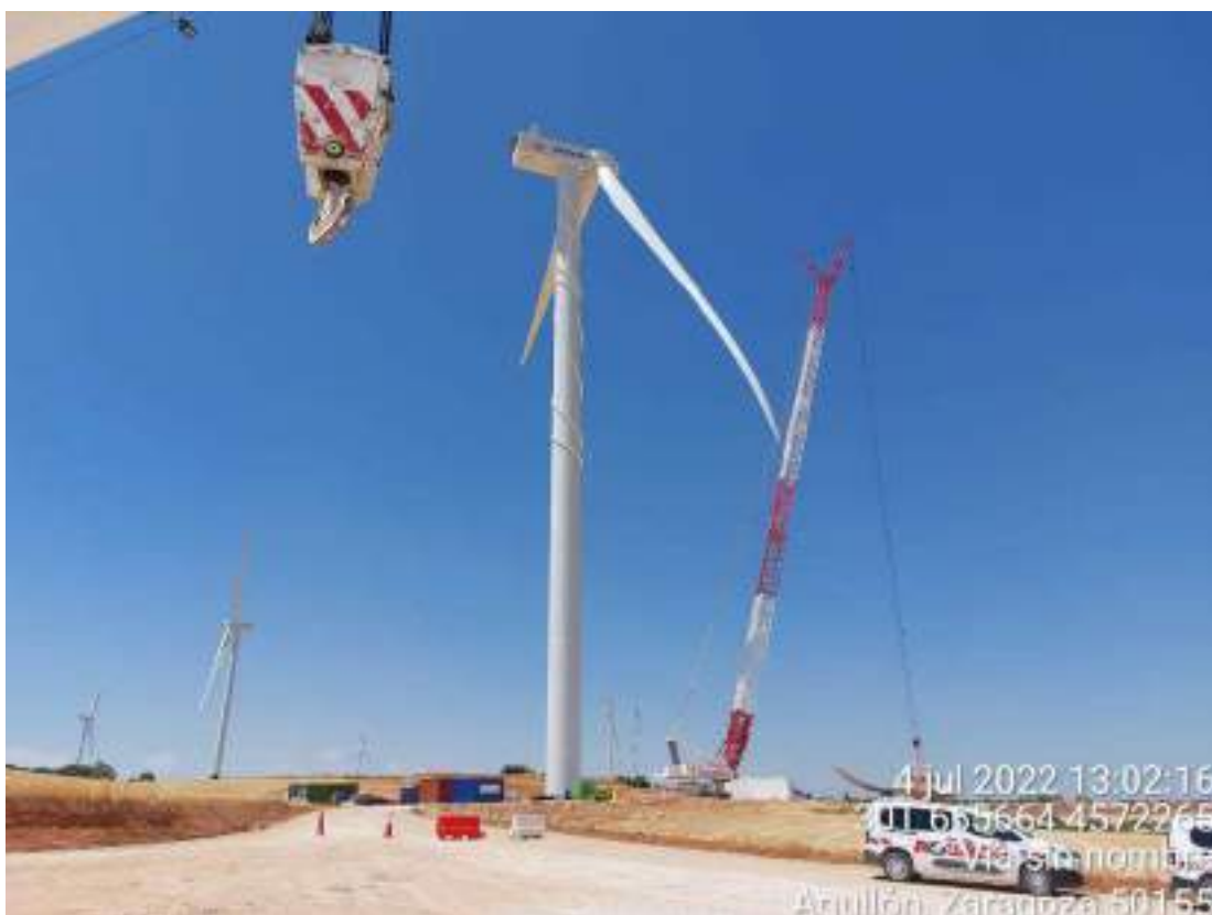
Ilustración 2. Montaje del aerogenerador SBII-06.
