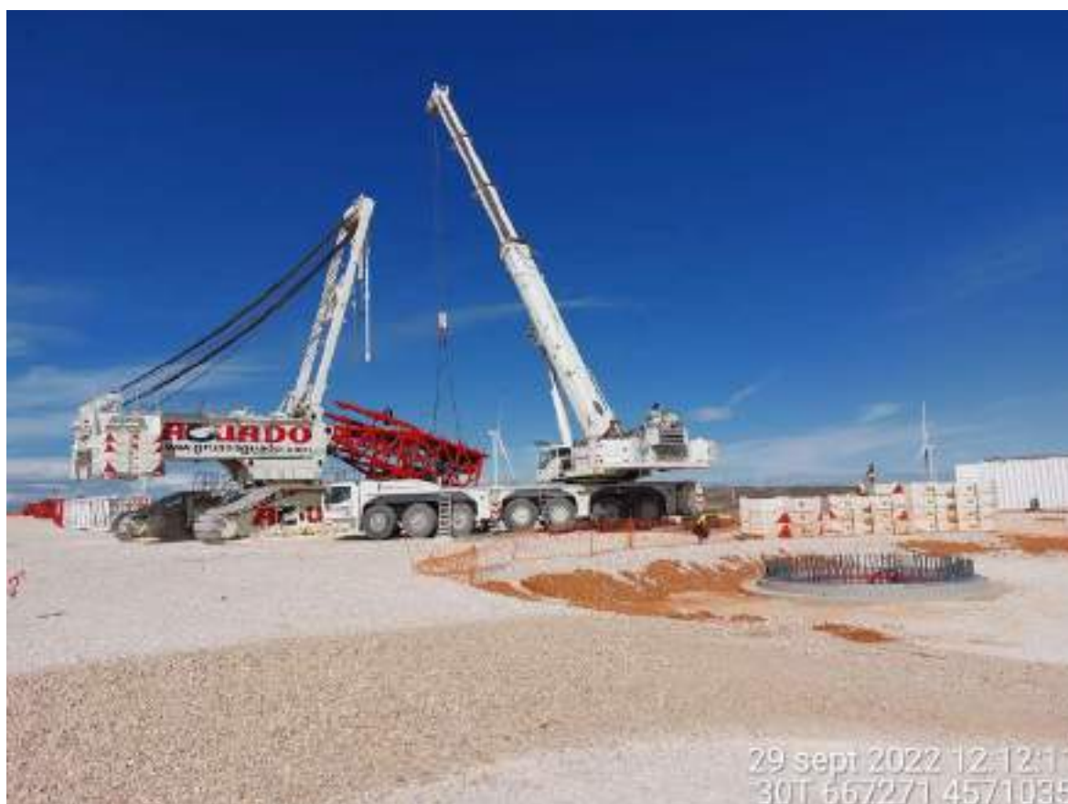
Imagen 1. Grúas preparadas para el montaje del aerogenerador PLX-2
