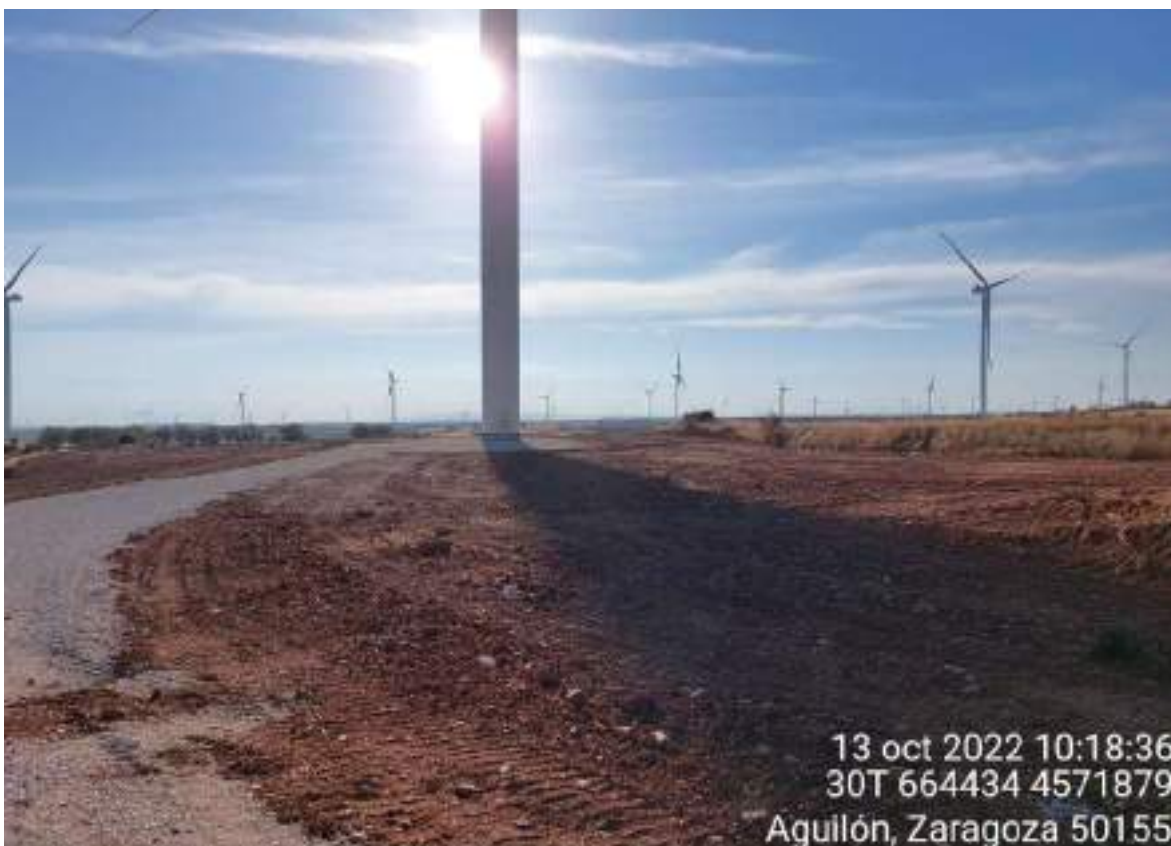
Imagen 2. Restauración ambiental posición SB2-03.
