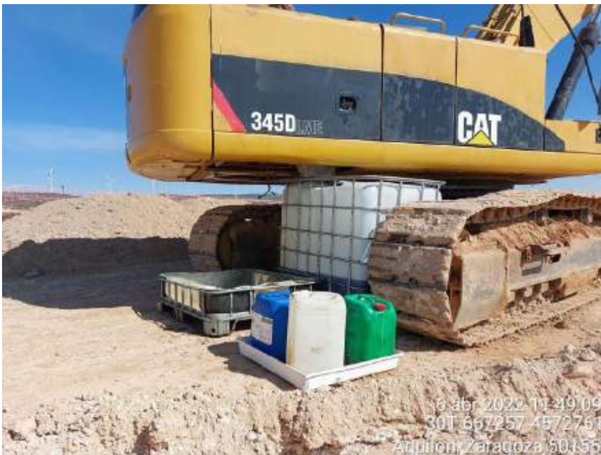
Imagen 5. Bidones colocados sobre cubetos de contención.
