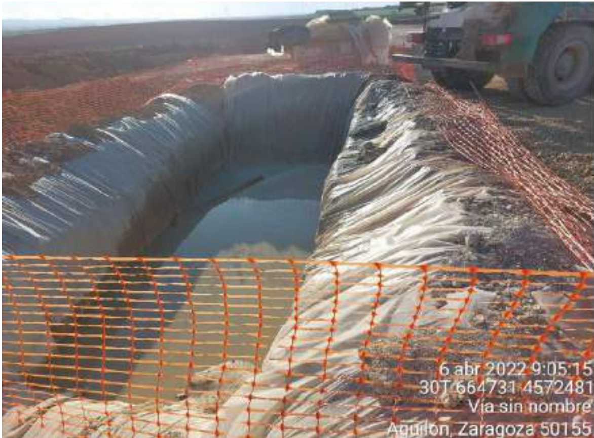
Imagen 4. Zona de lavado en perfecto estado tras lavado de cuba de hormigón en SBII-02.
