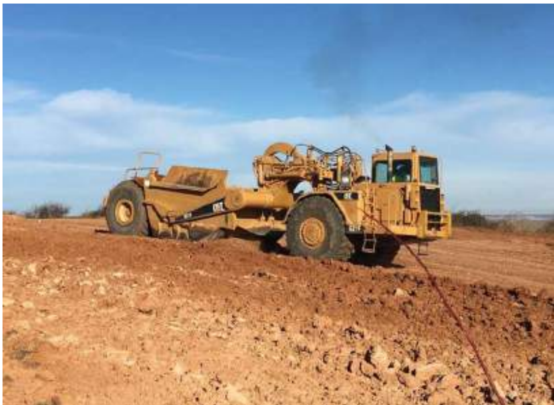
Imagen 2. Mototralla trabajando en SBII-03
