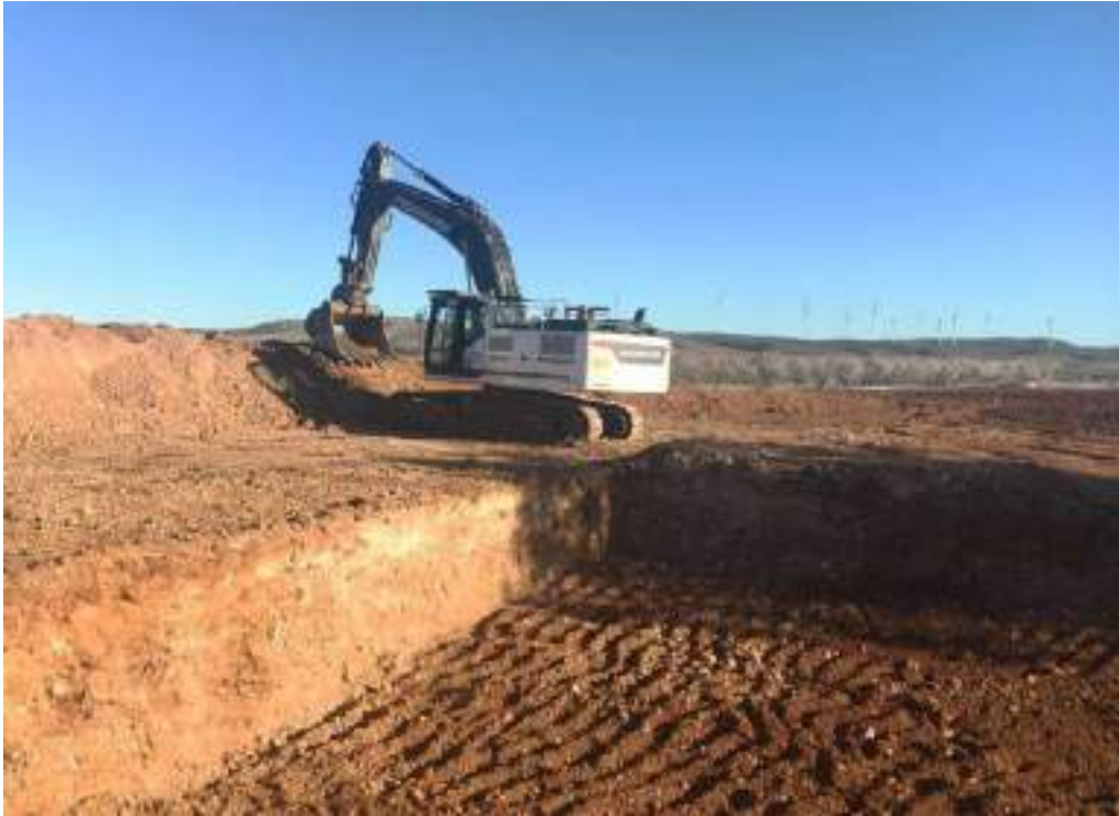
Imagen 4. Excavadora en TM
