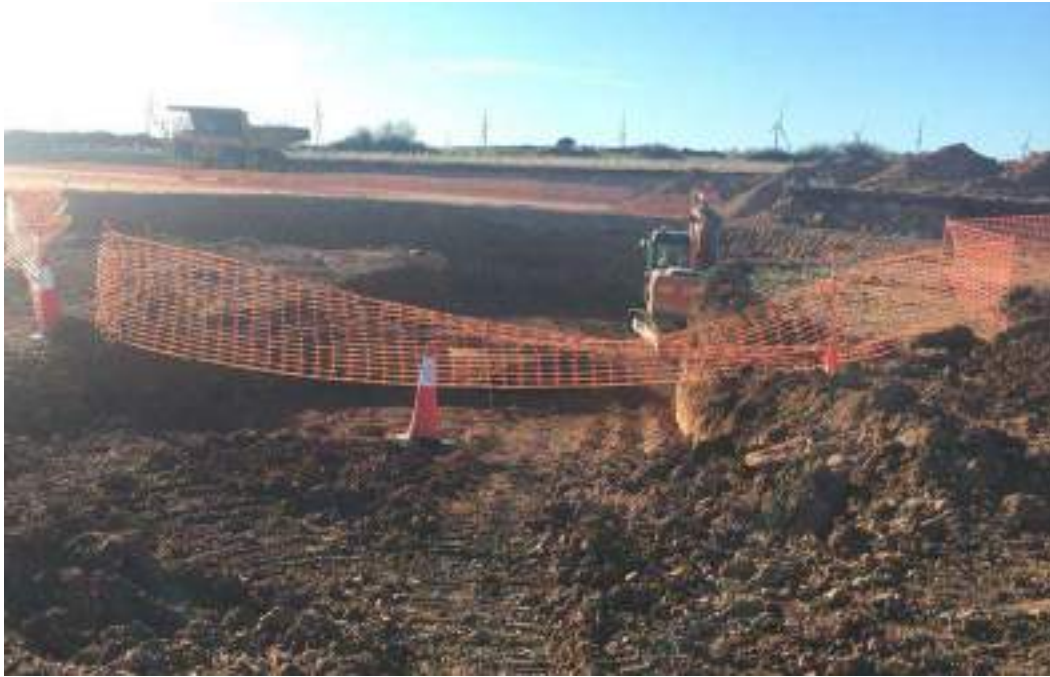
Imagen 2. Excavación zapata SBII-02
