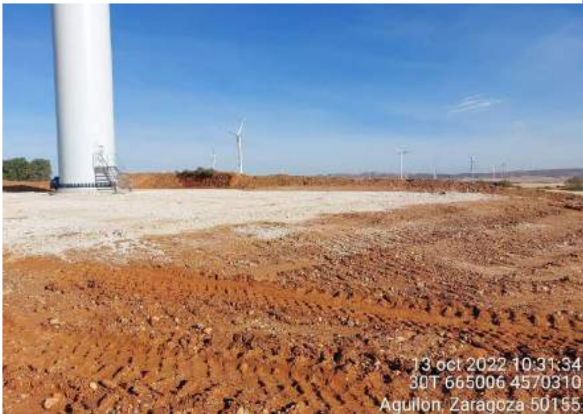
Imagen 4. Restauración ambiental posición SB2-07.
