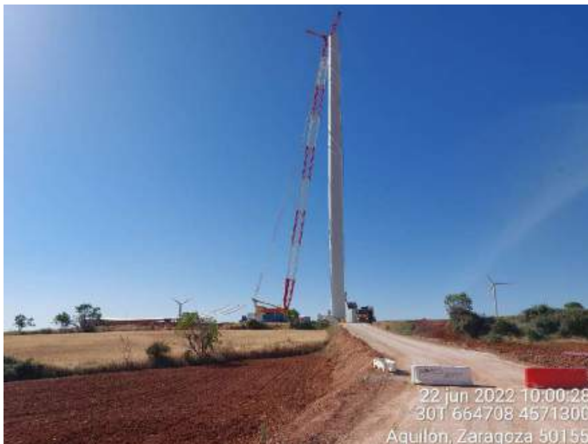
Imagen 1. Montaje de un aerogenerador
