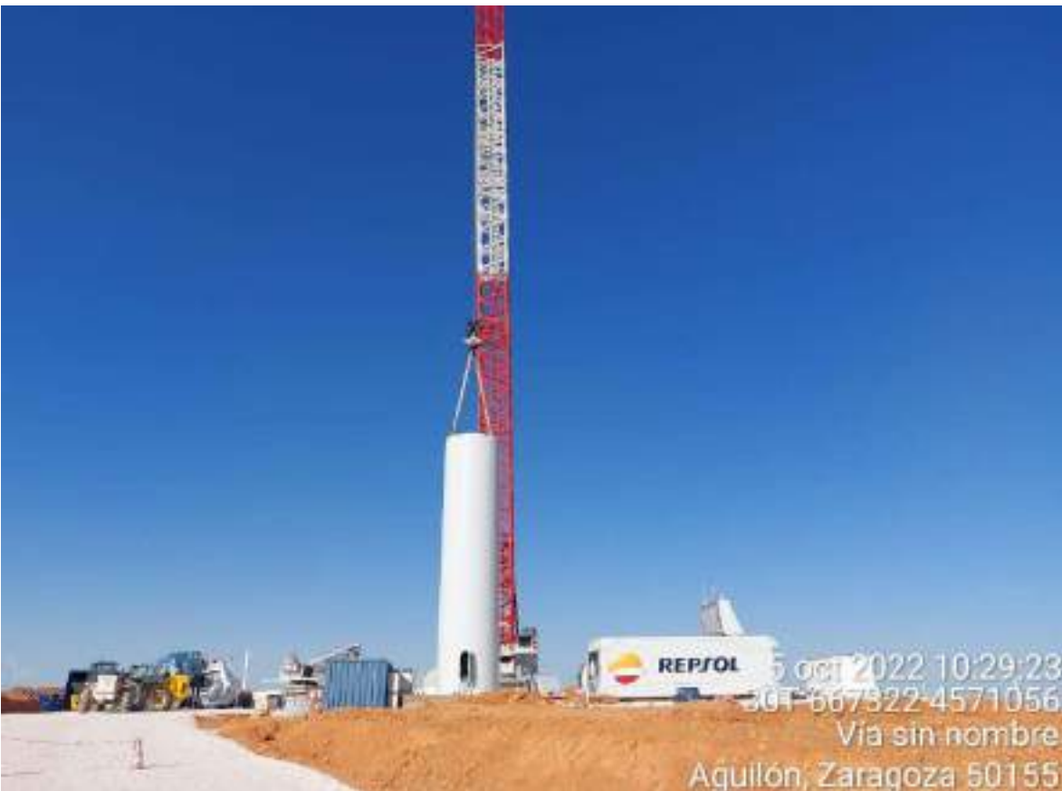
Imagen 4. Grúa colocando T1 en PLX-02.
