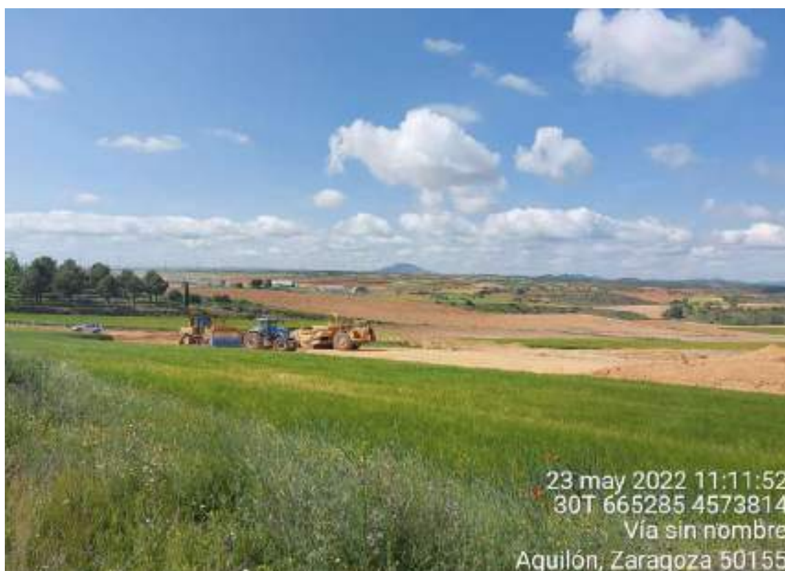
Imagen 1. Trabajos de movimiento de tierras en SBI-01.
