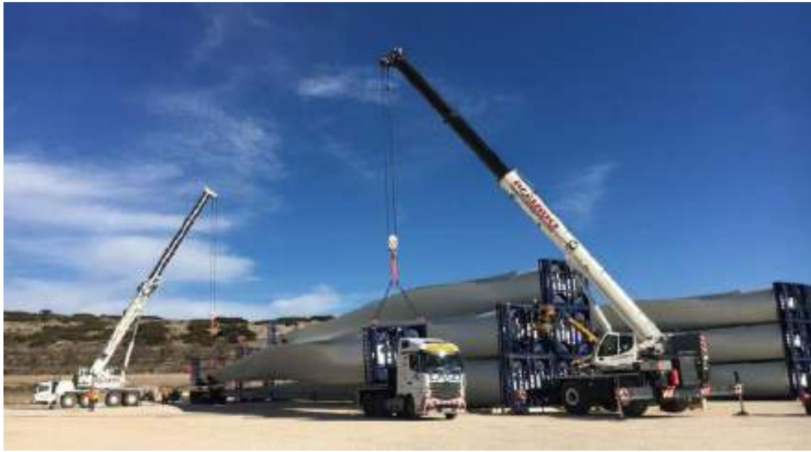
Imagen 5. Zona de acopio de material
