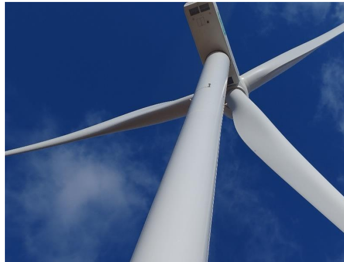
Fotografía 3: Barquillas de los aerogeneradores sin derrames de aceite
