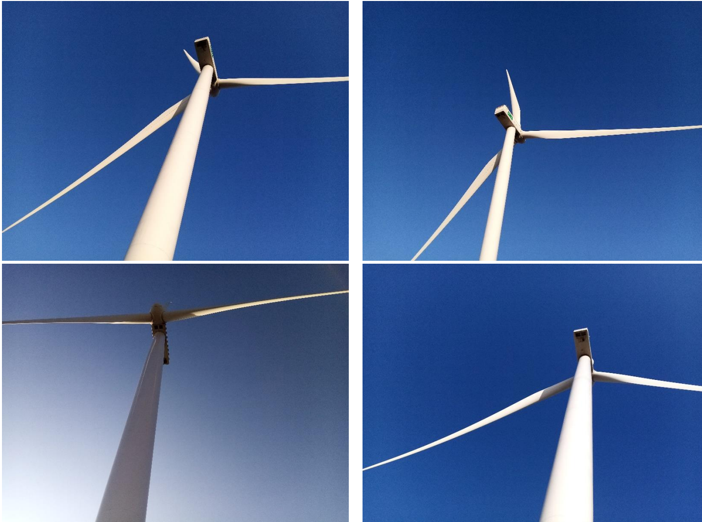
Fotografías 13 a 16: Barquillas de los aerogeneradores sin derrames de aceite
