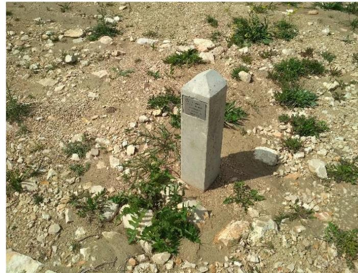
Fotografías 21 y 22: Señalización de la línea eléctrica subterránea
