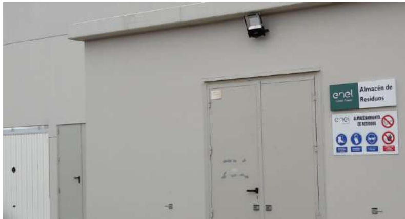
Punto limpio habilitado en la subestación Ventavieja para los parques eólicos de Muniesa, San Pedro de Alacón y Farlán
