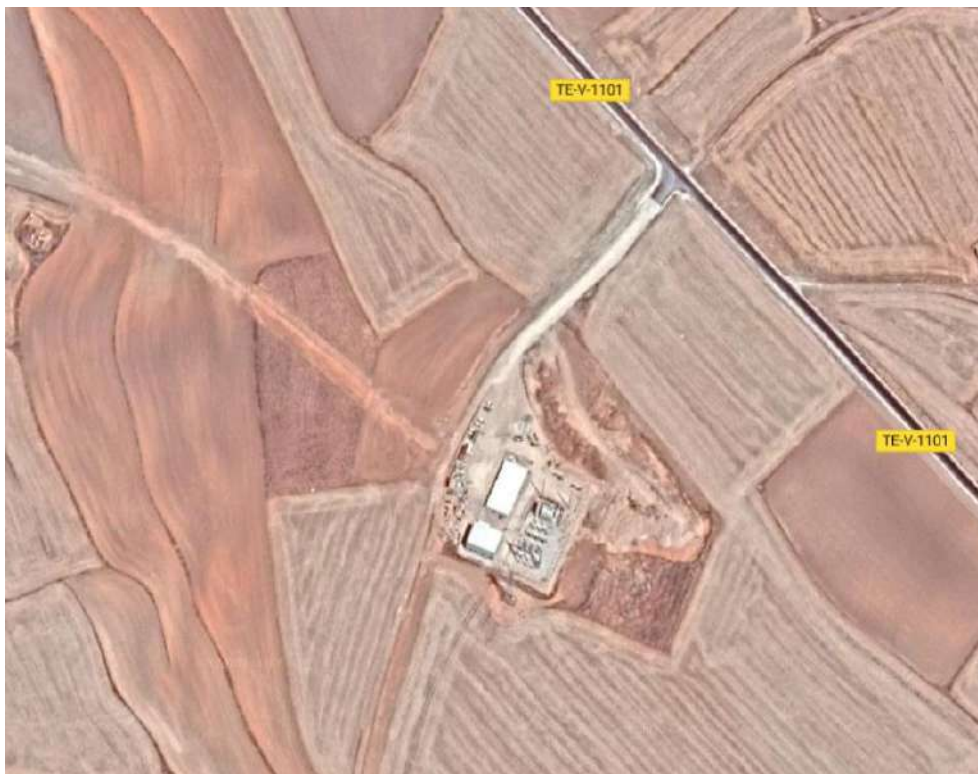
Figura 2: Subestación eléctrica sobre foto aérea
