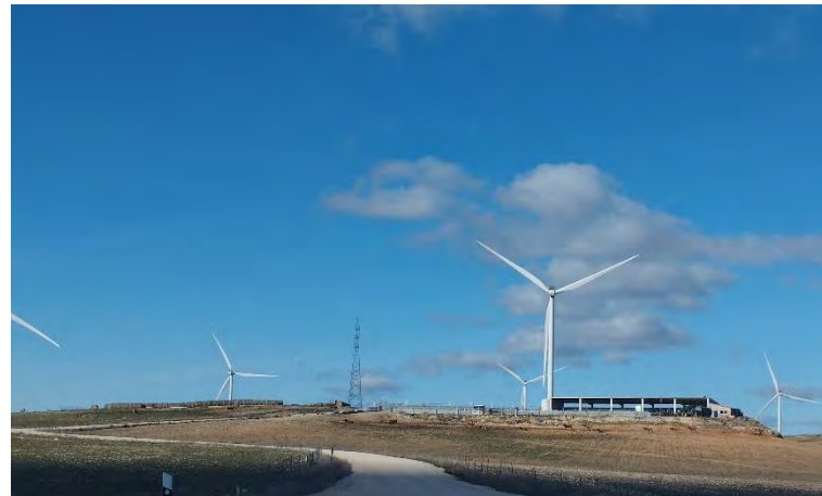
Fotografía 4: Parque eólico y línea eléctrica
