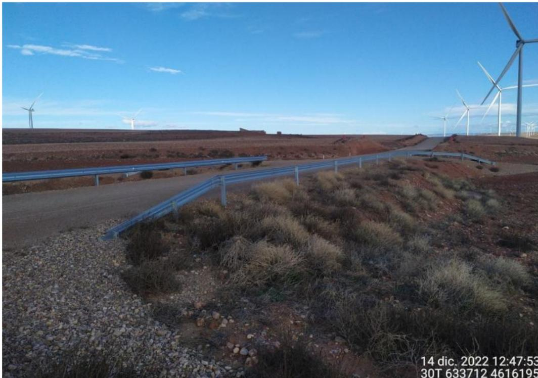
Figura 30: Vial de acceso principal entre aerogeneradores ET7 (aerogenerador más cercano de la imagen) y ET6. Puede observarse la vegetación natural arbustiva creciendo en los taludes.
