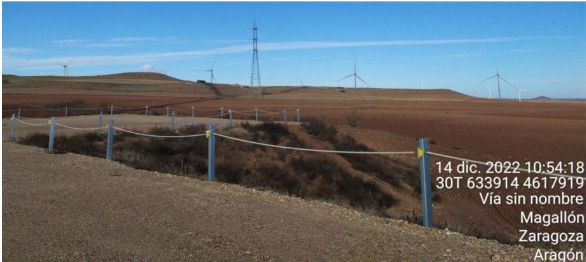
Figura 38: Fotografías del área restaurada en el talud de plataforma del aerogenerador ET-12, con una cárcava que se había formado en anteriores cuatrimestres correctamente solucionada.
