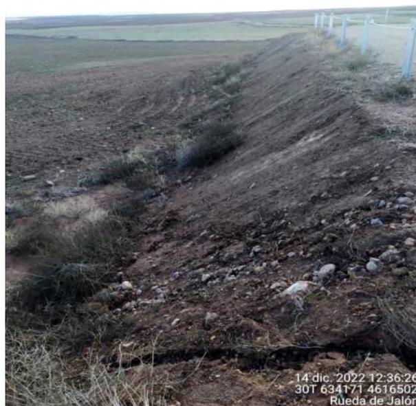
Figura 37: Talud norte de plataforma del aerogenerador ET-7 restaurado de una serie de cárcavas surgidas en 2022.
