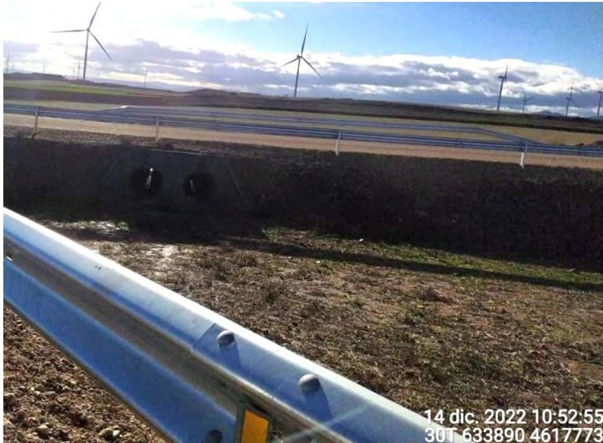
Figura 36: Desagüe situado en vial próximo a aerogeneradores ET11 y ET12 en buen estado.
