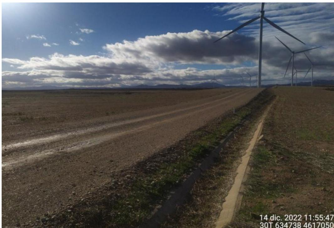
Figura 31: Vial de acceso principal entre aerogeneradores ET8 (aerogenerador más cercano de la imagen) y ET7. Puede observarse la vegetación natural arbustiva creciendo en los taludes.
