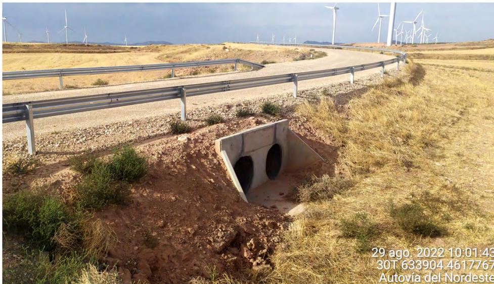
Figura 31: Desagüe situado en vial próximo a aerogeneradores ET11 y ET12 en buen estado.
