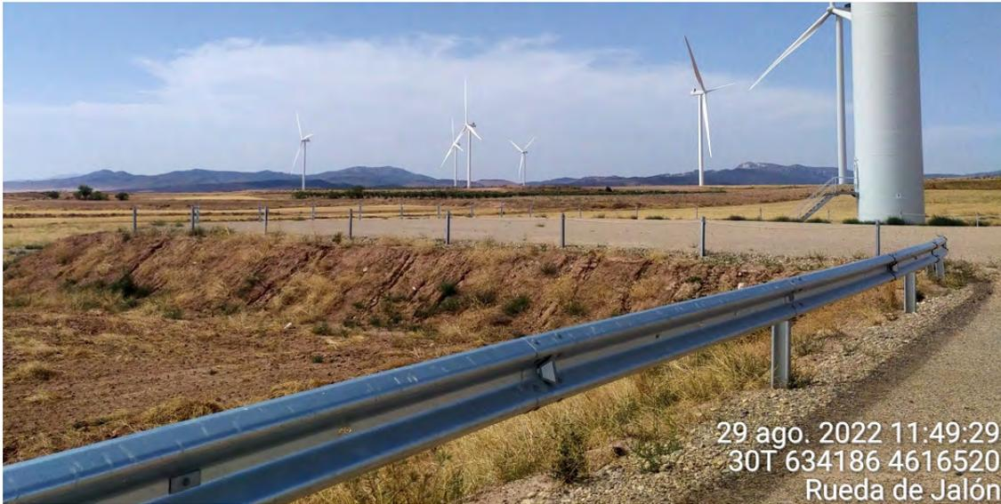
Figura 34: Cárcavas a lo largo de todo el talud norte de plataforma del aerogenerador ET-7 en Agosto 2022.
