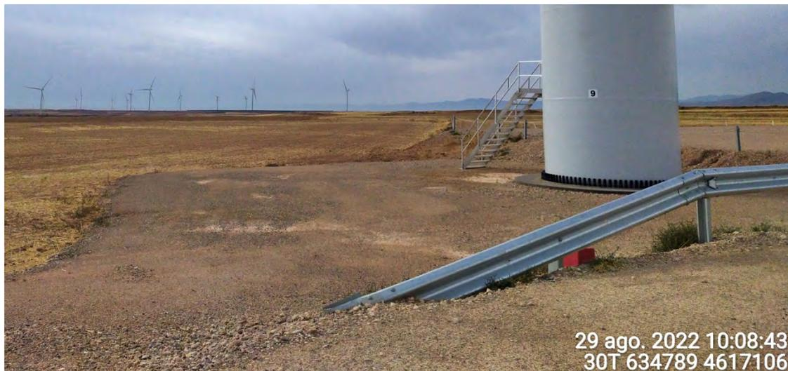
Figura 33: Fotografías de la plataforma de ET-9 reparada con una nueva capa de zahorra.
