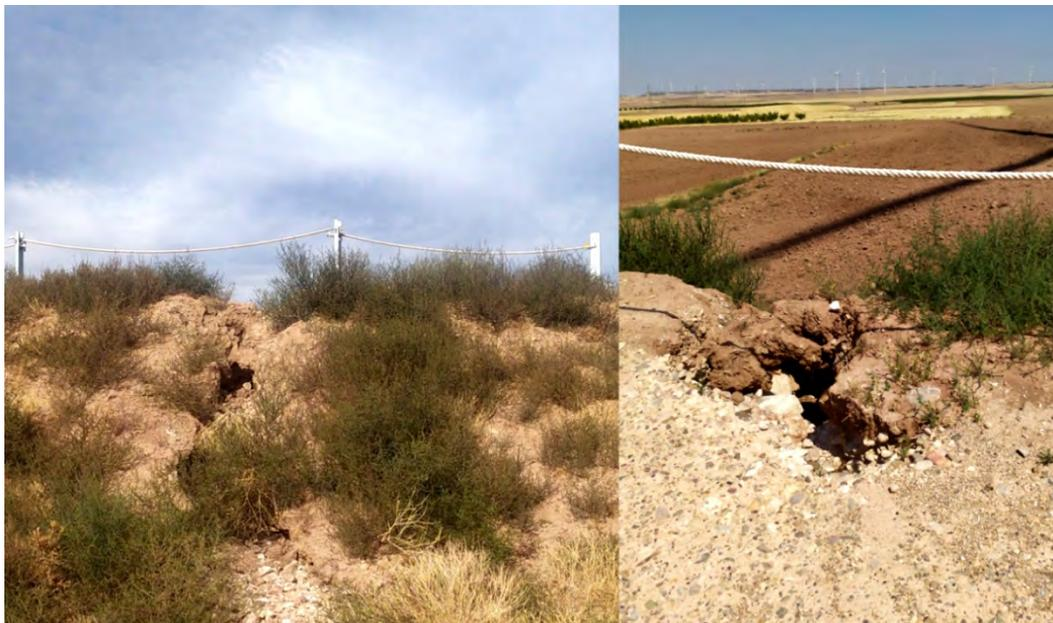
Figura 35: Fotografías de la cárcava en talud de plataforma del aerogenerador ET-12 en Agosto 2022.
