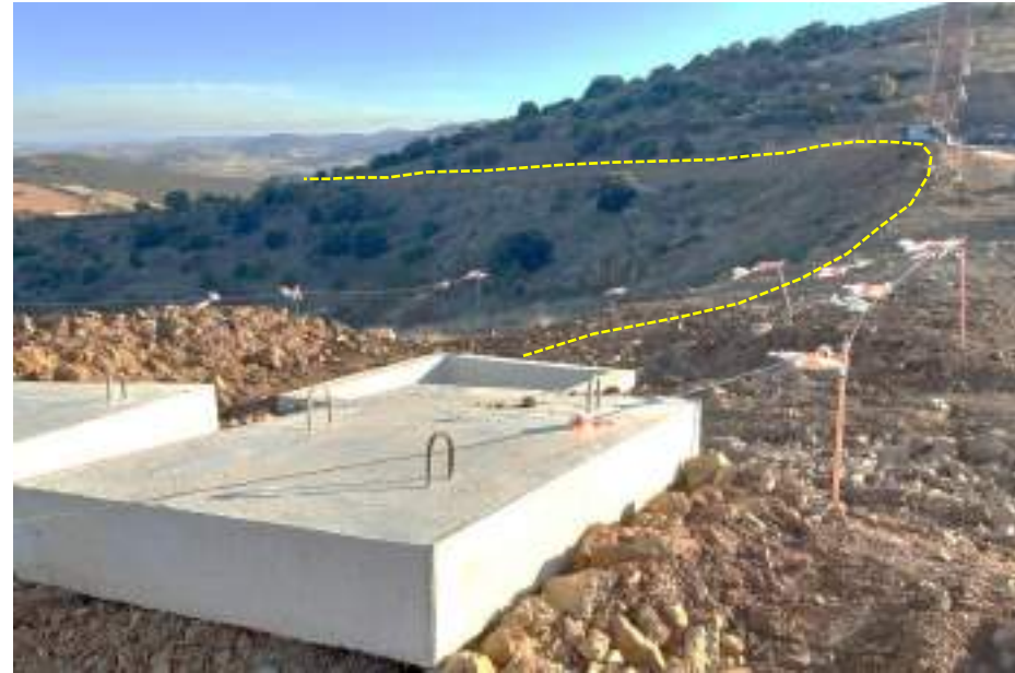
Noviembre de 2021. (La línea amarilla marca la zanja ya ejecutada, desde la arqueta de conexión de la LAT con la Red Interior del parque
