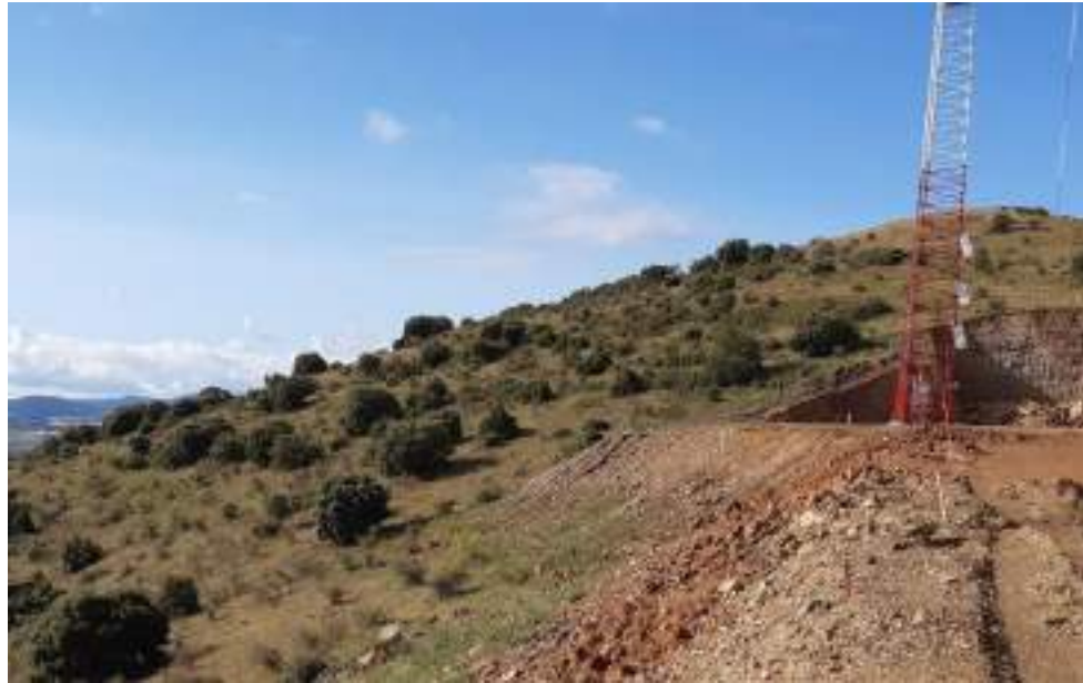
Julio de 2021, antes de ejecutarse la zanja
