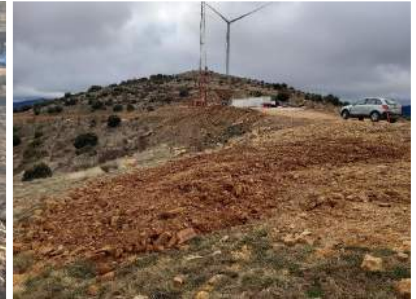
Enero de 2022, tras el tapado de las arquetas
