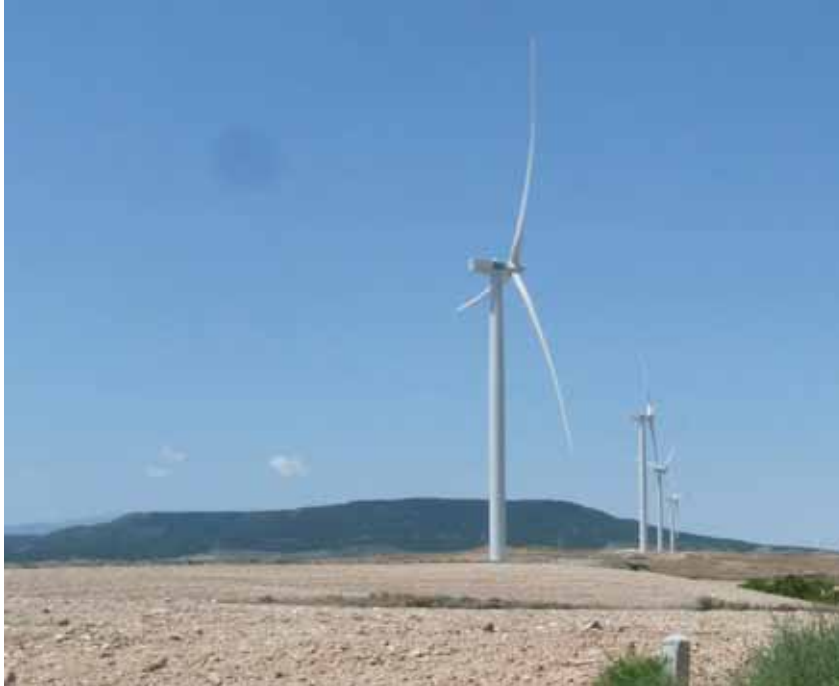
Aerogeneradores El Campo del 1 al 4 (primer plano)
