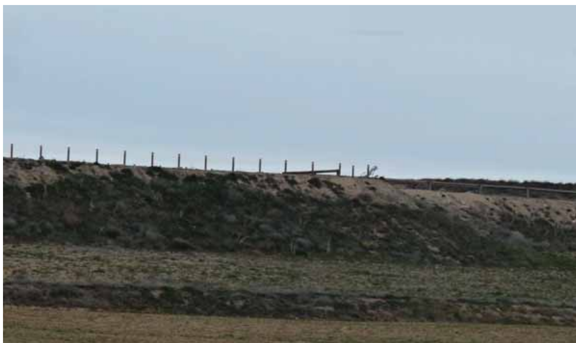
Restauración de taludes
