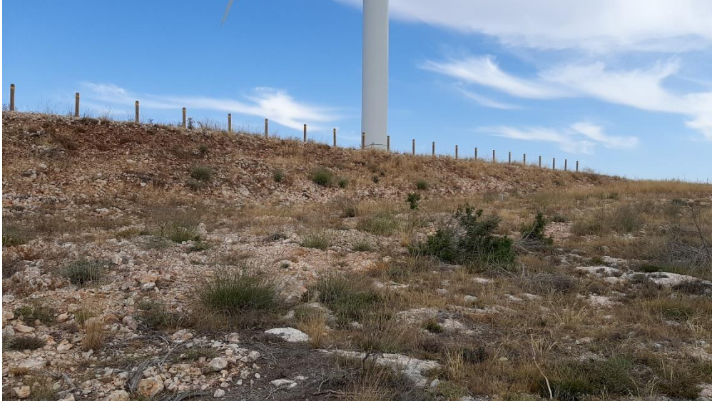
Revegetación en la zanja de cableado subterráneo y talud al sur de AL-04 (24/08/2022).
