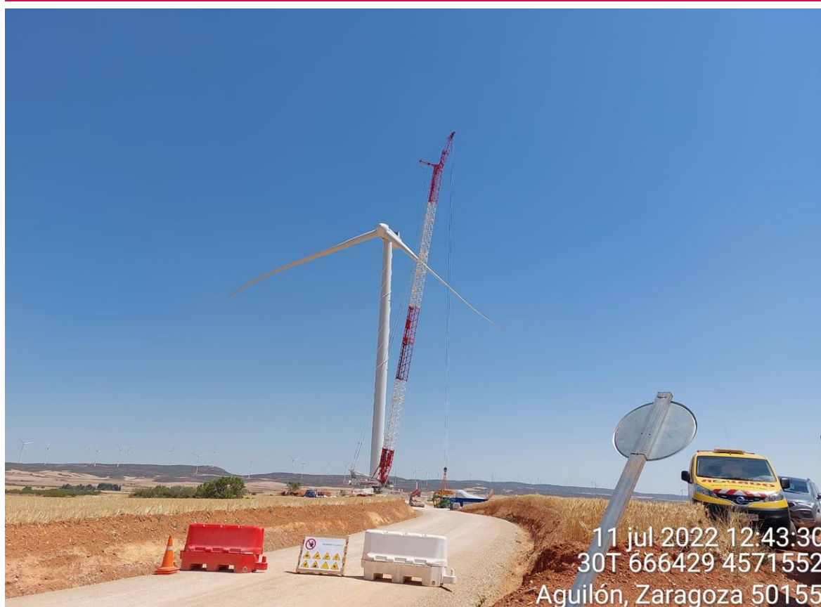
Imagen 1. Montaje del aerogenerador SBII-10.
