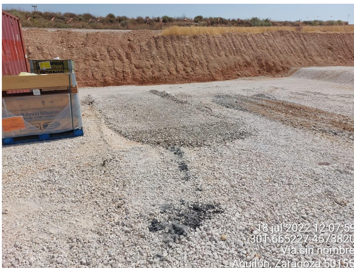
Imagen 1. Plataforma SBI-01 tras aplicar medidas correctoras por incendio de camión grúa.
