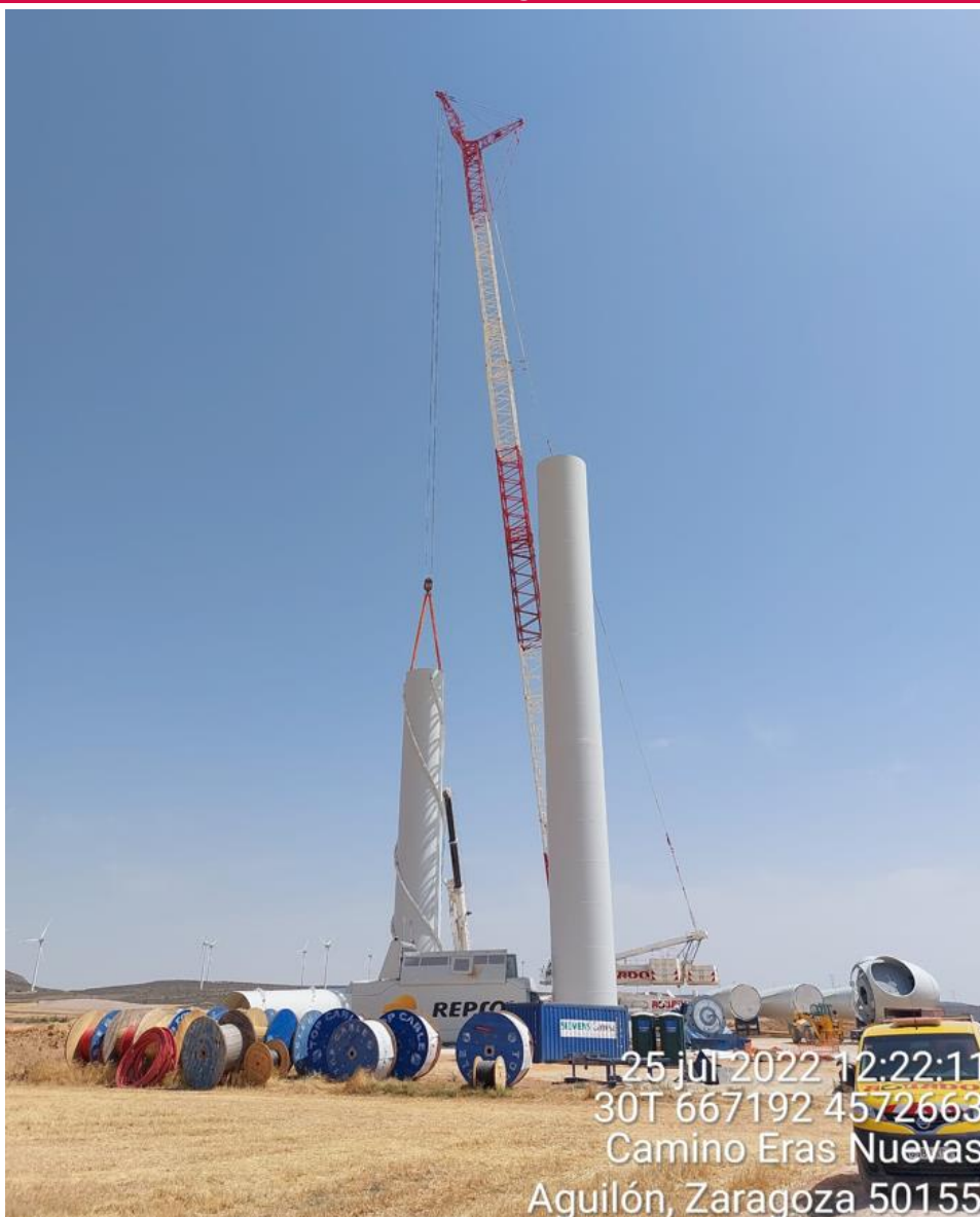
Imagen 2. Montaje del aerogenerador SB1-09
