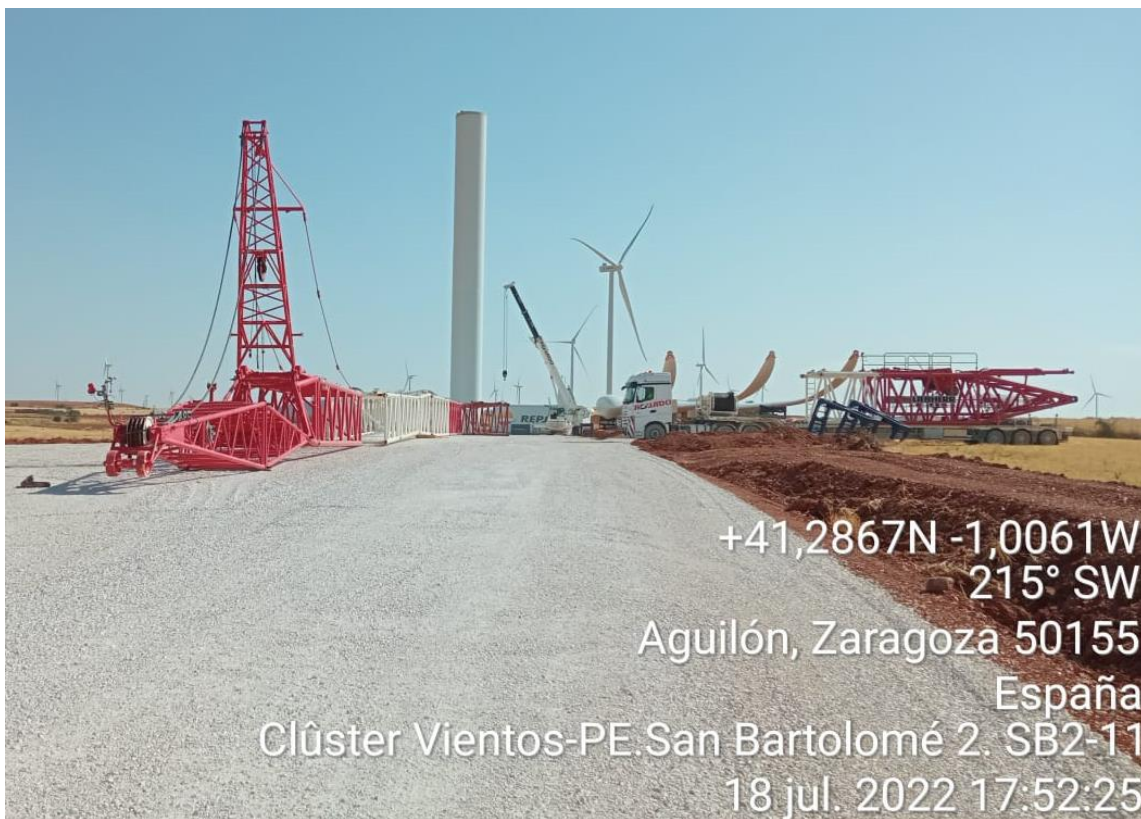
Imagen 2. Trabajos en plataforma de SB2-11
