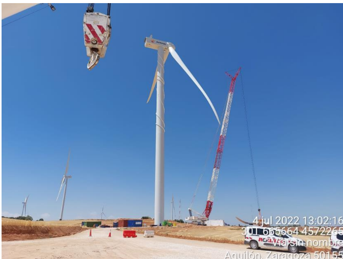
Ilustración 2. Montaje del aerogenerador SBII-06.
