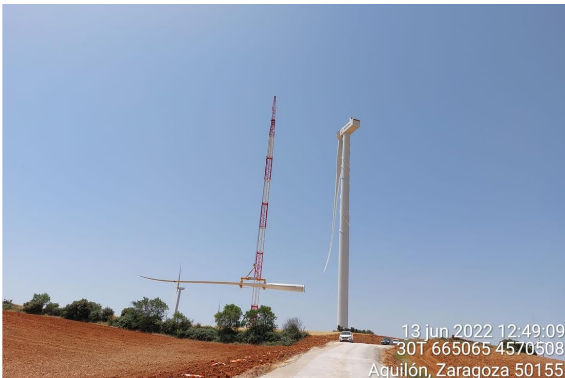
Imagen 3. Montaje del aerogenerador SB2-07.
