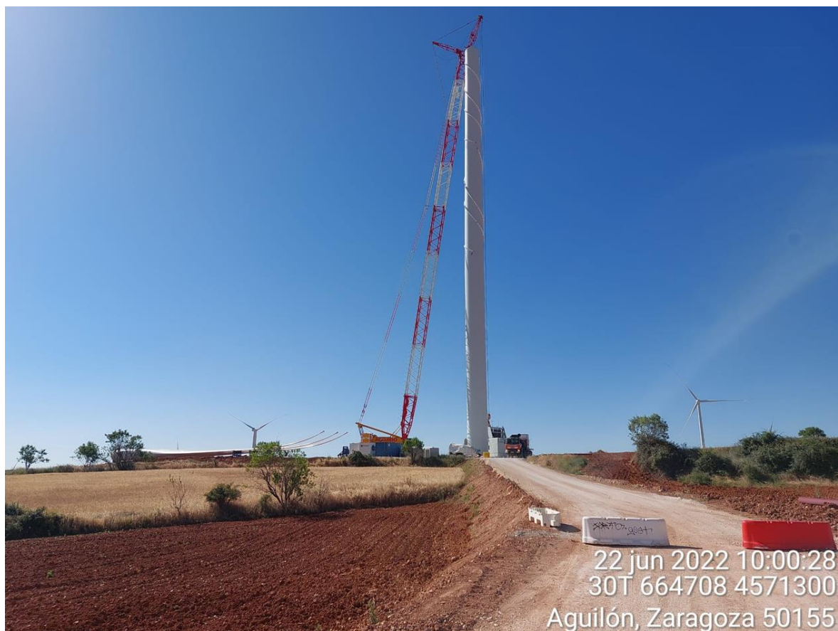
Imagen 1. Montaje de un aerogenerador
