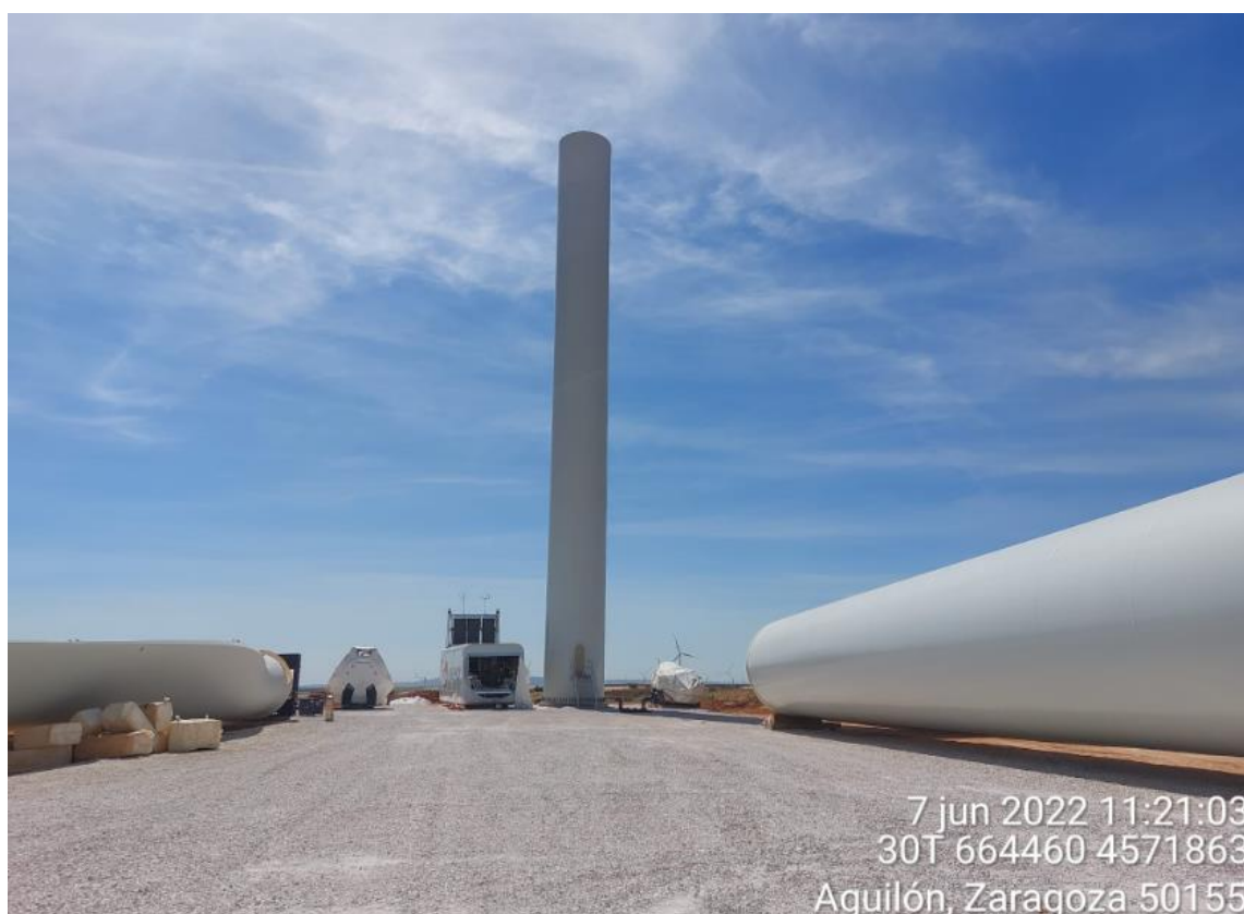
Imagen 1. Montaje del aerogenerador
