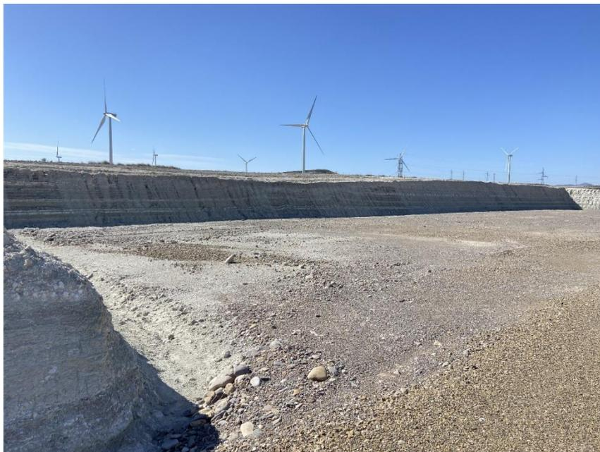
Figura 9: Fotografía y plano de localización de la erosión del talud al sur de la plataforma del aerogenerador CM-02. Pueden observarse varias cárcavas provocadas por el agua de precipitaciones torrenciales.
