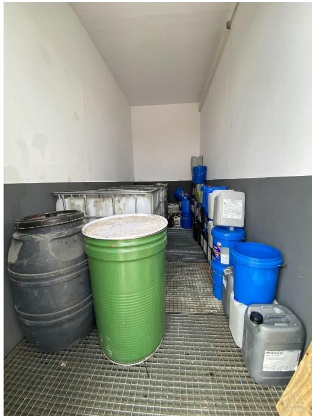
Figura 12: Interior del almacén de residuos de la SET “Campo de Magallón”, con los diferentes residuos peligrosos clasificados, aislados de la intemperie y sobre una tarima aislante para evitar posibles filtraciones al suelo.
