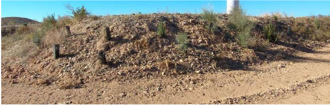
Estado general de los taludes restaurados (AG-04)
