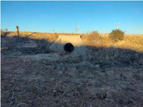
Foto nº24.: Drenaje del vial de acceso al PE.
