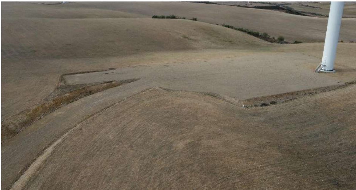
Foto nº6.: Plataforma del Aerogenerador AG-06.
