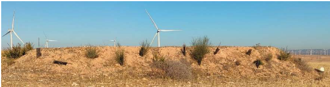
Estado general de los taludes restaurados (AG-07)
