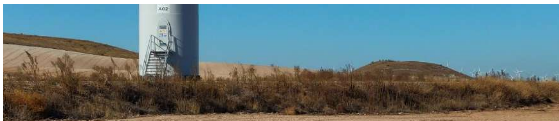
Estado general de los taludes restaurados (AG-02)
