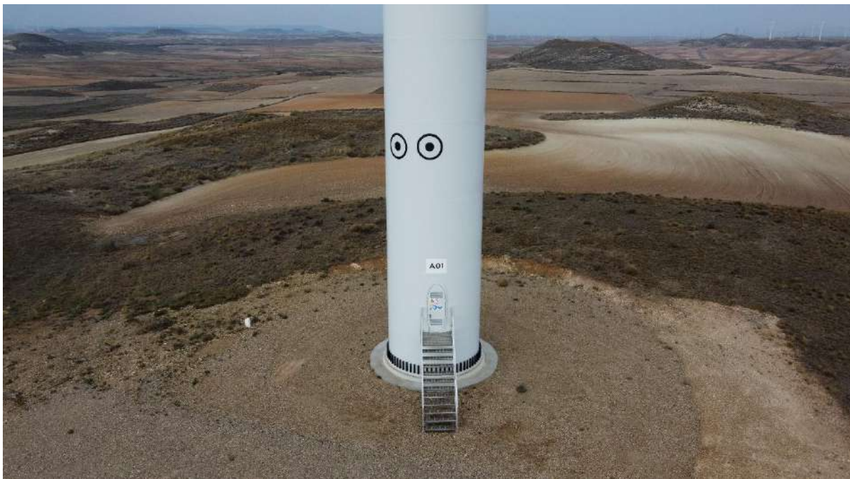
Foto nº10.: “Ojos de búho” en Aerogenerador AG-01.
