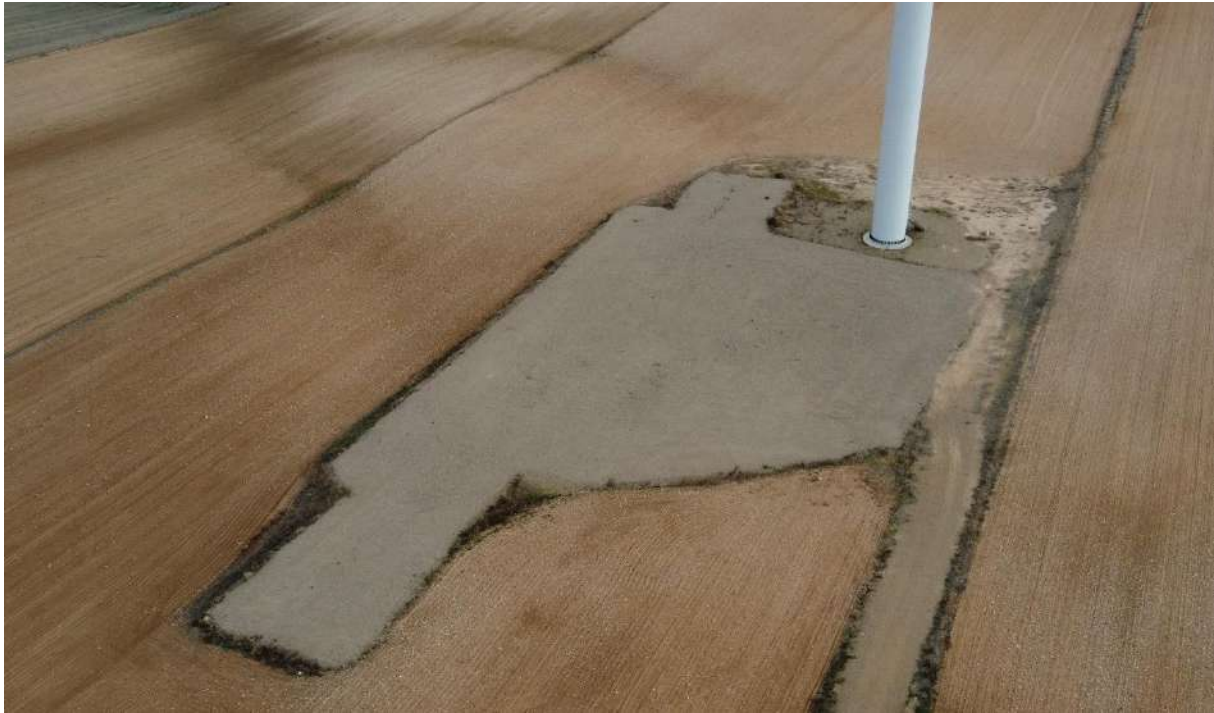
Foto nº3.: Plataforma del Aerogenerador AG-03.
