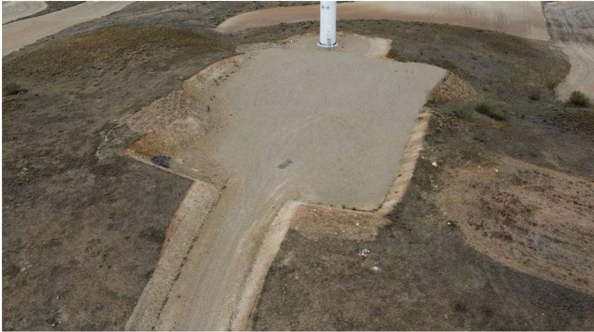
Foto nº1.: Plataforma del Aerogenerador AG-01.
