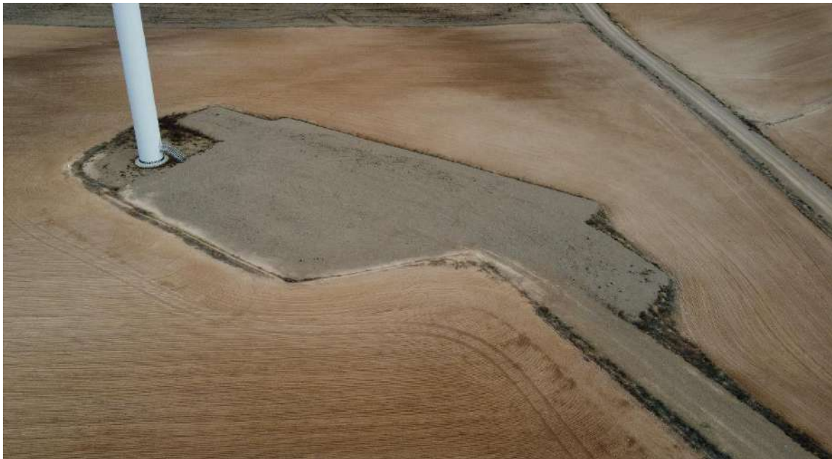
Foto nº2.: Plataforma del Aerogenerador AG-02.
