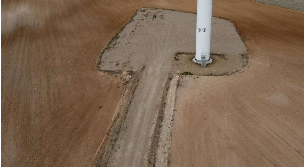
Foto nº5.: Plataforma del Aerogenerador AG-05.
