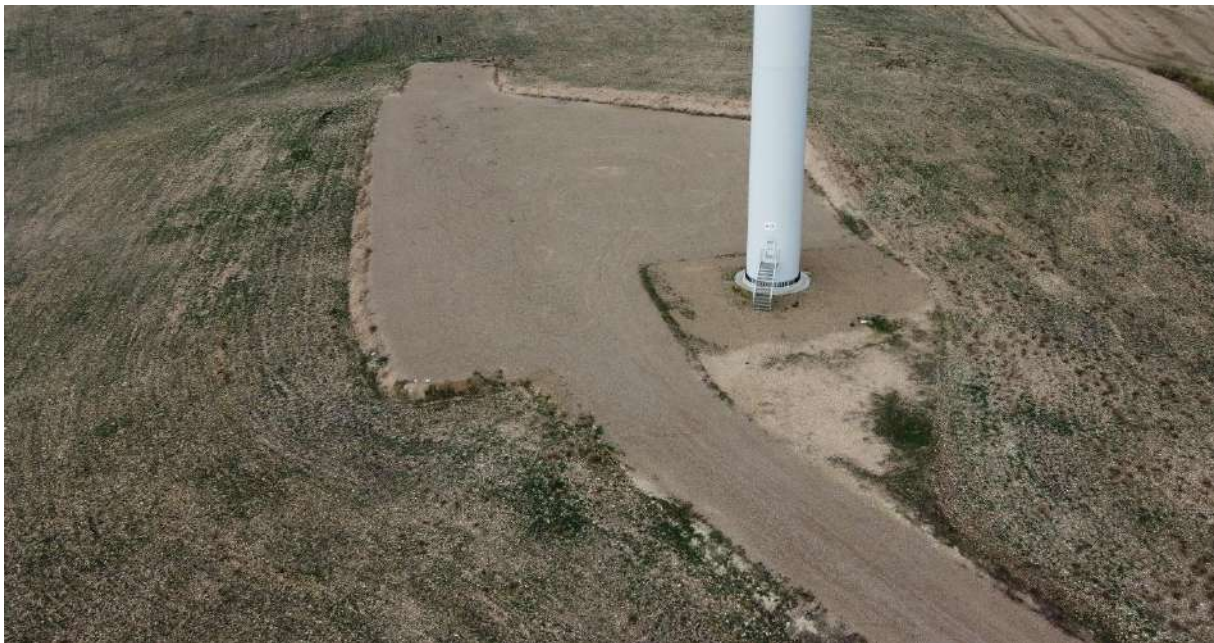
Foto nº8.: Plataforma del Aerogenerador AG-08.
