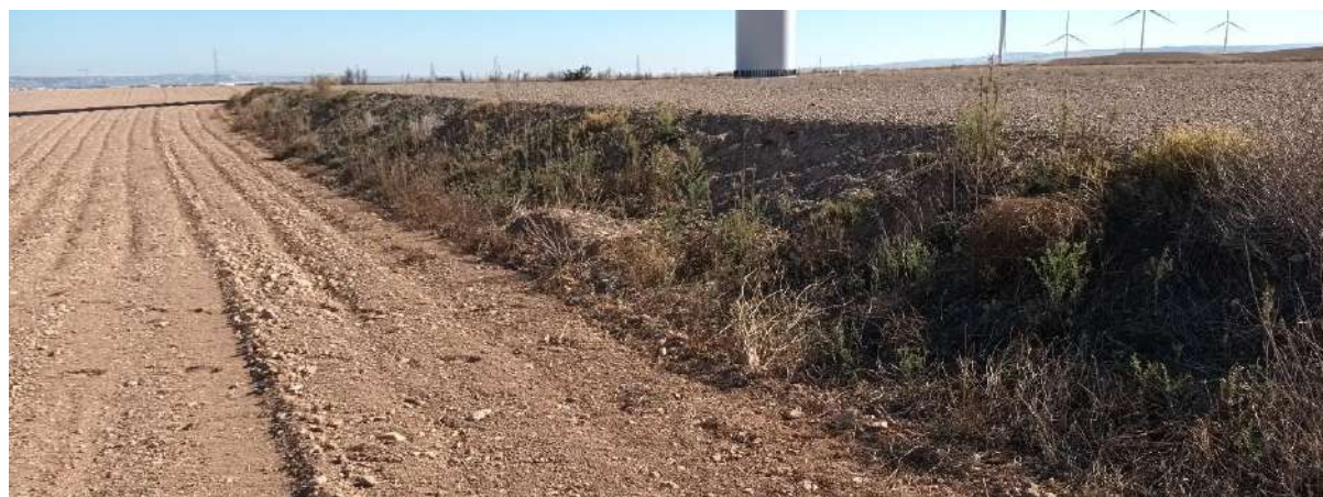
Foto nº14.: Hidrosiembra en terraplén AG-03.
