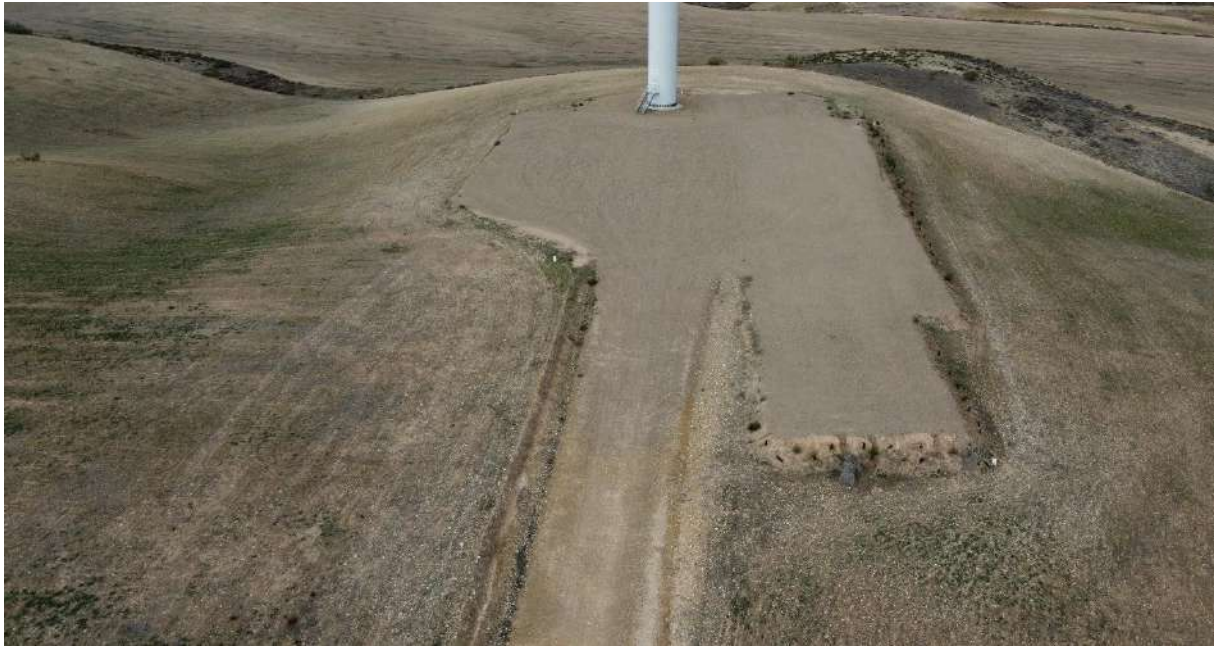
Foto nº7.: Plataforma del Aerogenerador AG-07.
