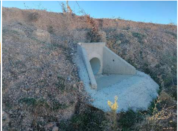
Foto nº24.: Drenaje del vial de acceso al PE.
