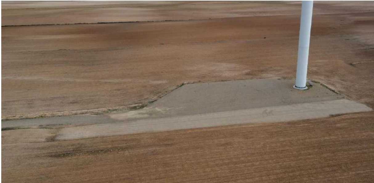
Foto nº9.: Plataforma del Aerogenerador AG-09.
