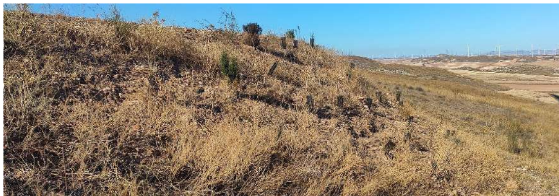
Estado general de los taludes restaurados (AG-01)
