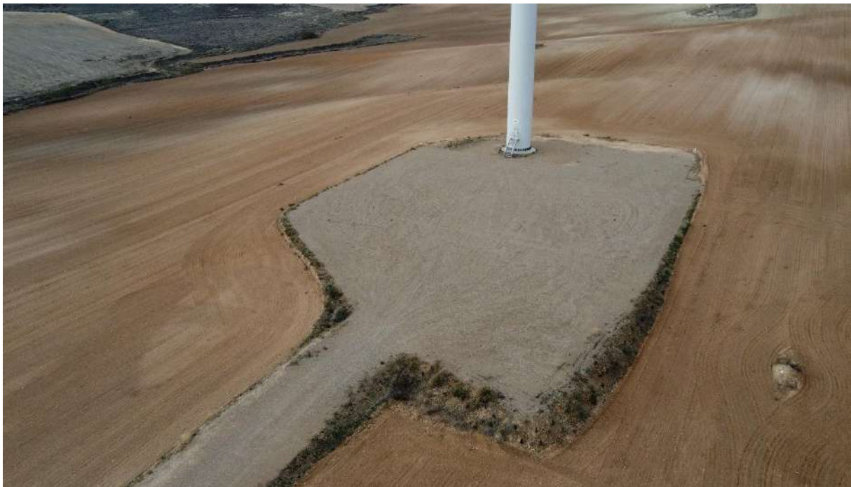
Foto nº4.: Plataforma del Aerogenerador AG-04.
