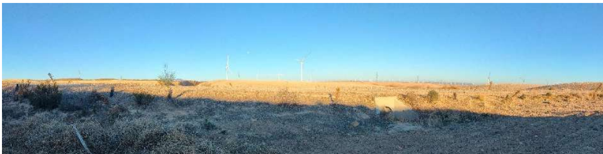
Foto nº18.: Restauración en terraplén acceso a parque.
