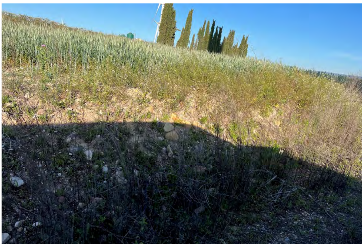
Imagen 9. Estado del talud anexo a la plataforma aerogenerador 3.
