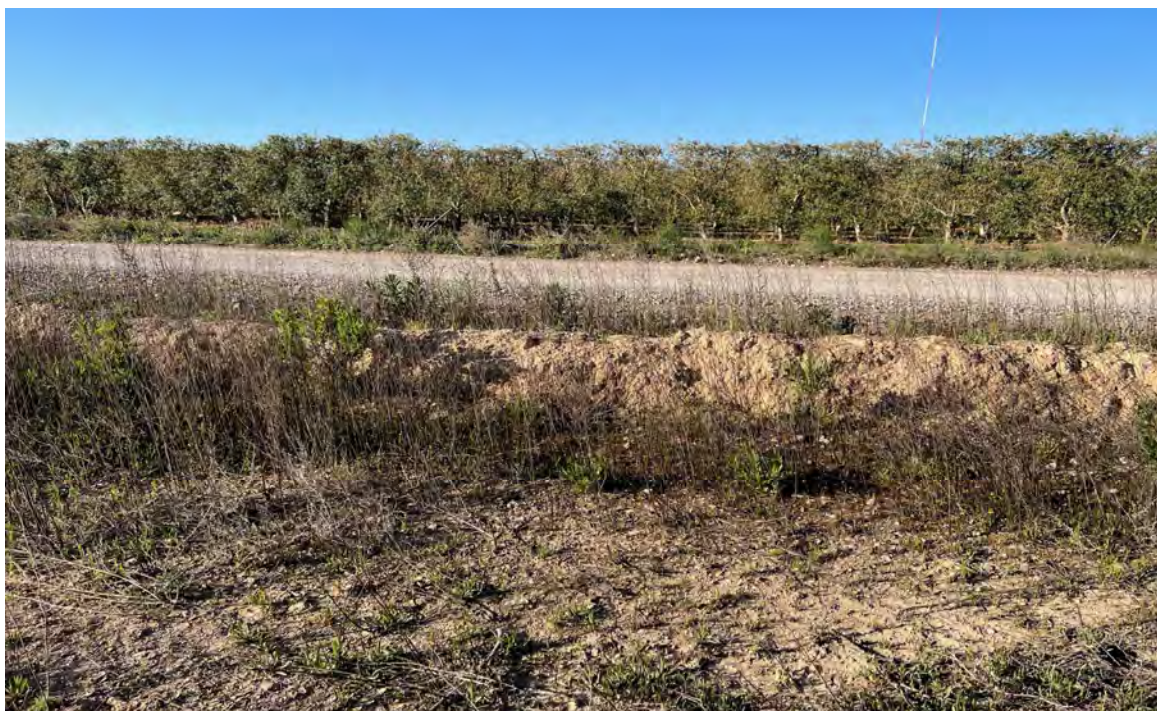
Imagen 8. Estado del talud anexo a la plataforma aerogenerador 3.
