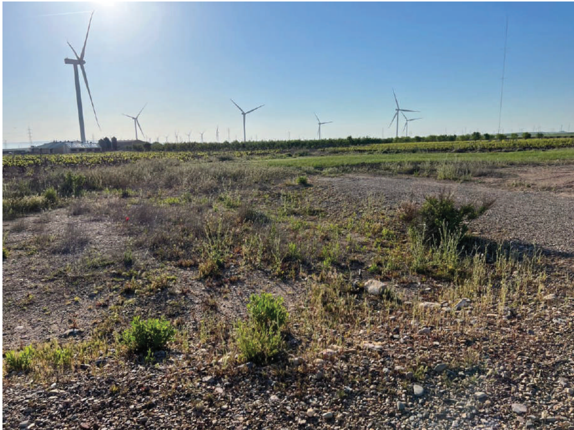
Imagen 6. Vista de la zona próxima a la cimentación del aerogenerador.
