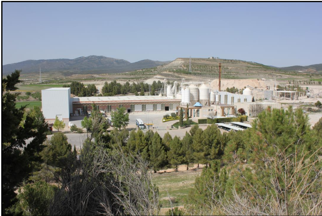
Vista general de la planta de tratamiento.
