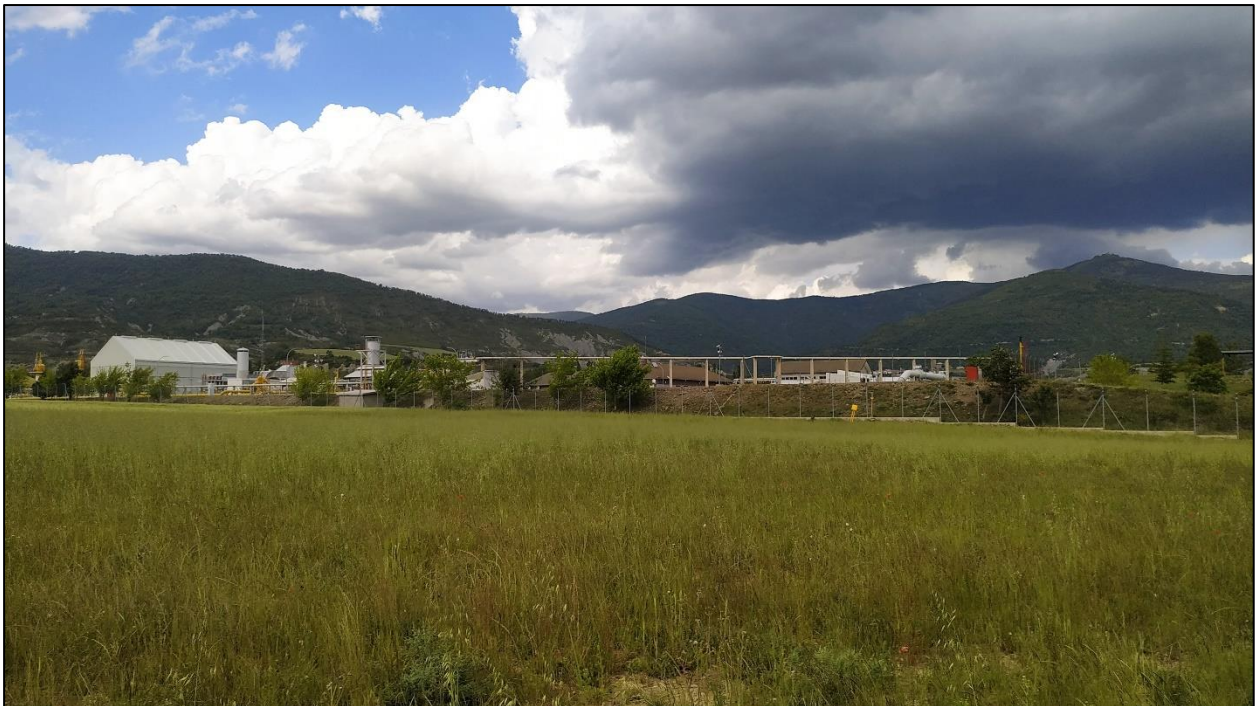
Vista de la Planta de Gas del Serrablo
