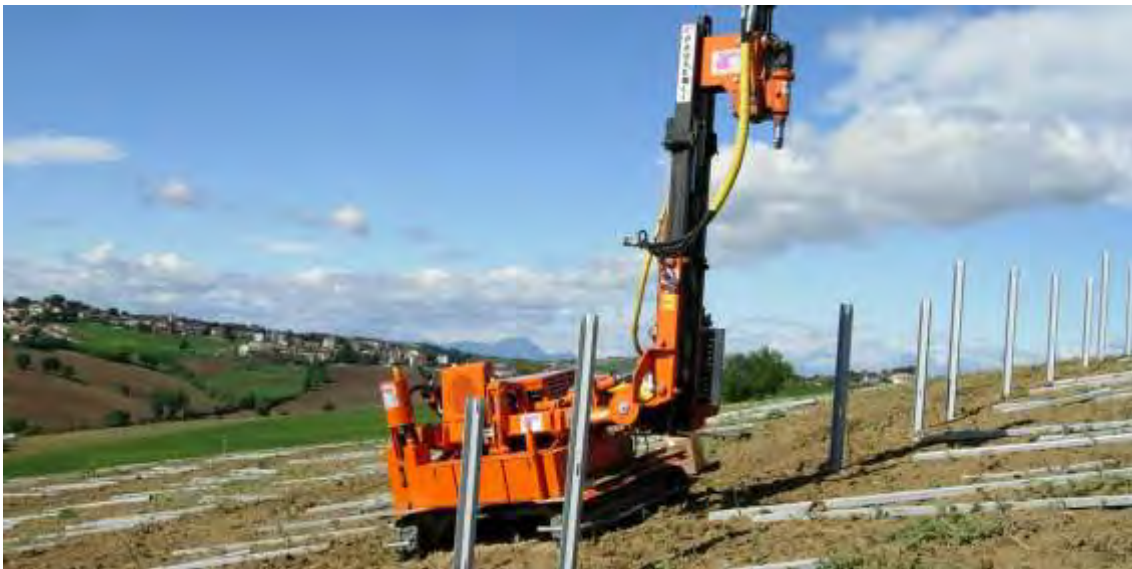
Ilustración 10: Máquina hinca postes. Fuente: Pauselli Group
