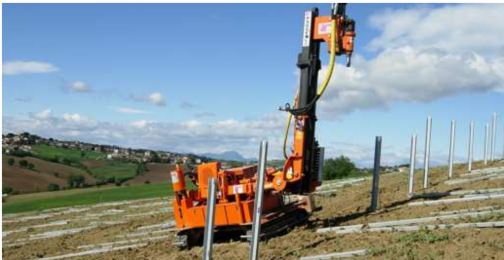
Ilustración 6: Máquina hinca postes. Fuente: Pauselli Group
