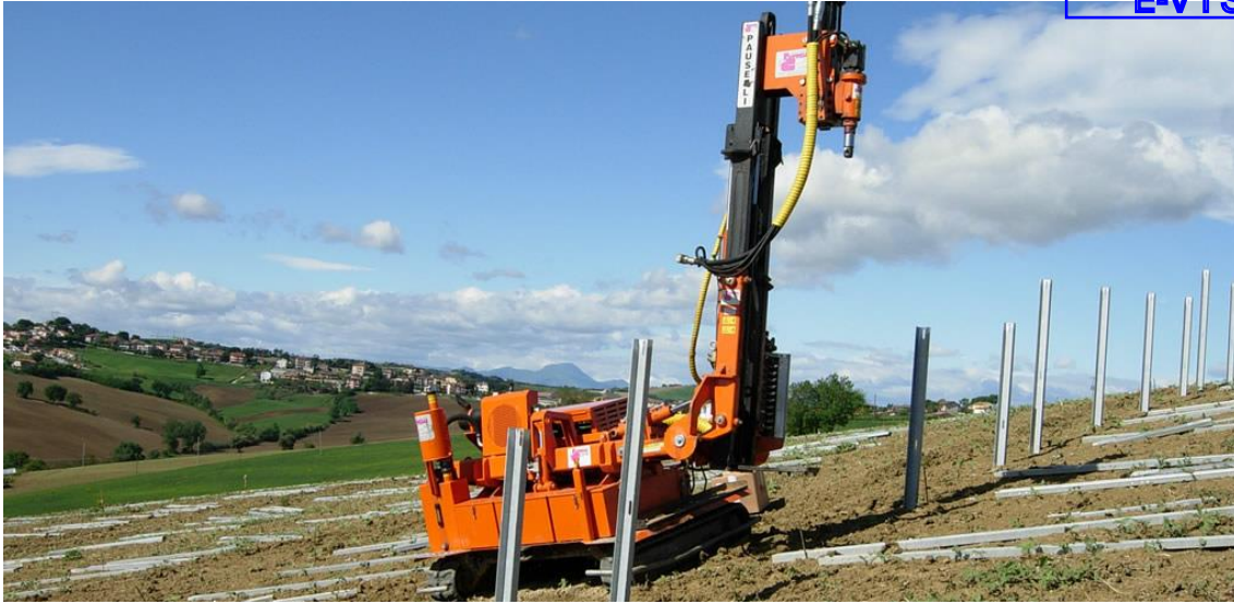
Ilustración 8: Máquina hinca postes. Fuente: Pauselli Group
