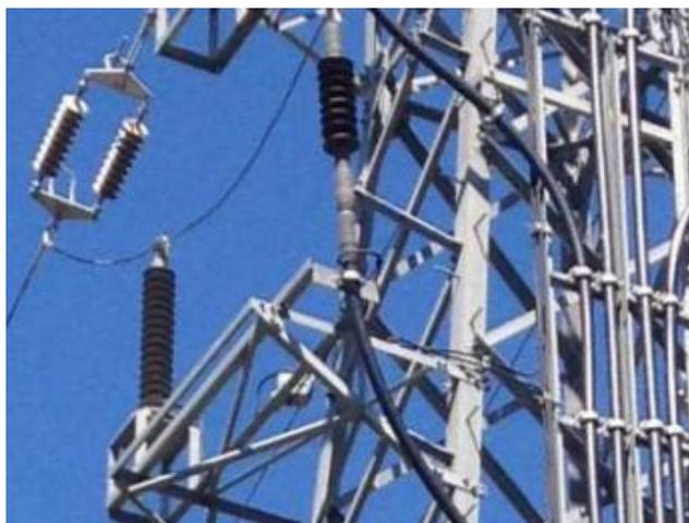
Figura 7. Detalle sujeción de los cableados secos en apoyo tipo PA/S
