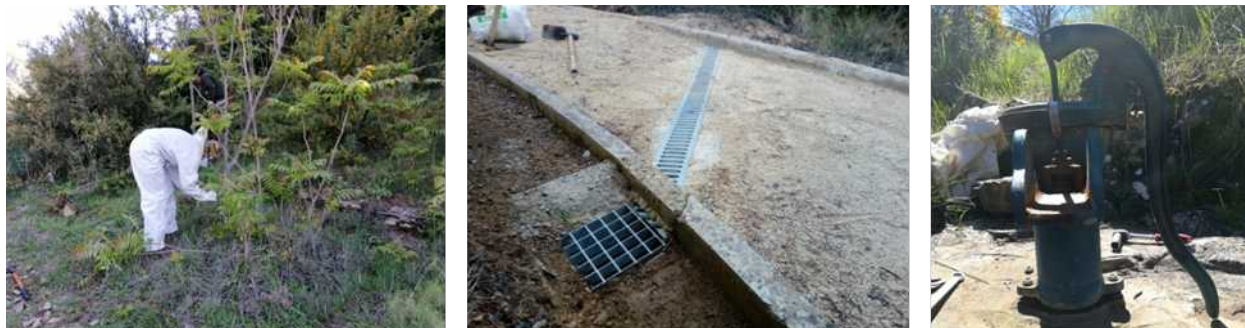
Ilustración 5 Tratamiento ailantos Rodellar, Desagüe en S-1 e Instalación de Fuente Otín
