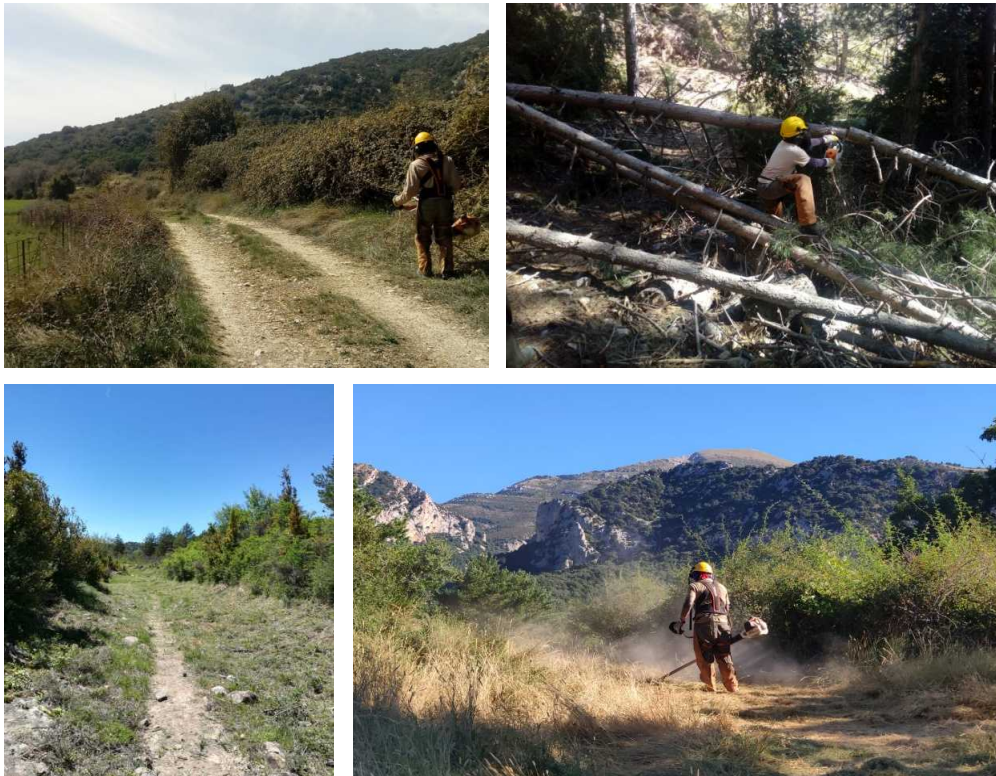
Ilustración 1 Desbroce en S-2, apeo y desbroce en S-11, desbroce en S-15 y desbroce en S-17
