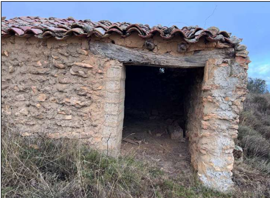
Imagen 6: Fotografía de la antigua edificación agrícola ubicada junto al acceso interior de la parcela que conduce hasta la zona de cultivo / explotación atravesando una zona forestal que NO será objeto de explotación.
