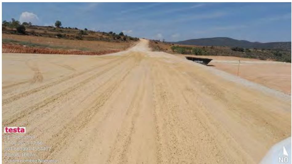
Riegos en viales y plataformas
