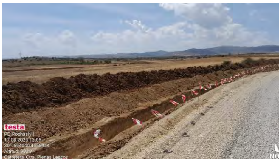
Separación de tierras en zanja de evacuación.
