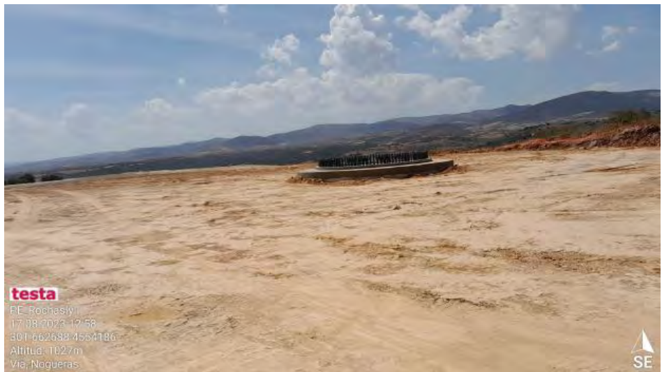
Recogida de grout en RH1-4.
