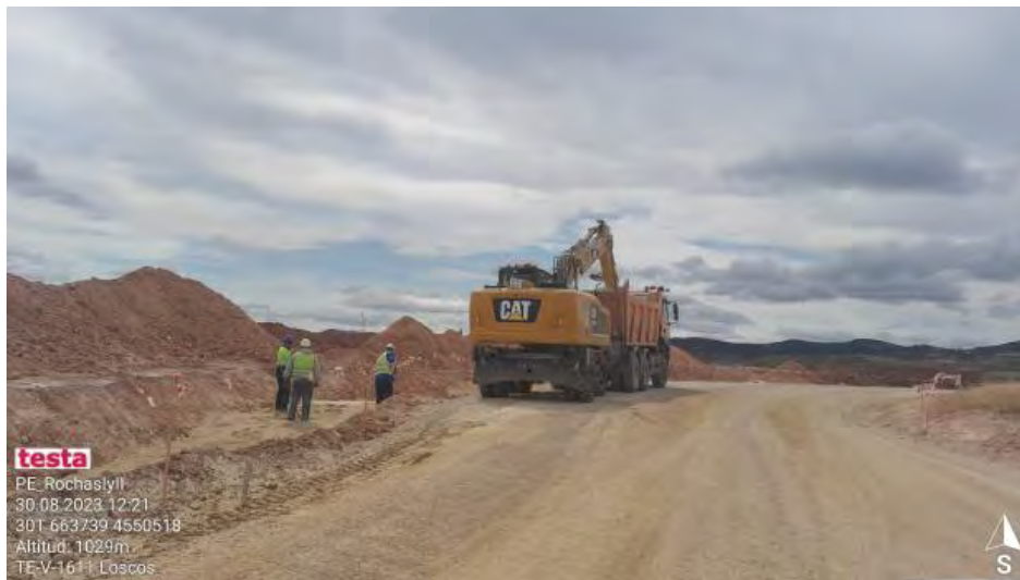
Extendido de cable en zanja de evacuación.
