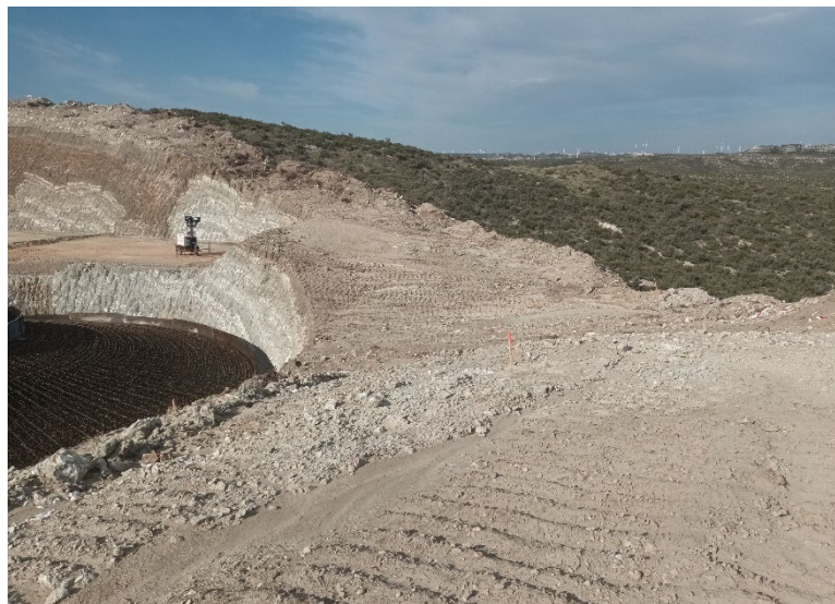
Figura 2: Balizamiento ubicación anclajes torre temporal
