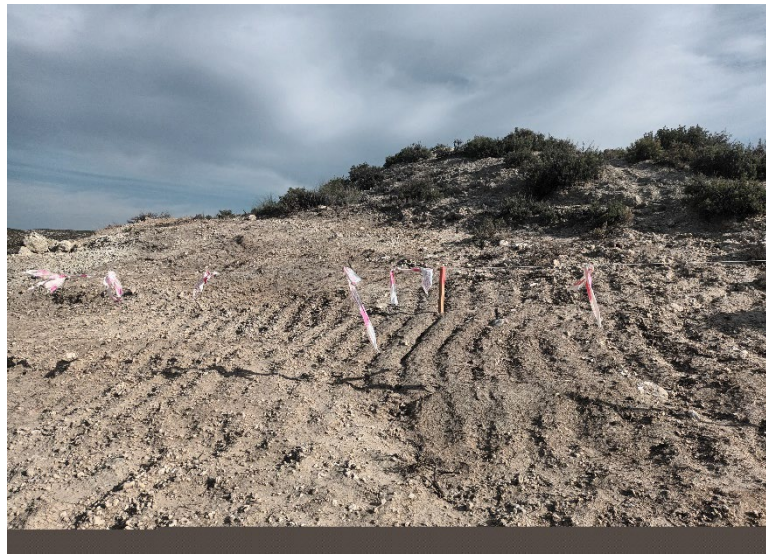
Figura 1: Balizamiento ubicación torre temporal
