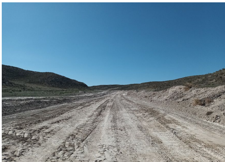
Figura 2: Vial por el que discurrirá la zanja al lado SET Campillo con su acopio TV
