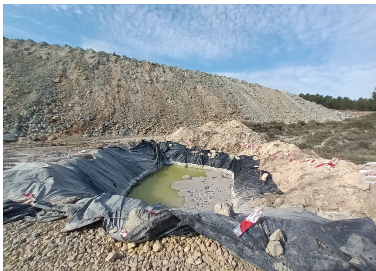
Figura 2: Zona de Lavado de cubas de CAM-01 con el plástico colocado .
