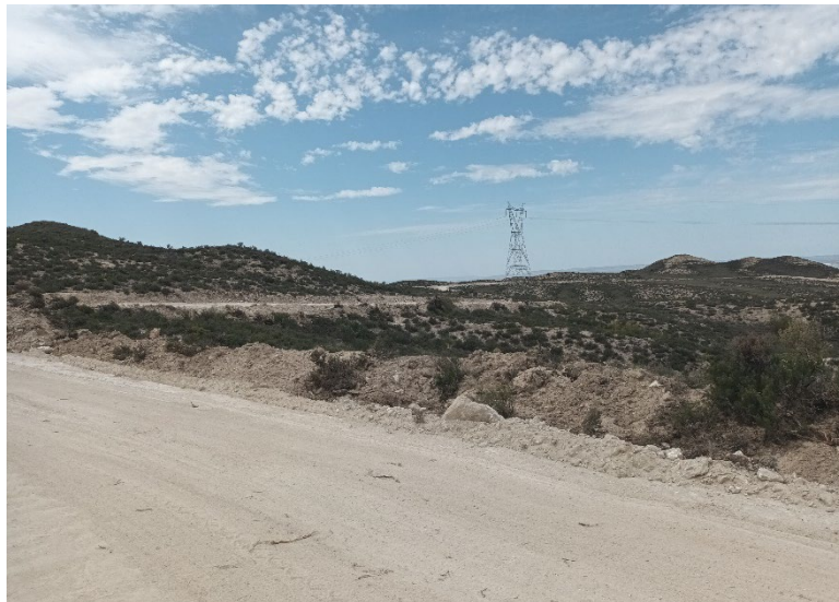
Figura 1: Desbroce y acopio tierra vegetal en la LASAT
