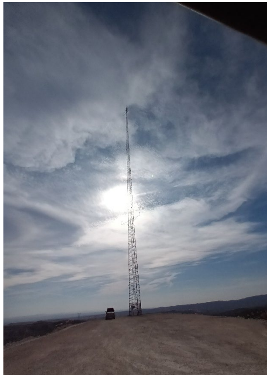
Figura 1: Torre anemométrica definitiva montada
