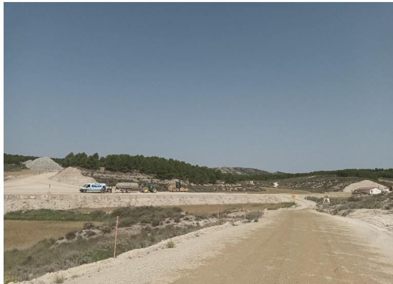
Figura 1: Evidencia de vial regado acceso a proyecto
