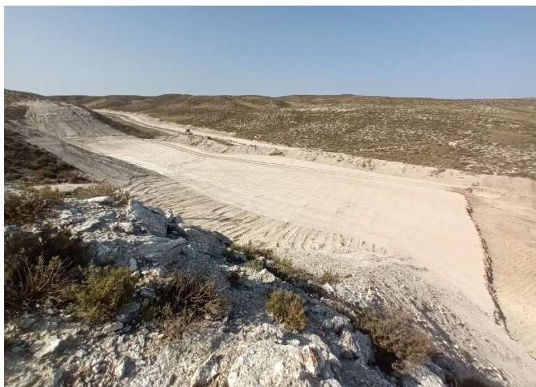
Figura 2: Avance adecuación SET CAMPILLO
