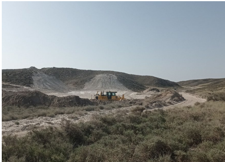
Figura 1: Desbroce e inicio de movimiento de tierras en la SET Campillo
