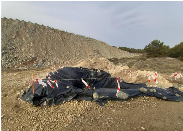
Figura 1: Zona de Lavado de cubas con impermeabilización en acceso a CAM-01.
