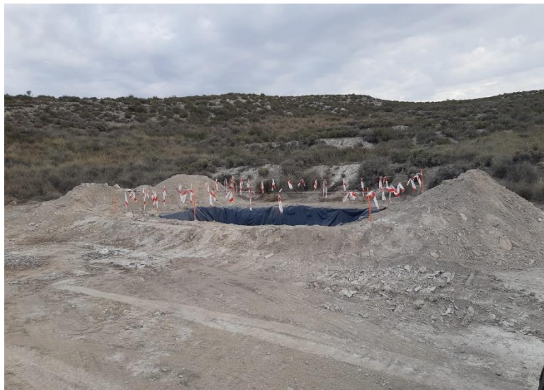
Figura 2: Zona de Lavado de cubas con impermeabilización en acceso a CAM-02.
