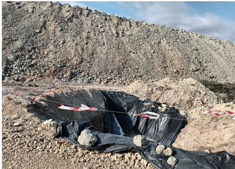
Figura 1: Zona de lavado de cubas de CAM-01 sin reparar.
