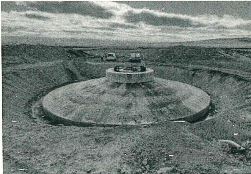
*Imagen de cimentación tipo de Aerogenerador*
