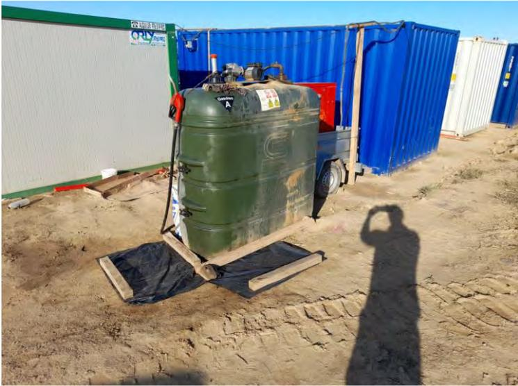
Fig. 1. Plástico antigoteo para le generador de ALOS.
