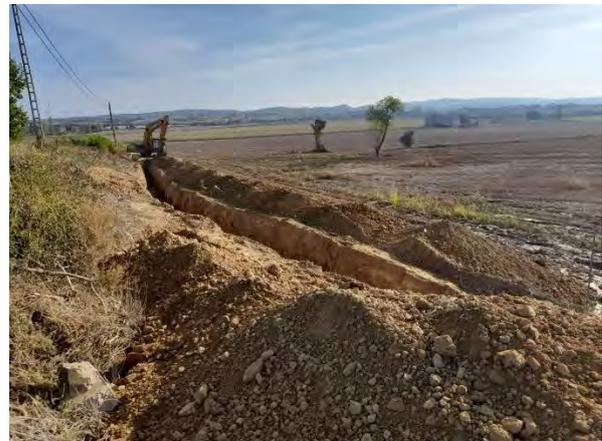
Fig. 1 Apertura de zanjas y acopios de material.
