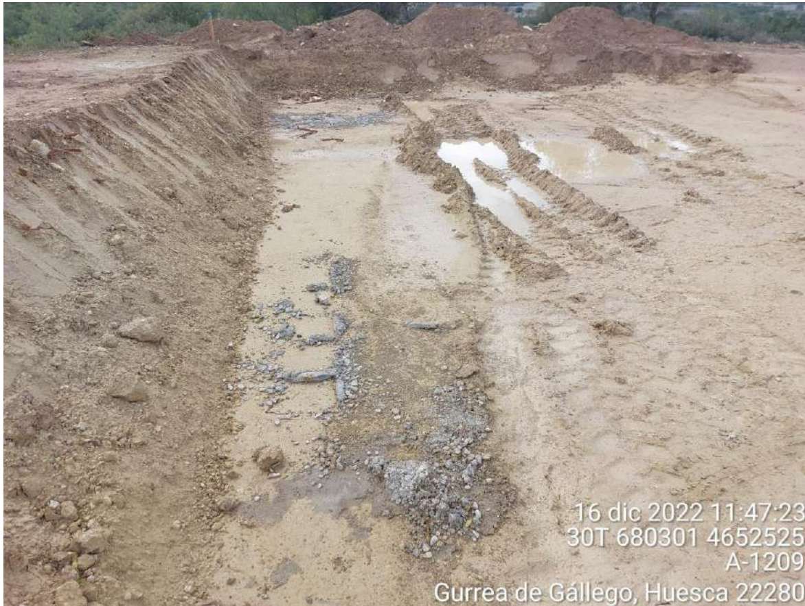
Imagen 2. Residuo de hormigón contaminando el suelo de la zona de la TM.
