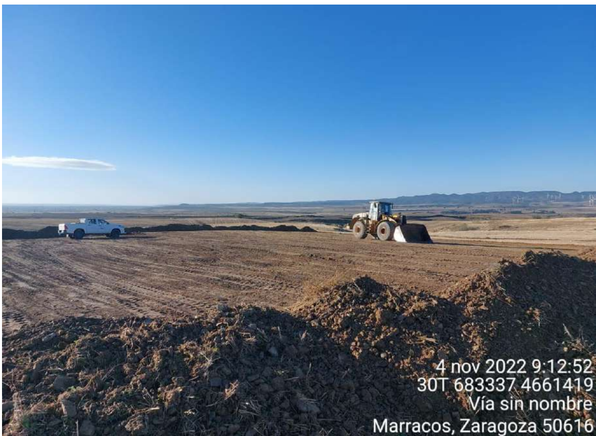
Imagen 3. Montones de tierra apilados tras trabajos de excavación en OBIII-01.
