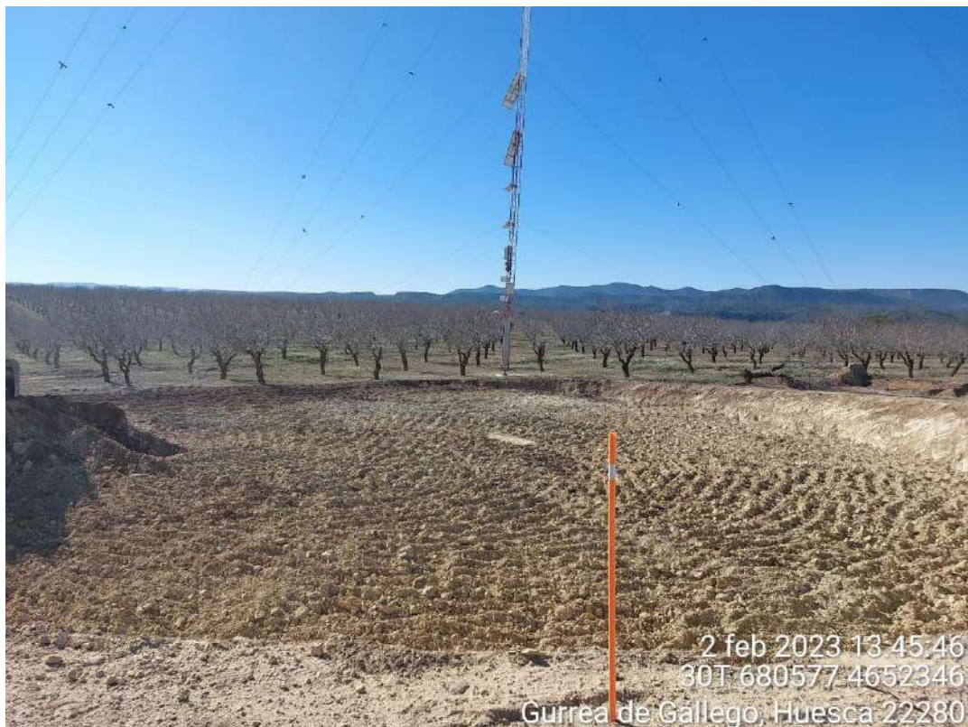
Imagen 3. Excavación en OBII.
