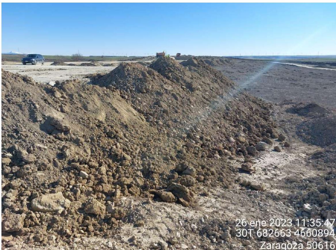
Imagen 3. Tierra vegetal acopiada en OBIII-02 que será utilizada para la restauración de ese talud.
