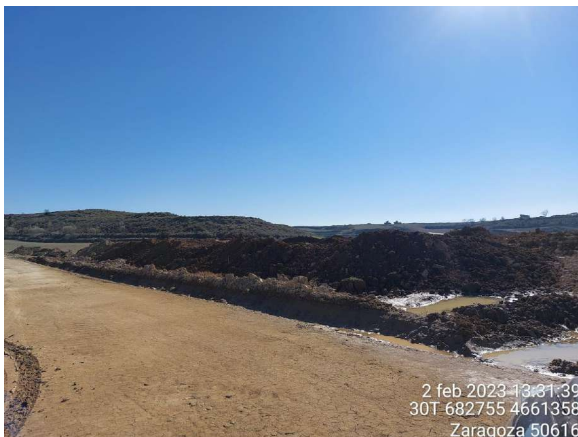
Imagen 1. Acopio de tierra vegetal realizando correctamente subsanando la NC en la TM de OBIII.
