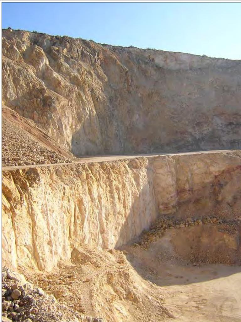
*Vista parcial del frente de explotación. Se observa la estabilidad del talud inferior de altura 20 metros con ángulo de 80°.*
