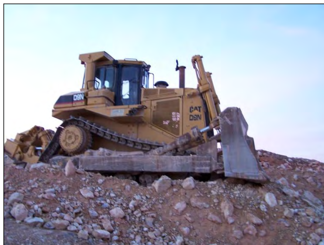
Equipo bulldozer realizando el desmante.
