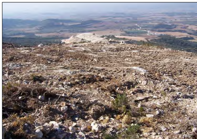
Aspecto de la superficie superior tras los trabajos de desmante.
