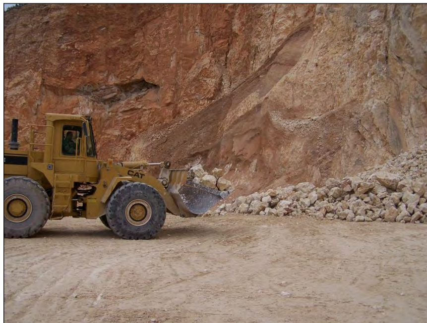
Equipo con el cazo cargado de material procedente de la voladura.
