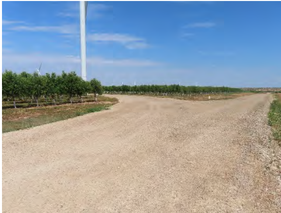
Estado tras las obras de los tramos de caminos habilitados para el acceso de vehículos especiales.
