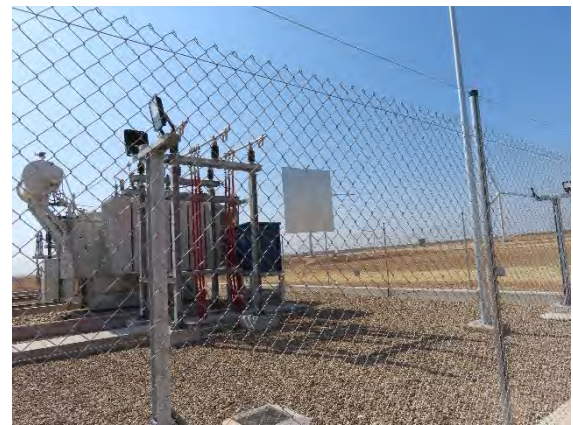
Balizas anticollisión en vallado de la SET.
