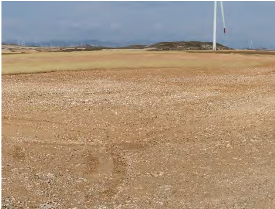
Estado tras las obras de la superficie ocupada por las instalaciones auxiliares de Margalejo-Hnos. de Pablo.
