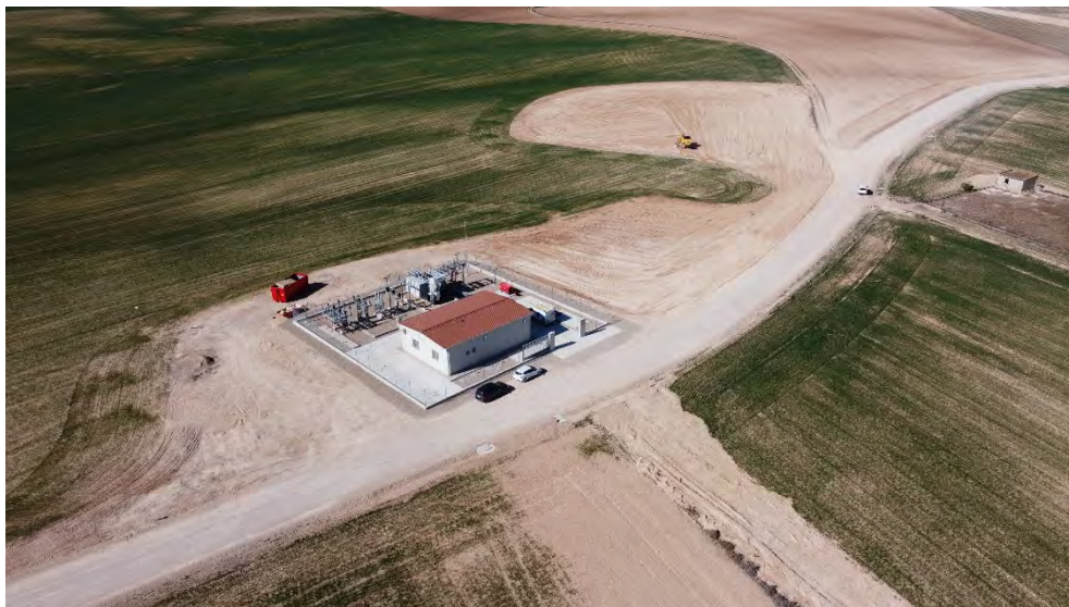
Vista aérea de la SET, instalaciones auxiliares y área de préstamo de tierras desmantelados
