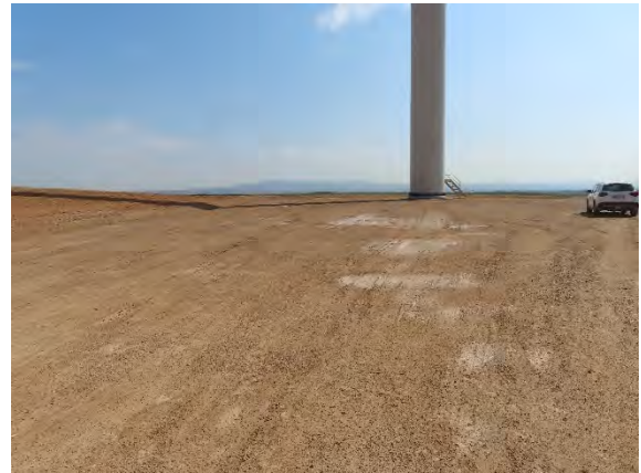
Estado tras las obras de la plataforma del aerogenerador REII-01.
