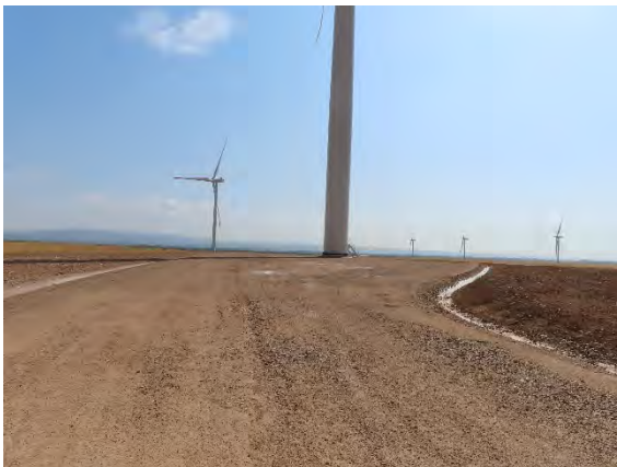
Estado tras las obras de la plataforma del aerogenerador REII-02.
