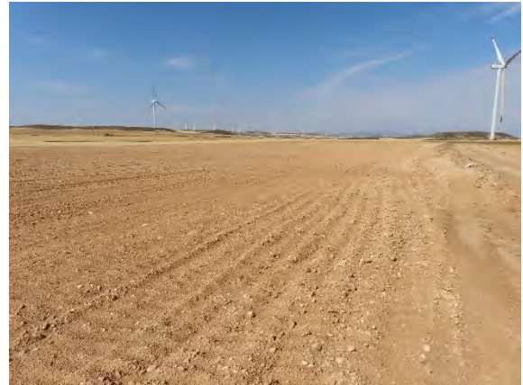
Estado tras las obras de la superficie ocupada por el préstamo de tierras.
