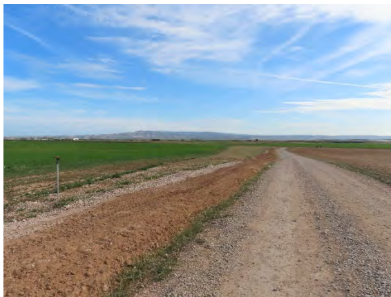
Zanja eléctrica con suelo de préstamo repuesto en superficie.
