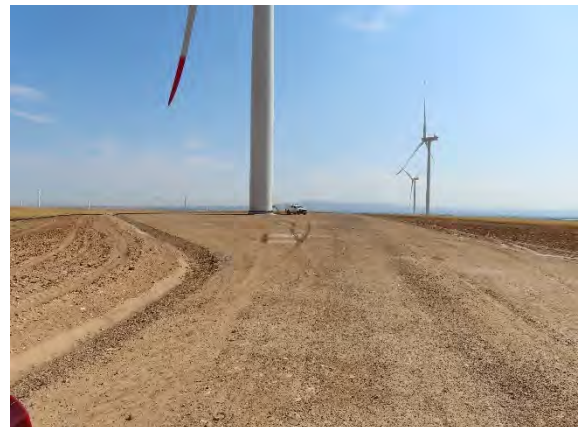
Estado tras las obras de la plataforma del aerogenerador REII-03.
