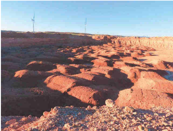
Acopios de tierras de relleno en zona de préstamo.
