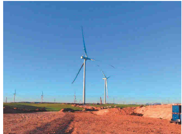
Aerogeneradores REII-02 y 03.
