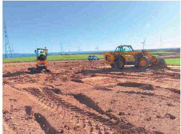
Pozo de lavado de hormigoneras desmantelado.
