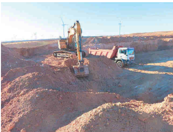
Extracción de tierras en la zona de préstamo.
