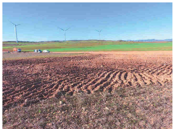
Descompactación de área de maniobra auxiliar, tras su uso.
