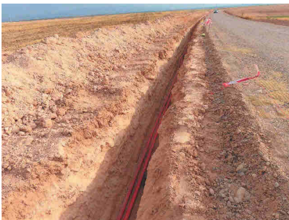
Instalación de la línea eléctrica subterránea.
