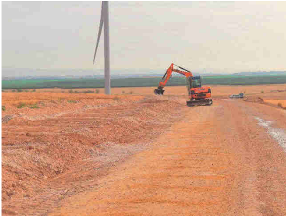
Cerrado de la zanja de la línea eléctrica subterránea.
