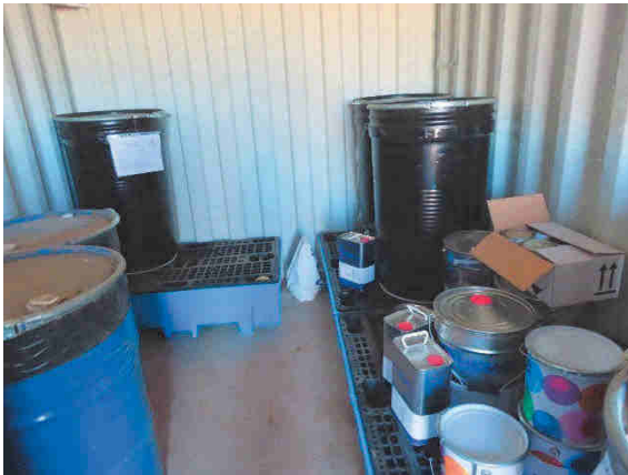
Cubetos antivertido en punto limpio de Siemens-Gamesa.
