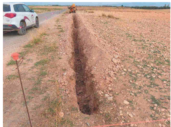
Zanja abierta en terreno de roca con zanjadora
