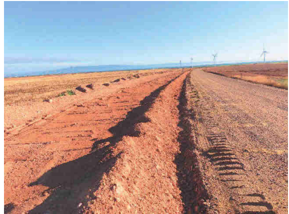
Cerrado de la zanja de la línea eléctrica subterránea.
