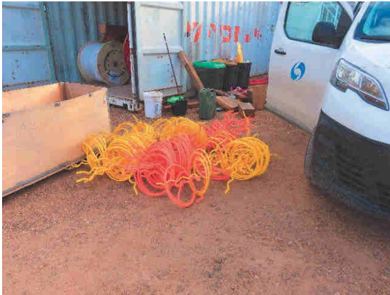
Espirales para balizar la línea eléctrica.
