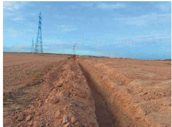
Zanja abierta en el tramo modificado.
