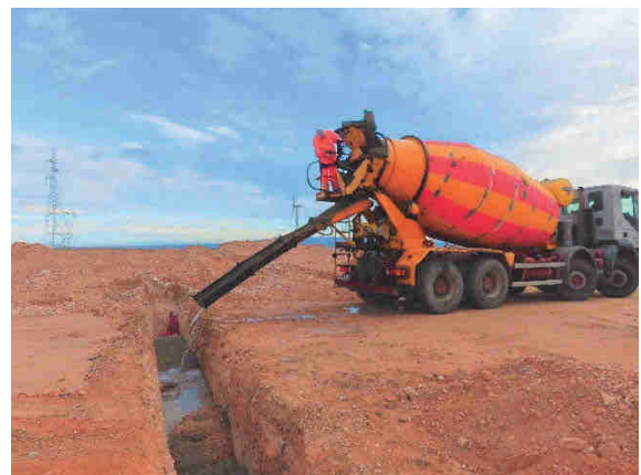
Lavado de la canaleta sobre la propia zanja
