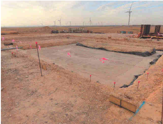
Fases iniciales construcción de la SET.
