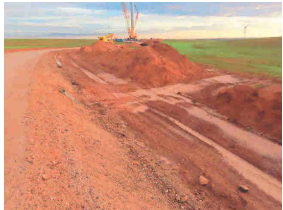
Drenaje adicional construido tras lluvias de agosto.
