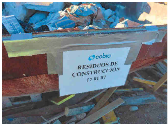
Contenedor de residuos de construcción en punto limpio de Cobra.
