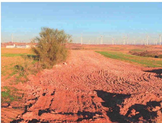
Zanja modificada una vez cerrada.
