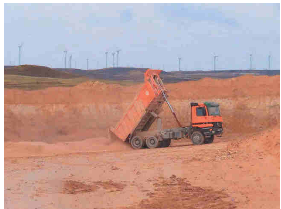
Aporte de tierras de relleno en la zona de préstamo.
