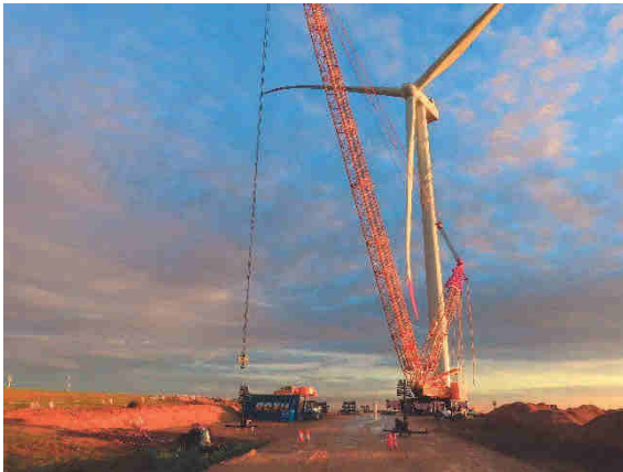
Instalación del aerogenerador REII-03.
