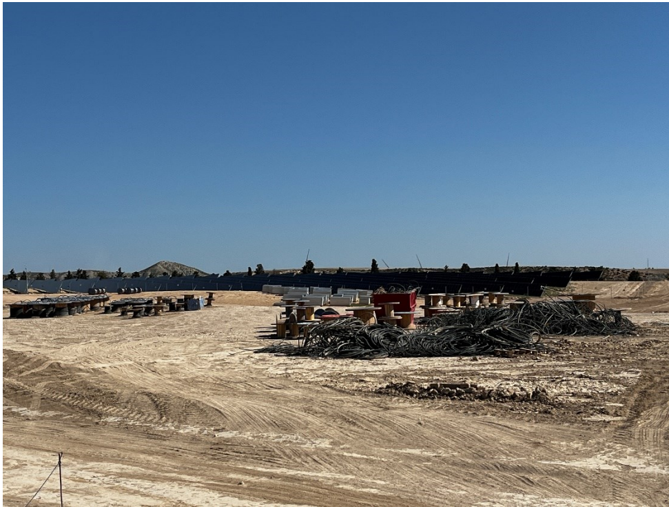
Figura 6 Acopio del material de construcción
