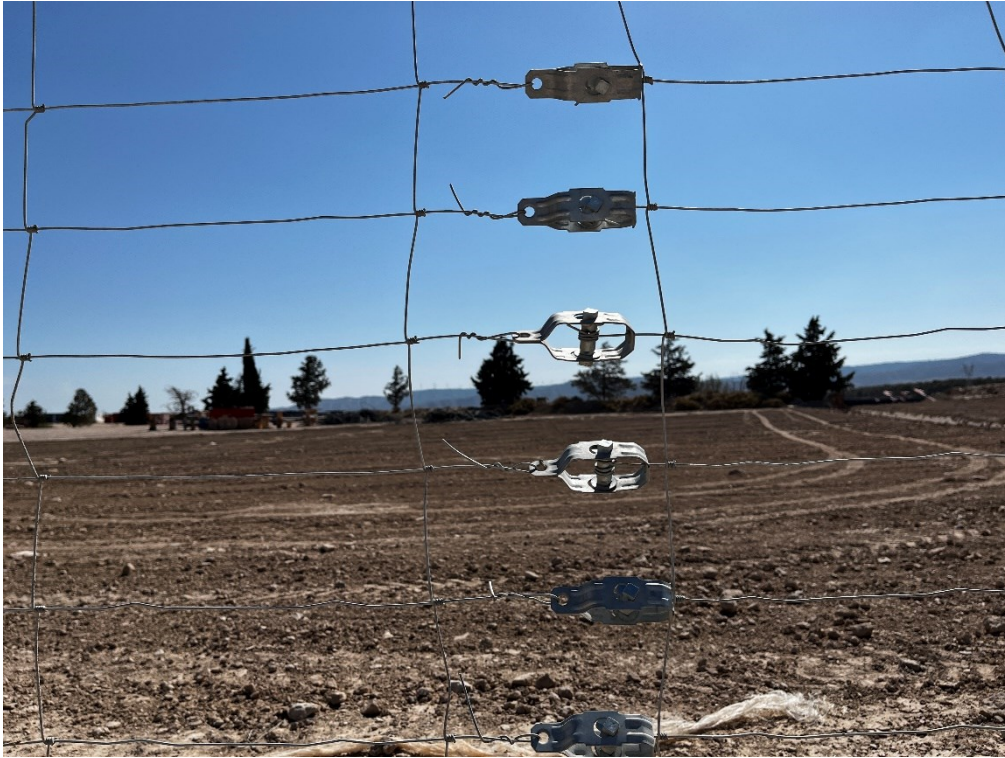
Figura 7 Elementos punzantes en el vallado perimetral
