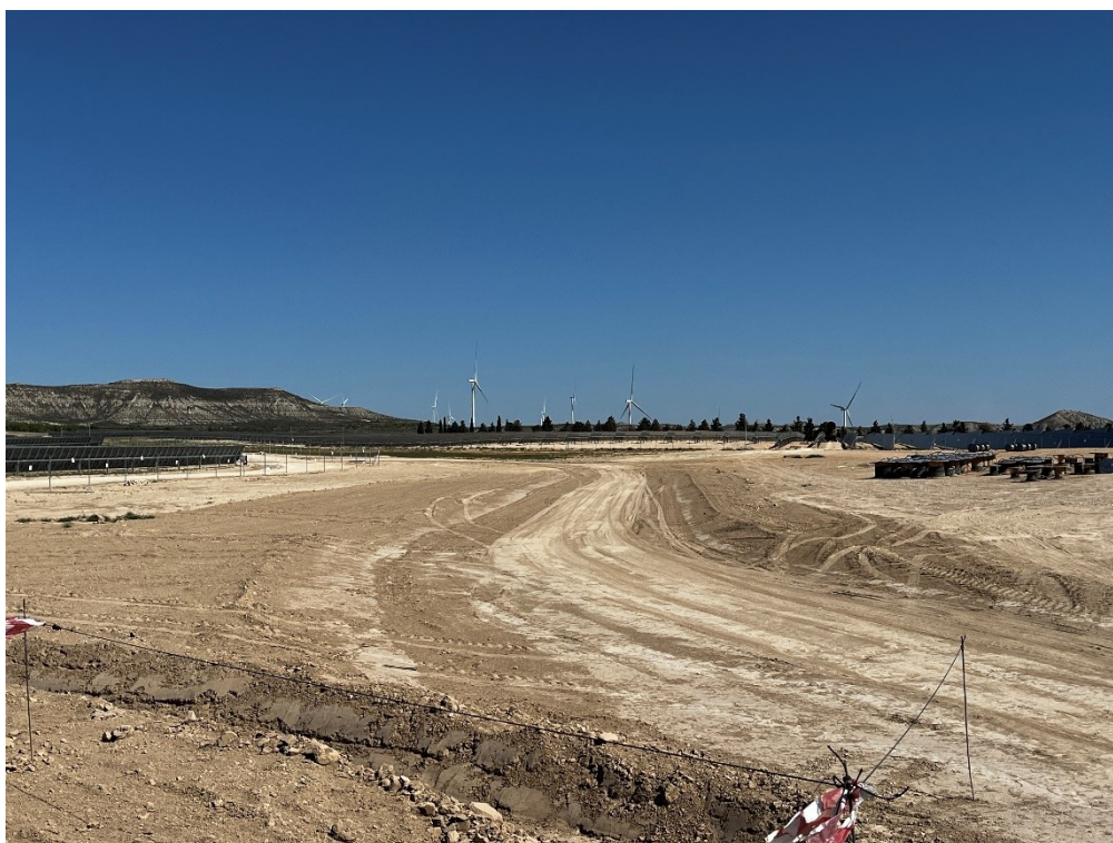
Figura 2 Apertura del canal de drenaje
