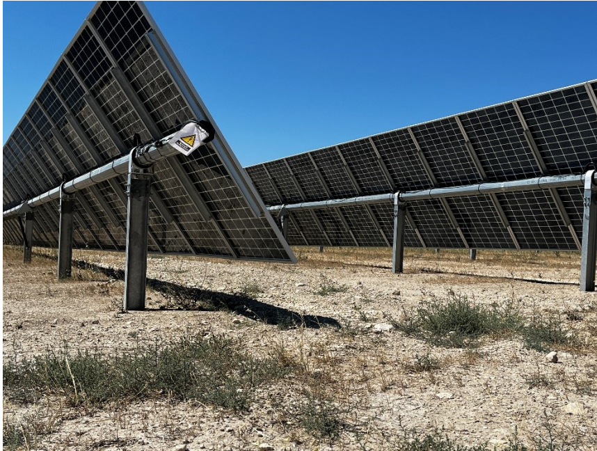
Figura 3 Montaje de los módulos
