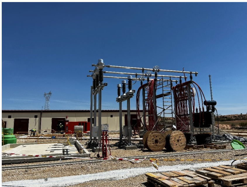
Figura 3 Trabajos de la SET
