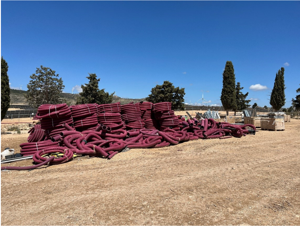
Figura 8 Acopio del material de construcción
