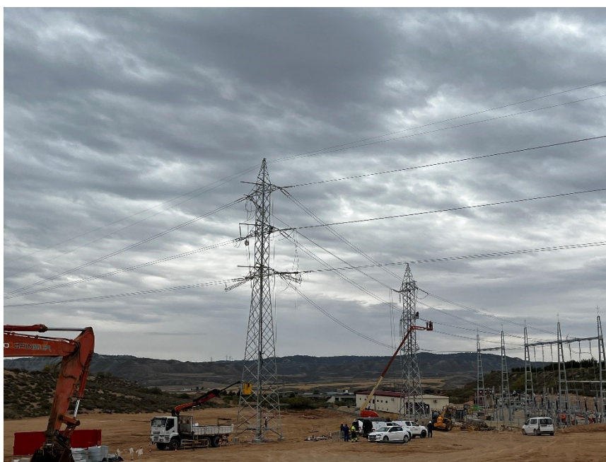
Figura 4 Izado del apoyo para la evacuación de la SET
