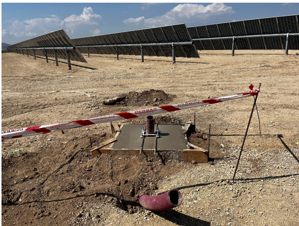
Figura 2 Cimentación de los postes del CCTV
