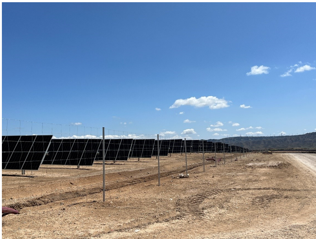
Figura 6 Vallado perimetral sin placas esteparias
