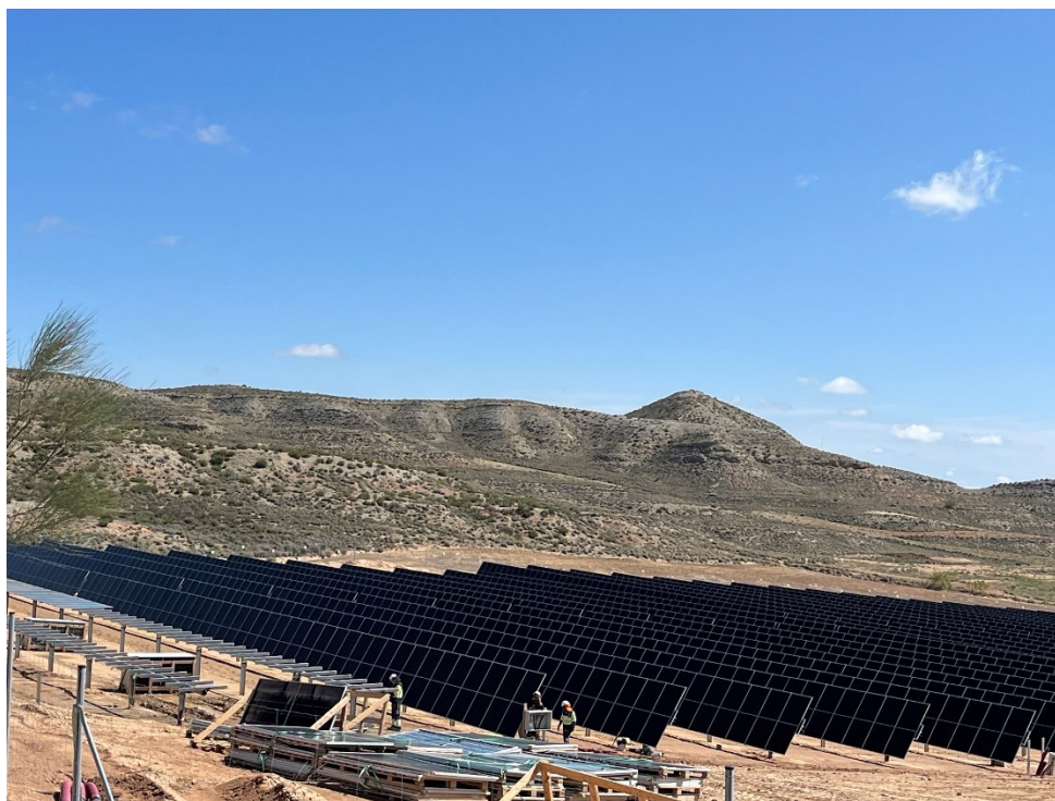
Figura 7 Montaje de los módulos fotovoltaicos
