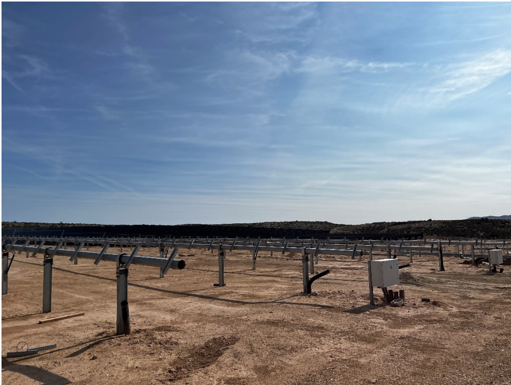
Figura 10 Montaje de los trackers
