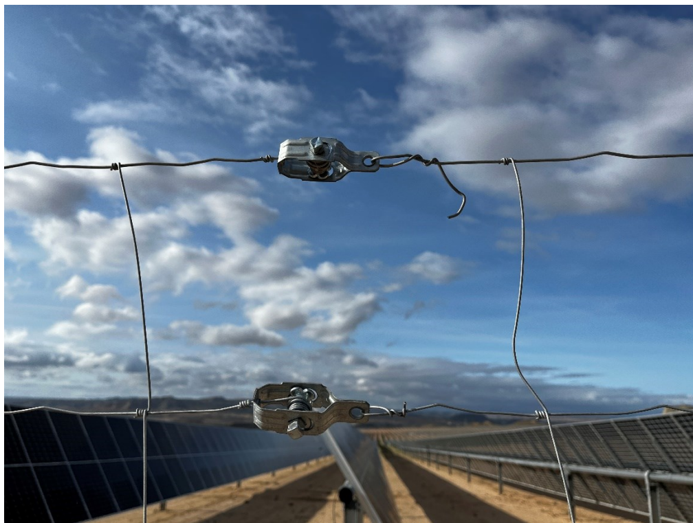
Figura 11 Elementos punzantes en el vallado perimetral
