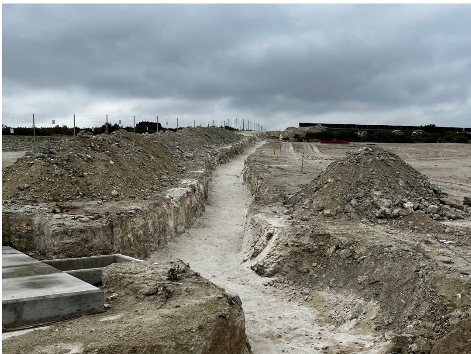
Figura 11 Apertura de zanjas para la red de evacuación
