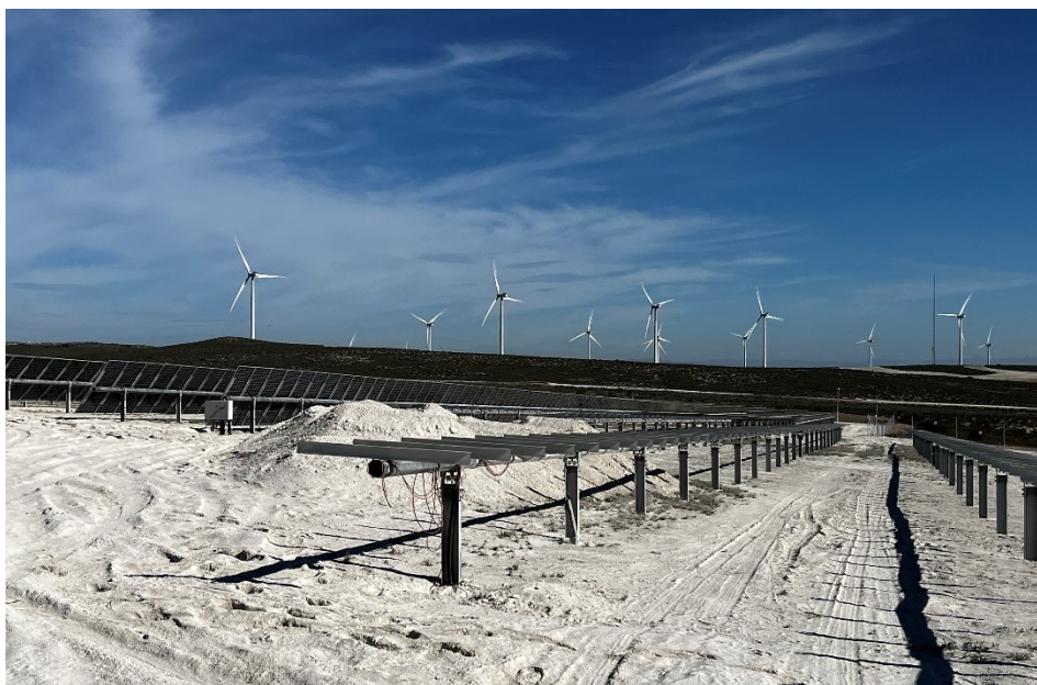
Figura 8 Montaje de los trackers
