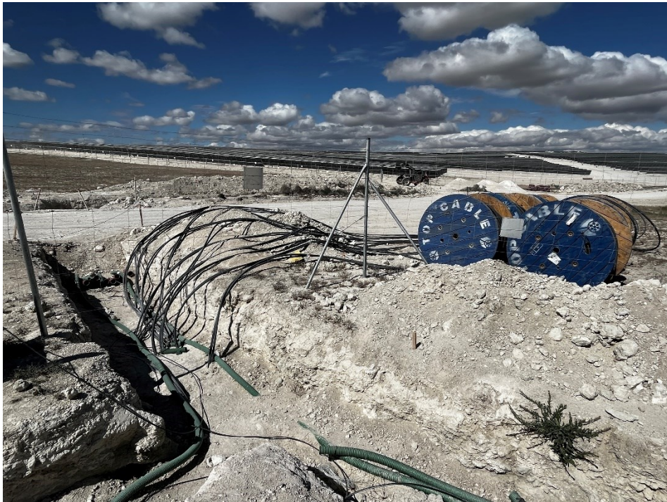
Figura 10 Cableado de la red de evacuación
