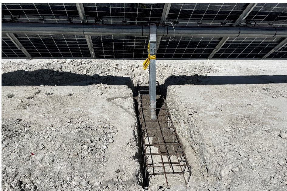
Figura 9 Cimentación de las hincas rechazadas
