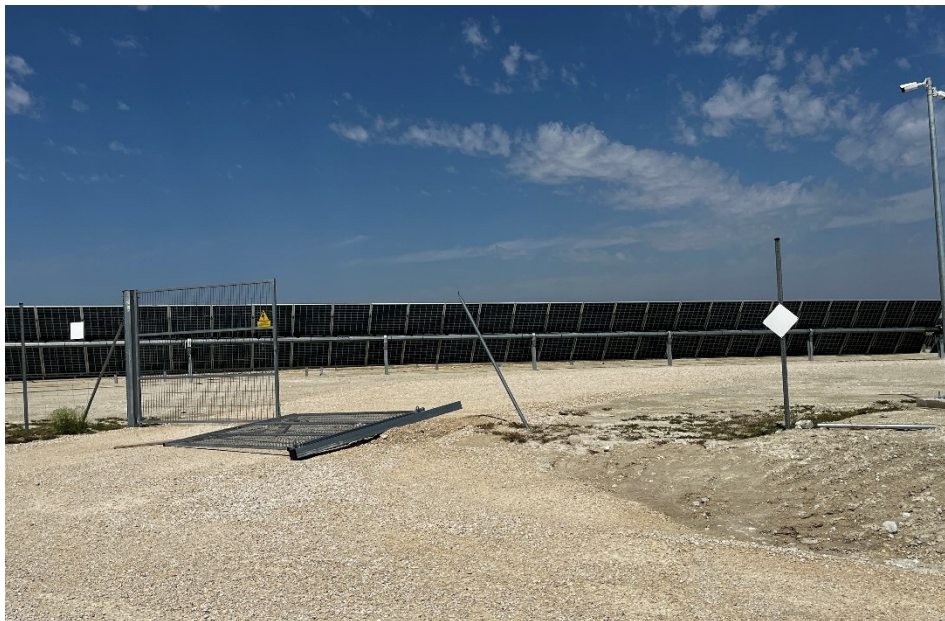
Figura 8 Montaje de las puertas de entrada
