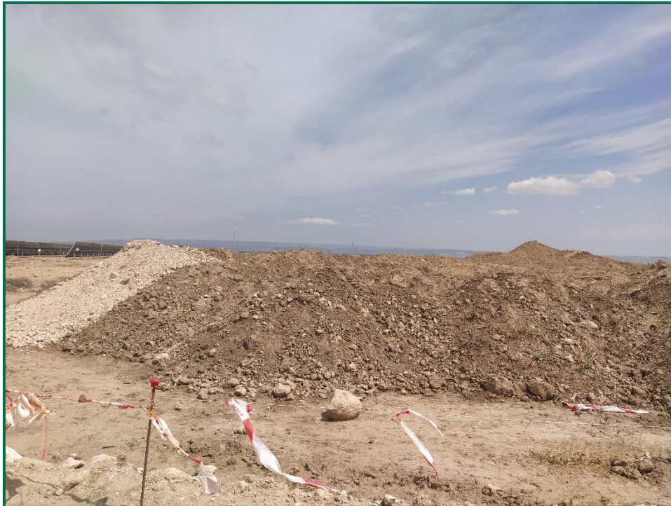
Fotografía 4. Acopio de tierra.
