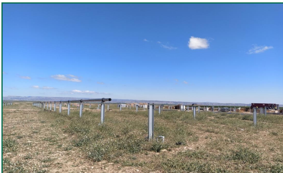
Fotografía 5. Hincas sobre el terreno.
