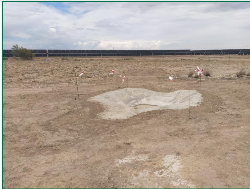
Fotografía 7. Balsete ya construido.
