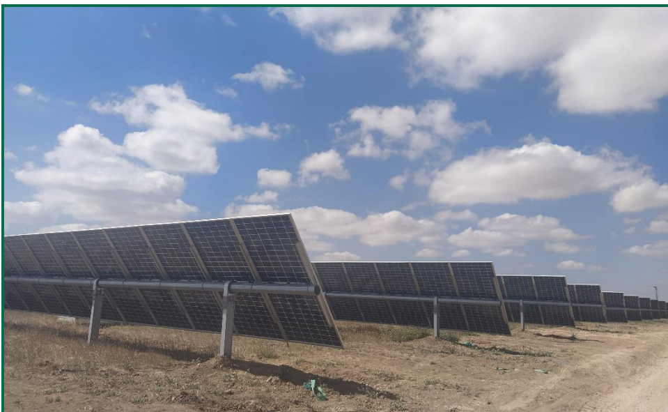
Fotografía 5. Hincas sobre el terreno.
