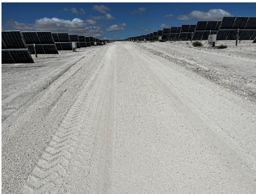
Figura 2 Restauración de los viales
