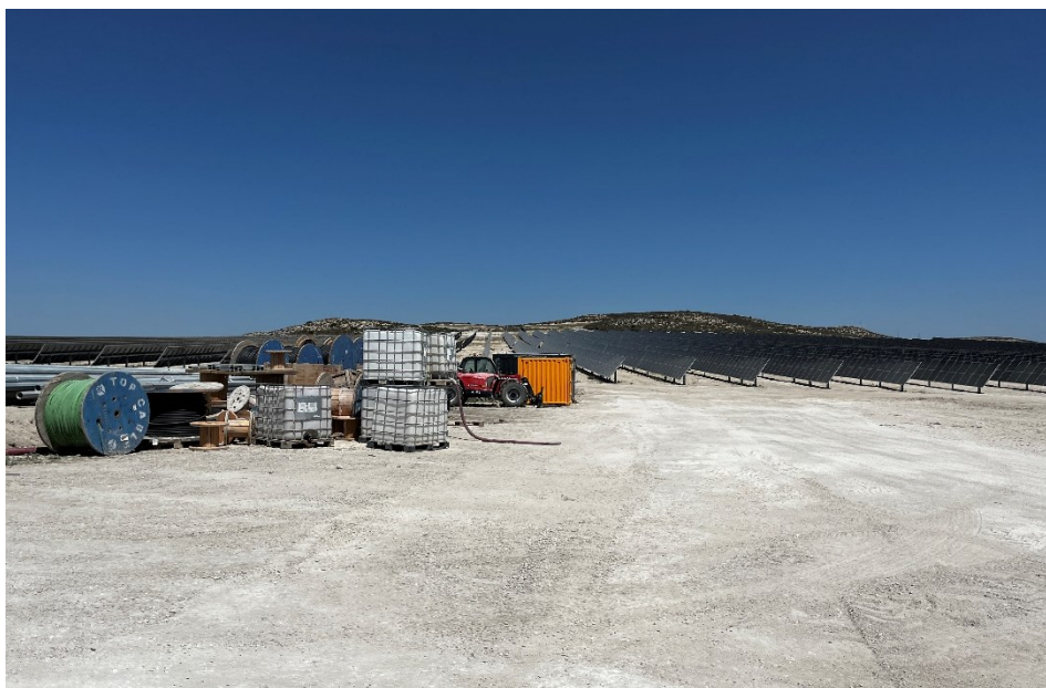
Figura 7 Acopio del material de construcción
