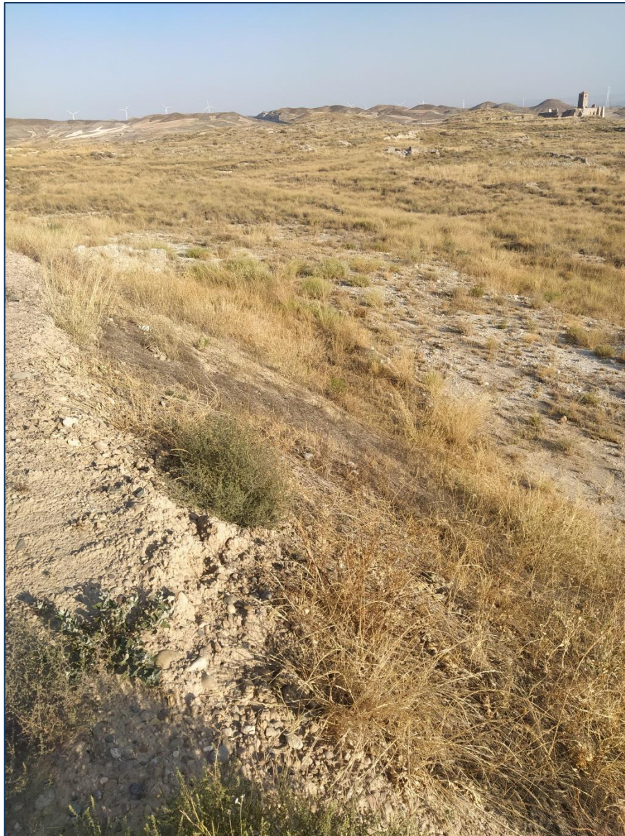
Fotografía1. Revegetación en talud.
