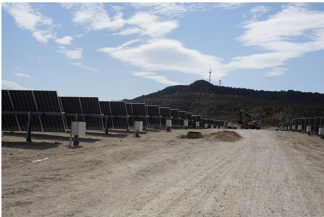
Figura 2a Ejecución de arquetas para red eléctrica en Vallobar
