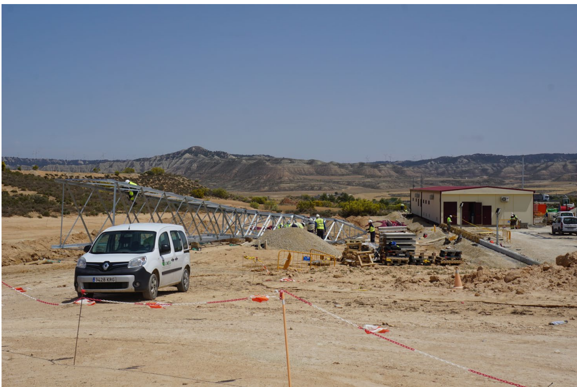
Figura 9 Operarios montando torre eléctrica junto a subestación "Vallobar"
