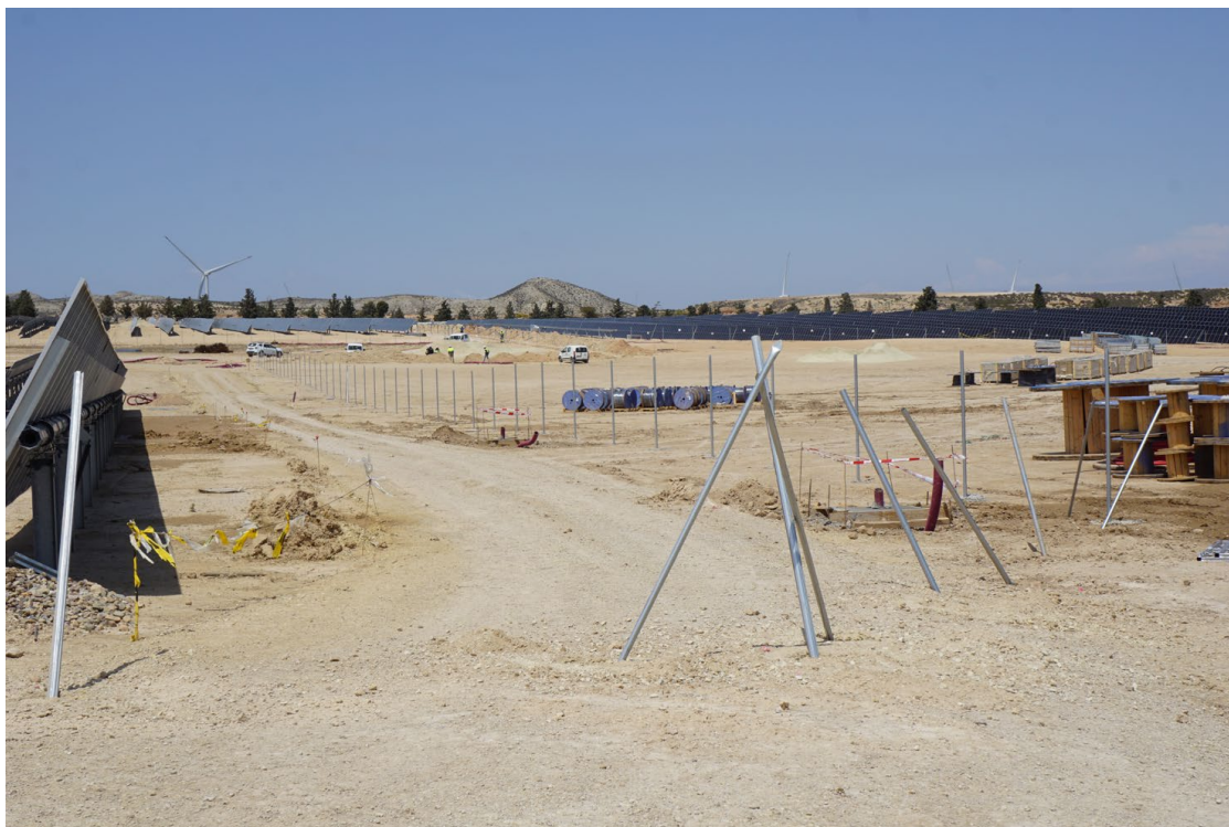
Figura 4 Ejecución de nuevos tramos de vallado
