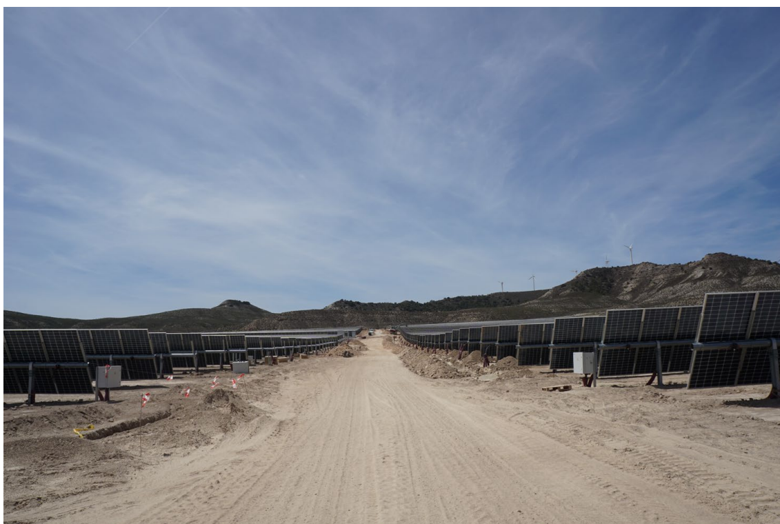
Figura 5 Zanjas abiertas para instalación de conducciones eléctricas
